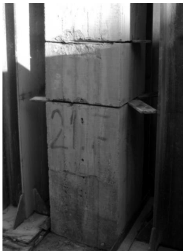
Σχήμα 2.6: Κοπή υπάρχοντος υποστυλώματος (Παπανίκος, 2009)
