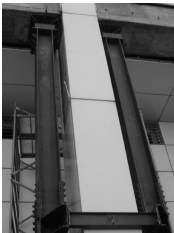
Σχήμα 2.5: Τοποθέτηση προσωρινών υποστυλωμάτων (Παπανίκος, 2009)
