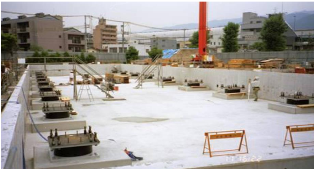
Σχήμα 2.11: Θέσεις εφεδρανών στη βάση των δομικών στοιχείων χωρίς υπόγειο (Λιώρης, 2013)
