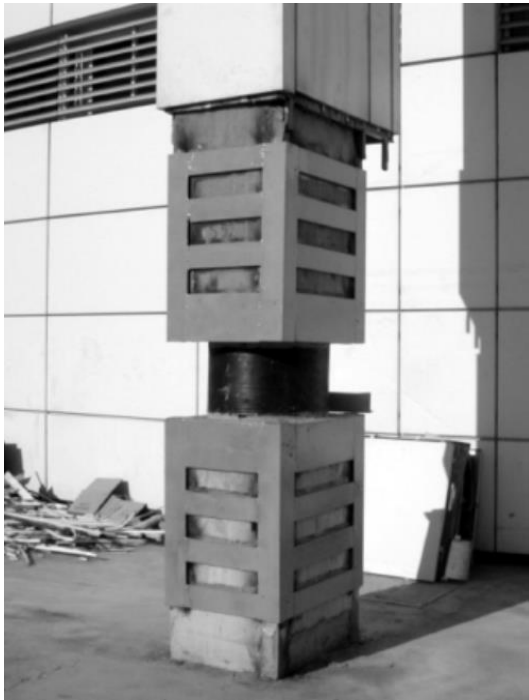
Σχήμα 2.7: Χαλύβδινες επενδύσεις που αντικαθιστούν τις ράβδους οπλισμού (Παπανίκος, 2009)
