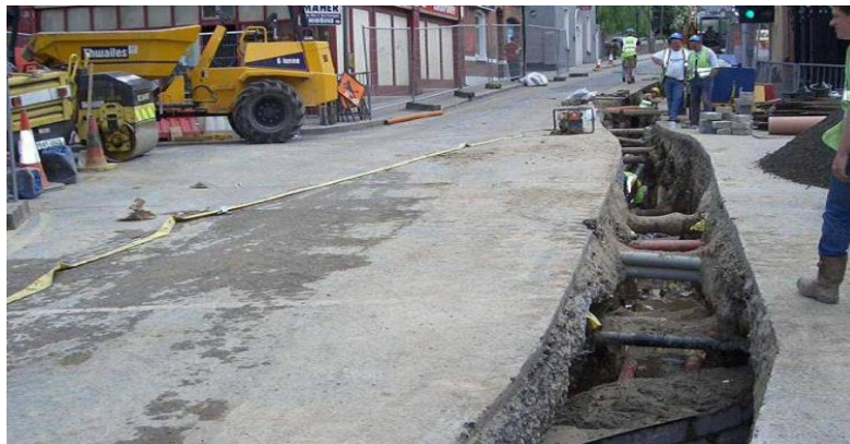
Σχήμα 2.4- Εγκατάσταση καλωδίου 110kV σε αστικό δρόμο[10]
