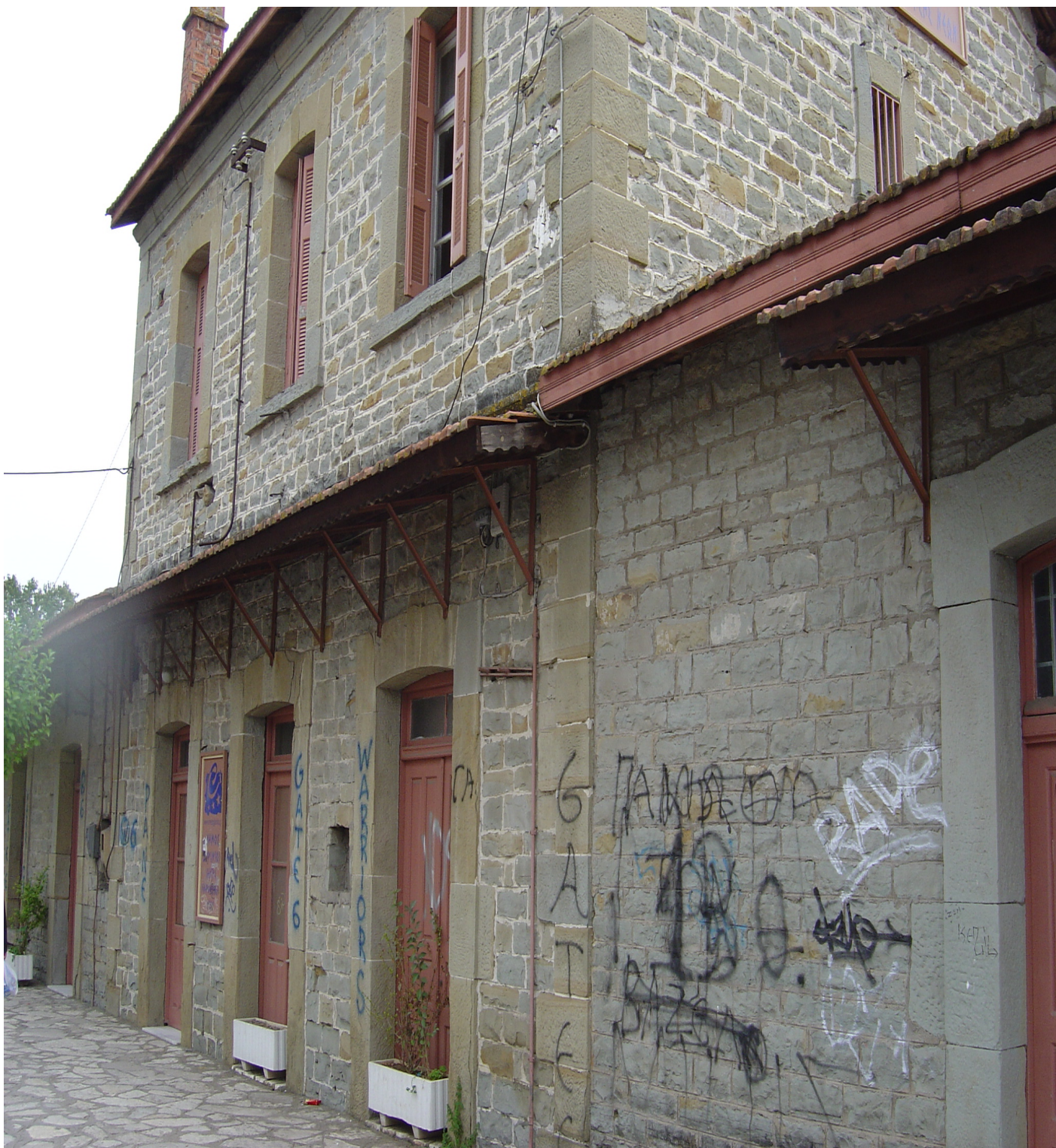
(φωτογραφία 29) σημερινή είσοδος του σταθμού
