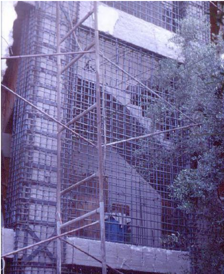
Σχήμα 2.13: Προσθήκη τοιχώματος και ενίσχυση υποστυλωμάτων. (Αίγιο 1995) (Λίτσος, 2012)
