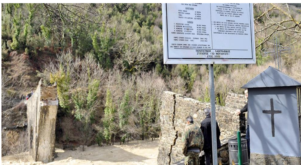
Εικόνα 18 Είναι επιτακτικής ανάγκης οι εργασίες αναστήλωσης του ιστορικού Γεφυριού
