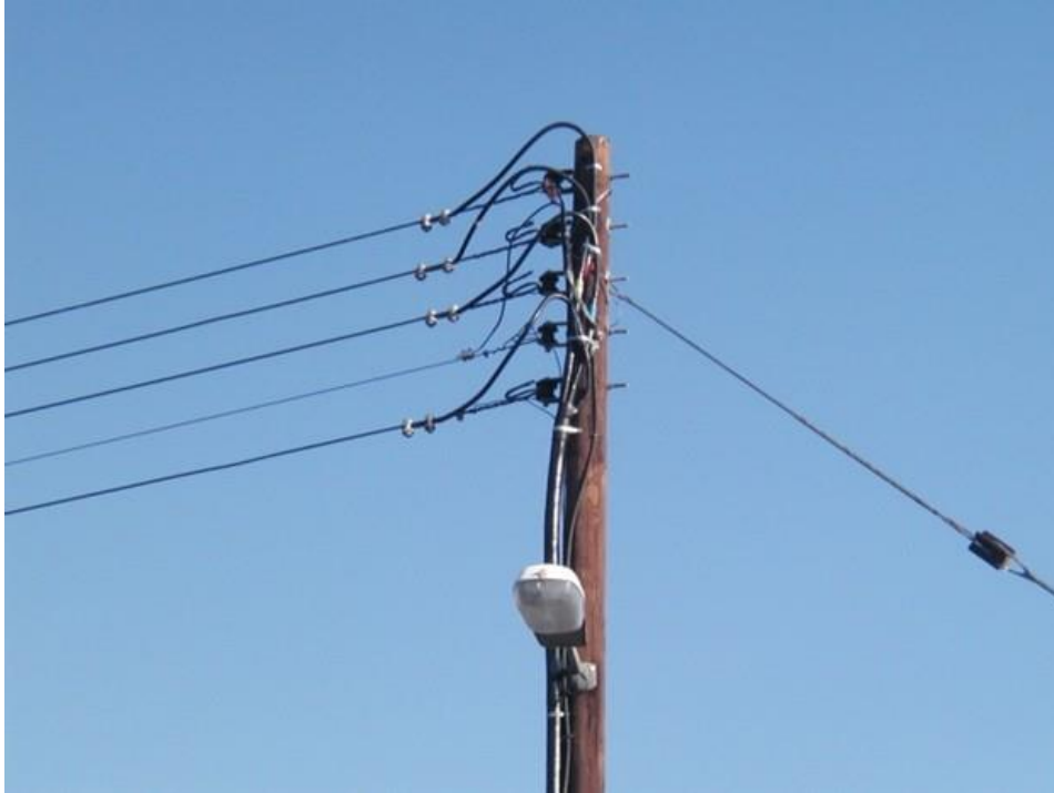
Εικόνα 8 Τυπική διάταξη χαμηλής τάσης επί ξύλινου στύλου
