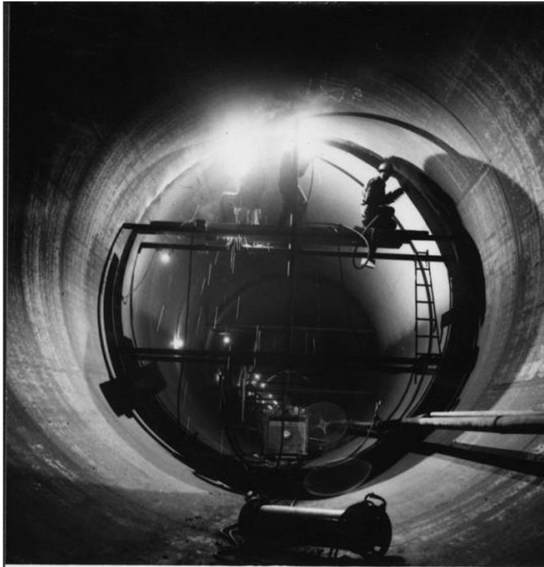
Εικόνα 11 Εργοτάξιο Υδροηλεκτρικού Σταθμού Κρεμαστών, 1965 (ΔΕΗ, 2011)
