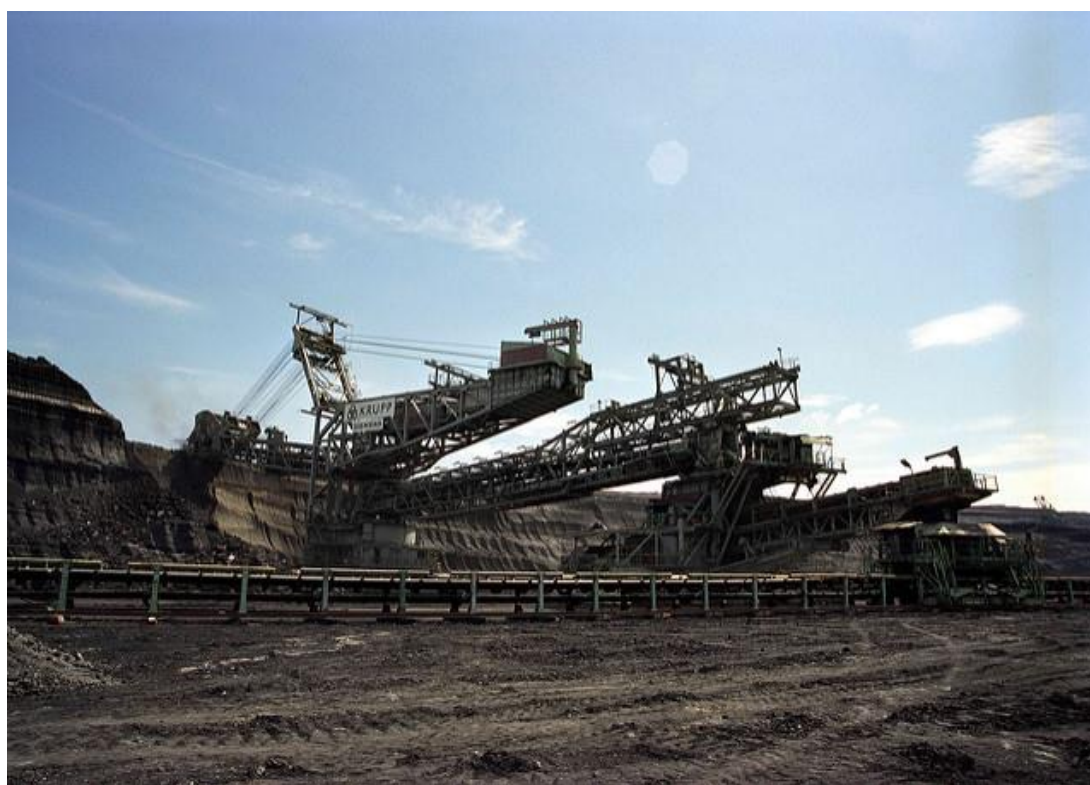
Εικόνα 3 Λιγνιτικό κέντρο Δυτικής Μακεδονίας - Ορυχείο Νότιου Πεδίου (ΔΕΗ, 2010)
