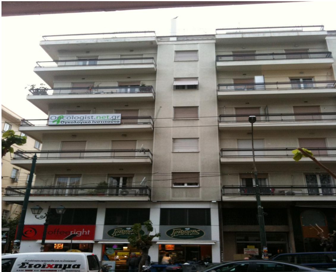
Εικόνα 10. Όψη παρακείμενου κτηρίου.
