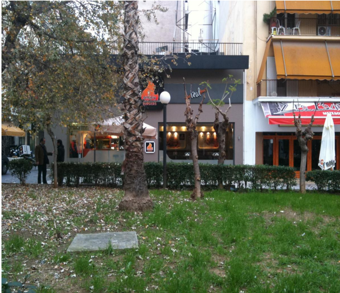
Εικόνα 7. Όψη παρακείμενου κτηρίου.
