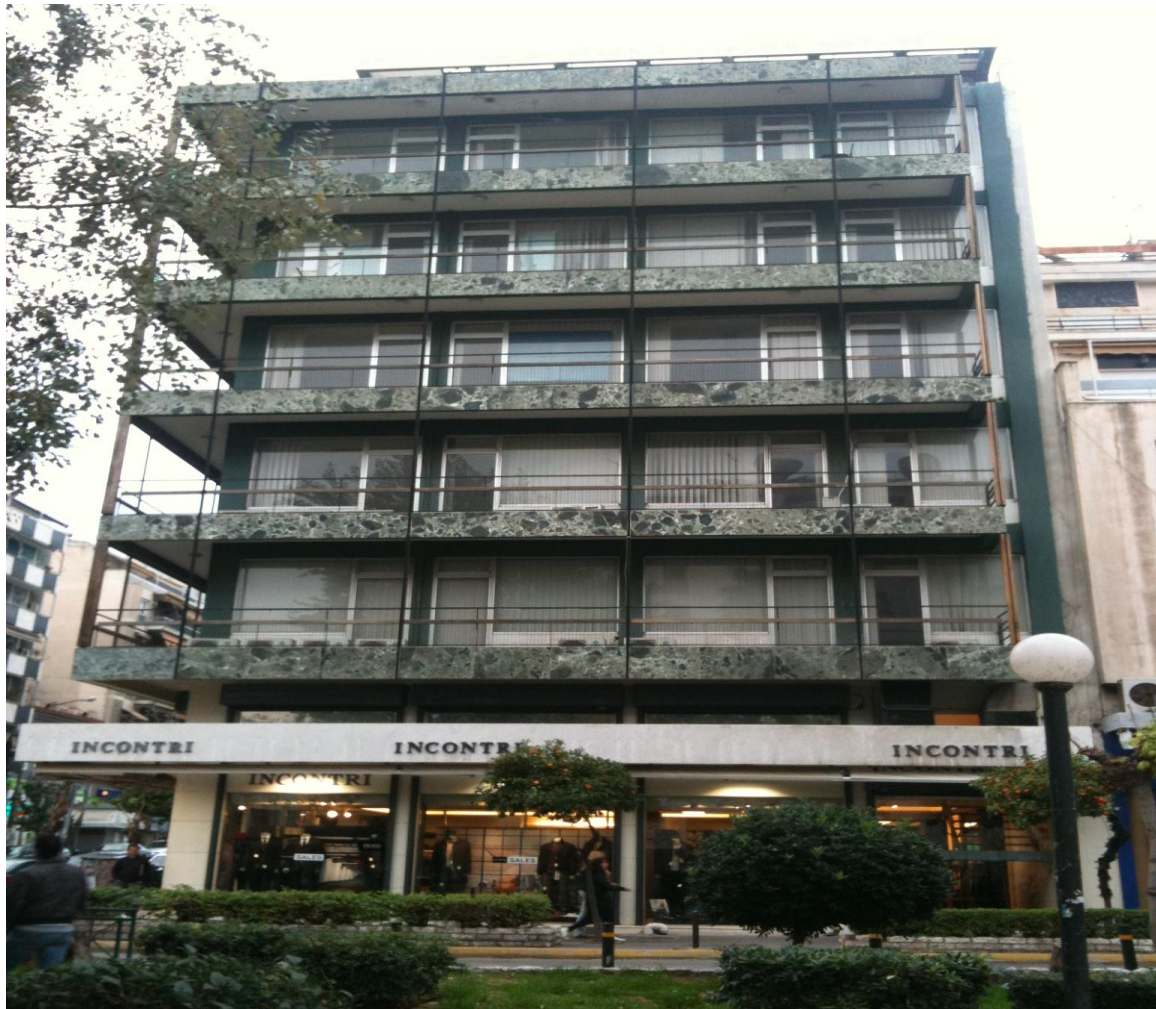
Εικόνα 8. Όψη παρακείμενου κτηρίου.
