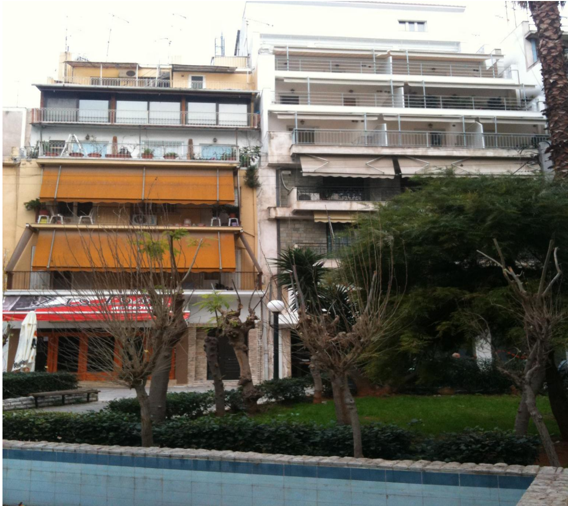
Εικόνα 6. Όψη παρακείμενου κτηρίου.
