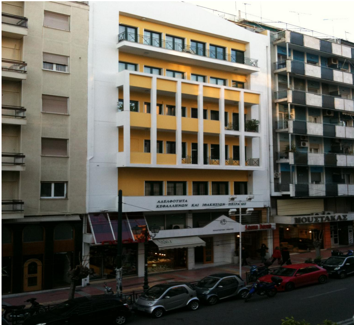
Εικόνα 11. Όψη παρακείμενου κτηρίου.
