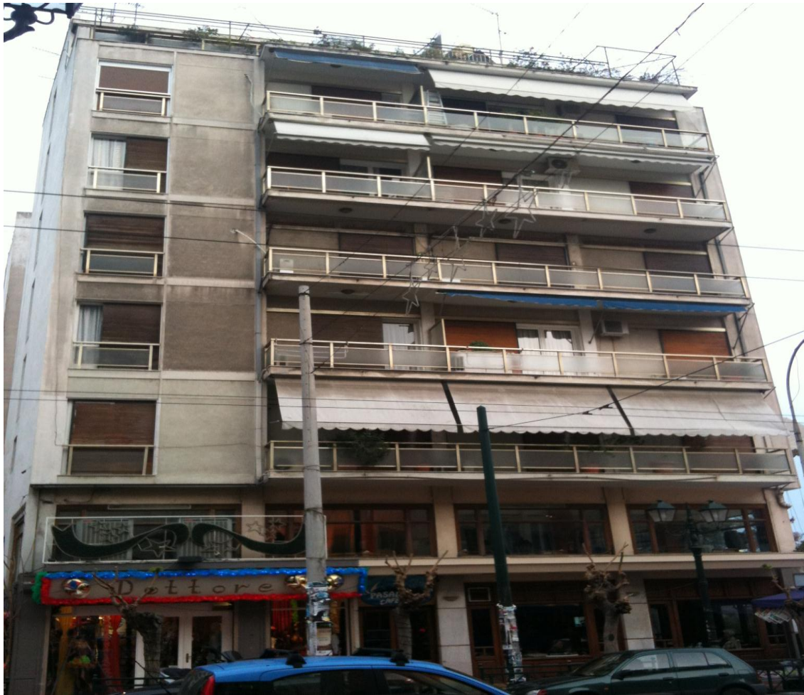
Εικόνα 12. Όψη παρακείμενου κτηρίου.
