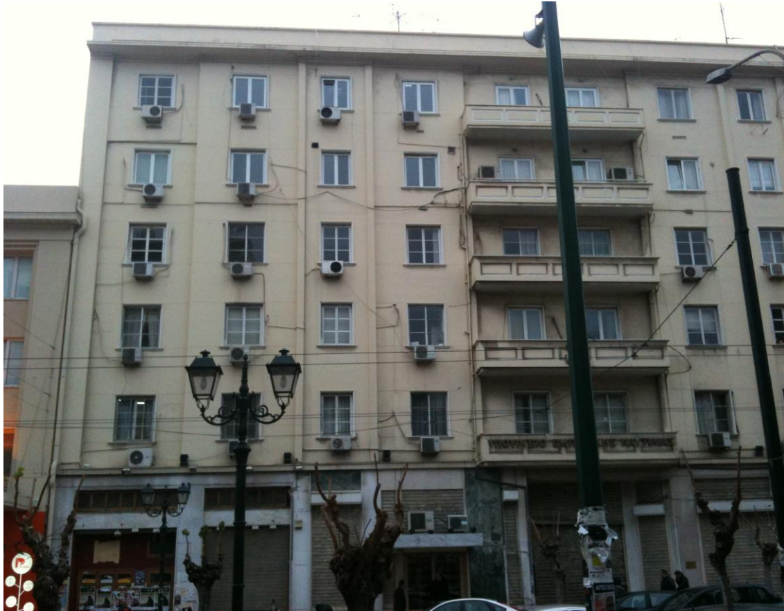
Εικόνα 9. Όψη παρακείμενου κτηρίου.
