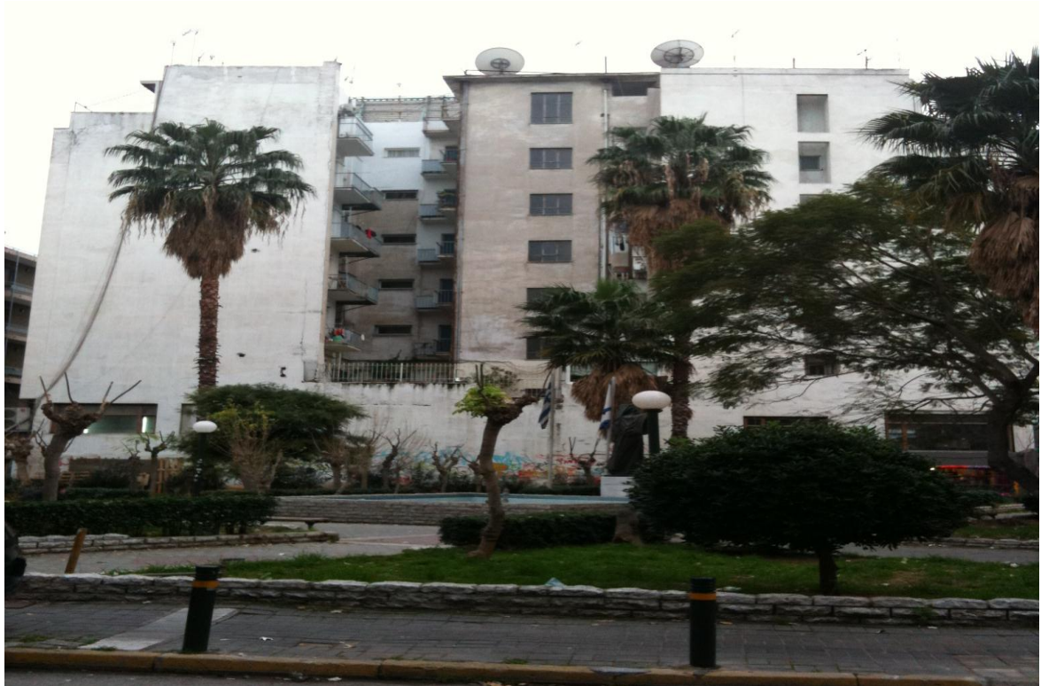
Εικόνα 5. Όψη παρακείμενου κτηρίου.
