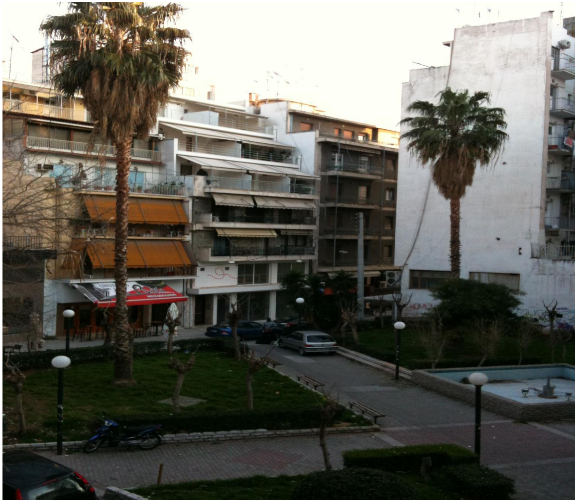
Εικόνα 13. Όψη παρακείμενου κτηρίου.
