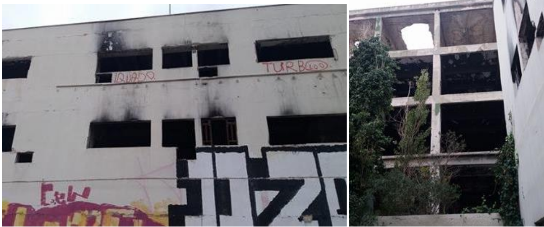
Εικόνα 19 Η υφιστάμενη κατάσταση του εργοστασίου
