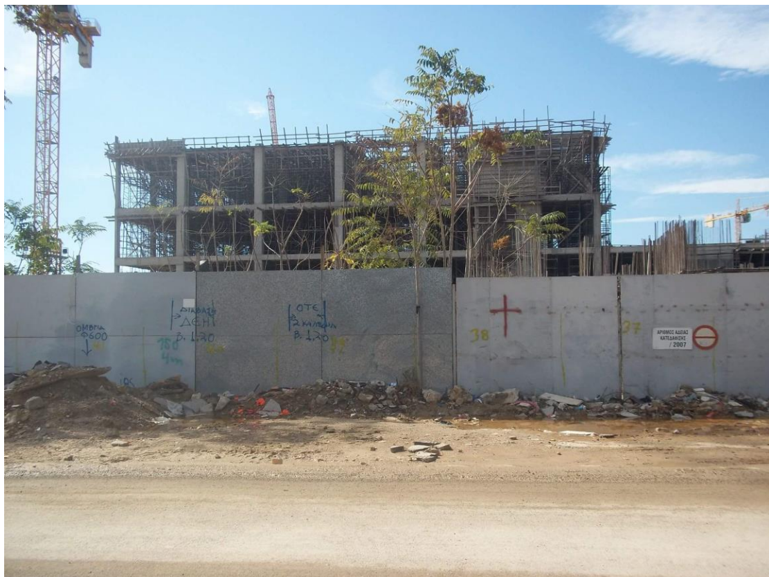
Εικόνα 30 Ύπαρξη ρίπων και μπαζών κοντά σε βιομηχανική μονάδα επί της οδού Αγ. Άννης
