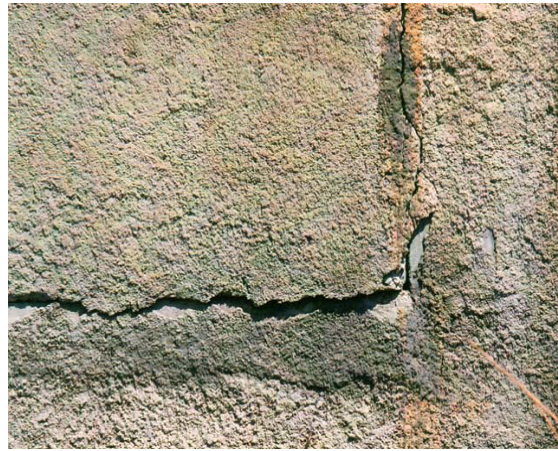
Αποκολλήσεις ΦΟ και ΟΠ, μετακινήσεις ~ 25 mm στο κάτω μέρος των τοίχων.
