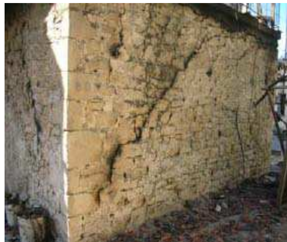
Έντονη διαμητρική ρηγμάτωση καλοχτισμένων πεσσών σε γωνία, λάκτισμα πλάκας οροφής.
