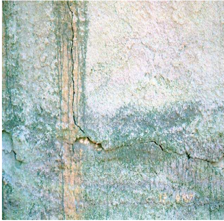
Αποκολλήσεις ΦΟ και ΟΠ, μετακινήσεις ~ 25 mm στο κάτω μέρος των τοίχων.
