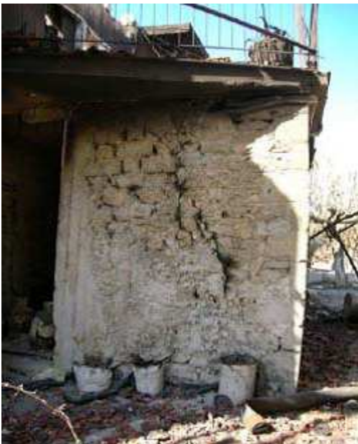
Έντονη διαμητρική ρηγμάτωση καλοχτισμένων πεσσών σε γωνία, λάκτισμα πλάκας οροφής.
