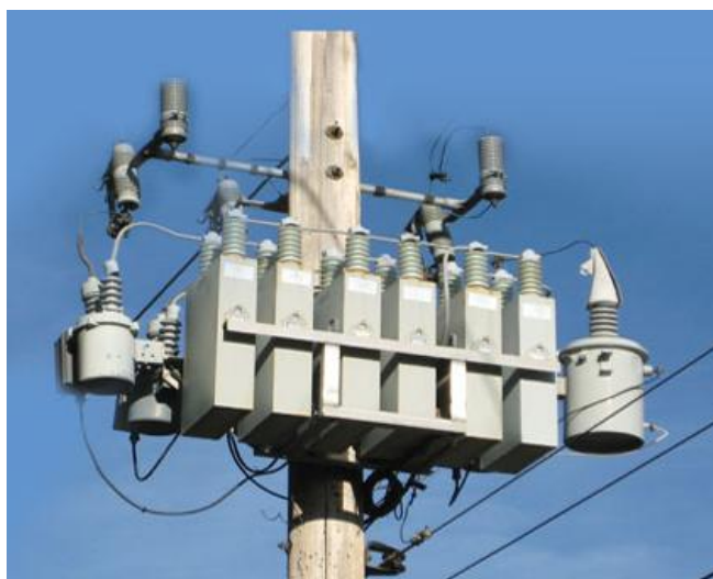
Σχήμα 4.12 - Αποζεύξιμη τράπεζα πυκνωτών αναρτημένη σε στύλο διανομής XT
