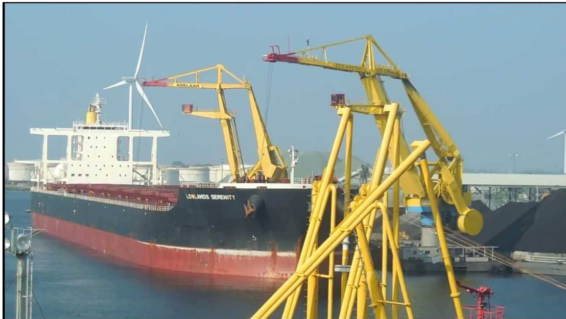
Εικόνα 1 : Σύστημα φόρτωσης εκφόρτωση Πηγή Internet
