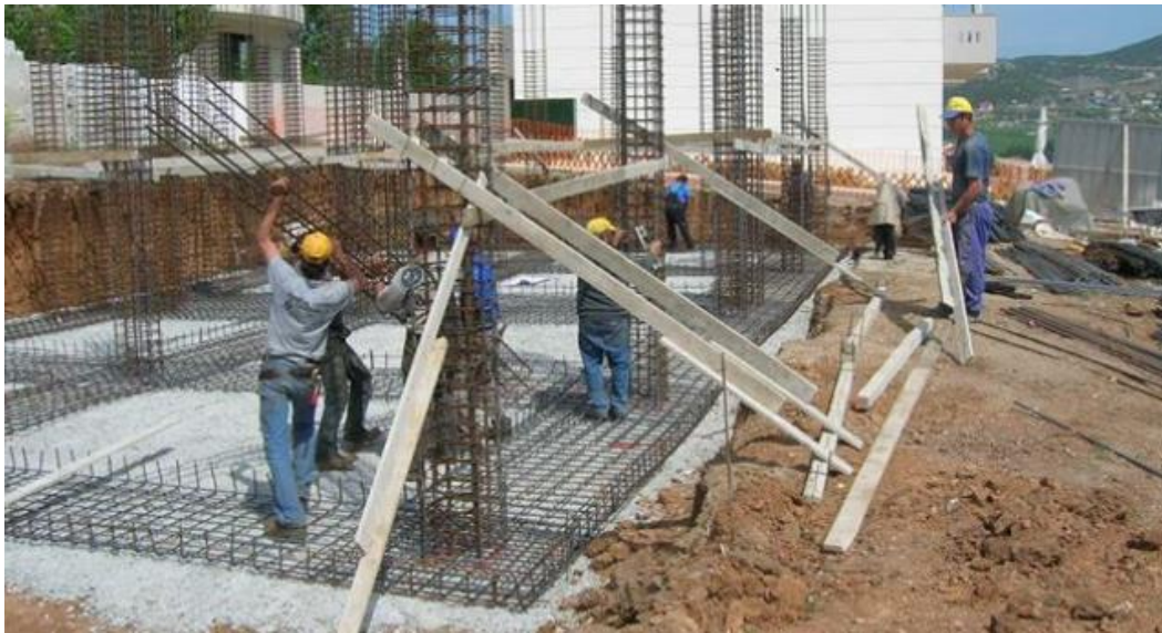
Εικόνα 12 Απόσπασμα από εργασίες σε εργοτάξιο
