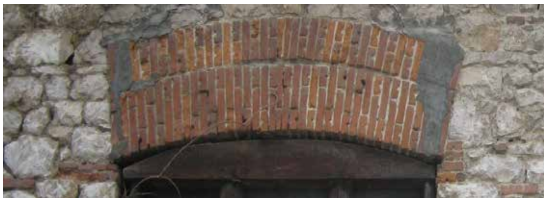
Εικόνα 25: Συνδυασμός λιθοδομής και οπτοπλινθοδομής στην δυτική όψη.
