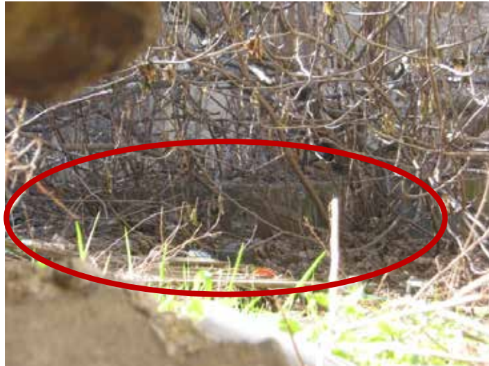
Εικόνα 6: Η βάση από σπλισμένο σκυρόδεμα στον χώρο α του κτιρίου Β.
