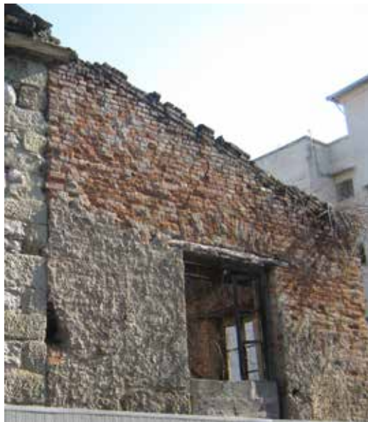
Εικόνα 11: Άποψη δυτικής όψης στην οποία φαίνεται η κλίση της στέγης, το επίχρισμα της τοιχοποιίας αλλά και το άνοιγμά της.
