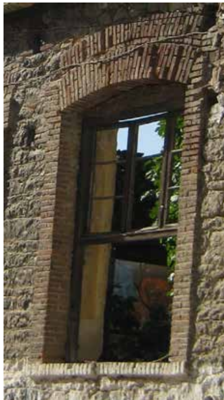
Εικόνα 30: Χρήση τούβλου στα ανοίγματα στην ανατολική όψη.
