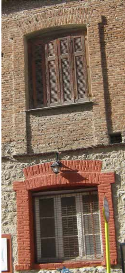
Εικόνα 5: Άποψη ανατολικής όψης όπου φαίνεται η κορνίζα των παραθύρων για τον κάθε όροφο.
