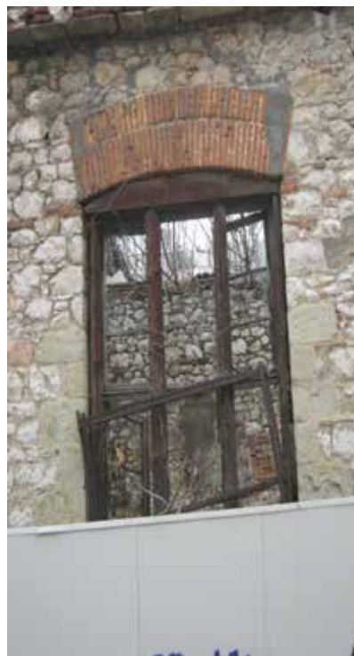
Εικόνα 24: Άνοιγμα δυτικής όψης το οποίο έχει ενισχυθεί στο πρέκι του με την βοήθεια ενός τοξοειδούς μορφής ξύλου.
