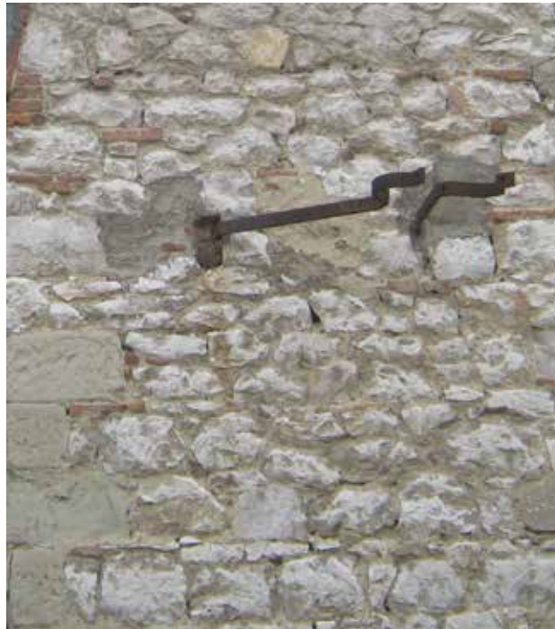
Εικόνα 7: Λιθοδομή δυτικής όψης.
