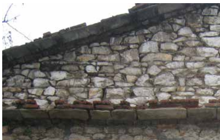
Εικόνα 31: Χρήση τούβλου ως συμπληρωματικό υλικό στην περιοχή έδρασης της στέγης στη δυτική όψη.
