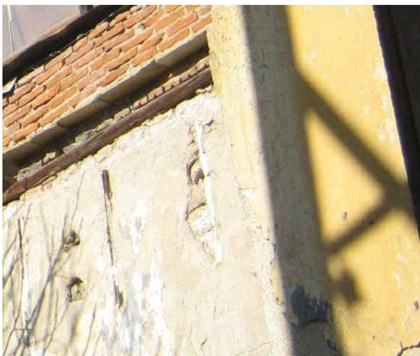
Εικόνα 32: Εσωτερικό επίχρισμα, που είναι εμφανές από ανατολικό άνοιγμα.
