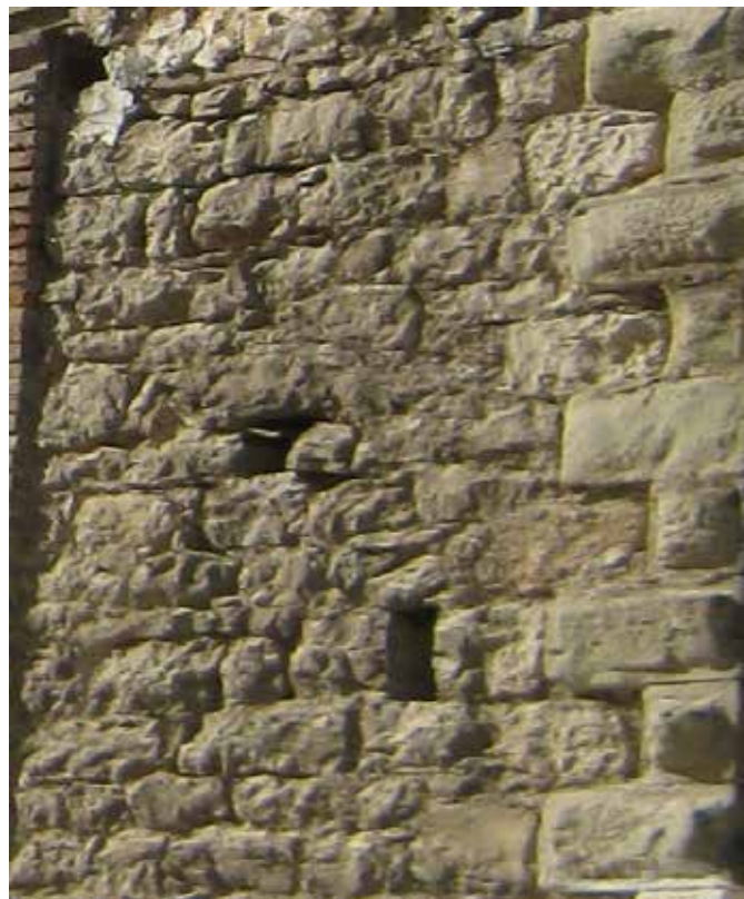
Εικόνα 8: Λιθοδομή και γωνιακά αγκωνάρια ανατολικής όψης.
