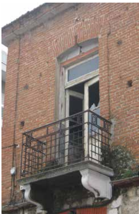
Εικόνα 14: Άποψη βόρειας όψης όπου φαίνεται ο εξώστης από ολόισωμες μαρμάρινες πλάκες ιδιαίτερα επεξεργασμένες καθώς και τα μεταλλικά κιγκλιδώματά του και αποτελεί το σημείο μέτρησης του ύψους του πατώματος του ορόφου. Ακόμα βλέπουμε την περιοχή εδράσεως του ορόφου και της στέγης.
