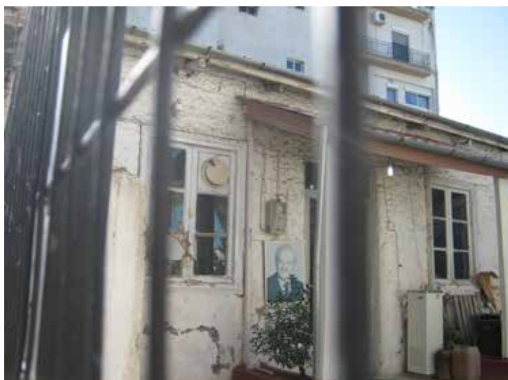
Εικόνα 12: Άποψη βόρειας όψης.
