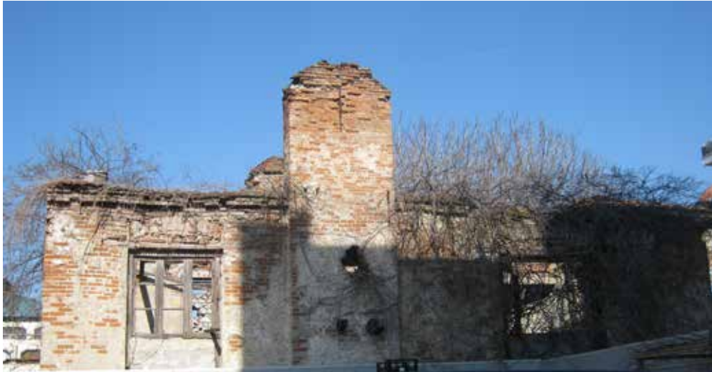
Εικόνα 35: Νότια όψη στην οποία φαίνονται τα ανοίγματα.
