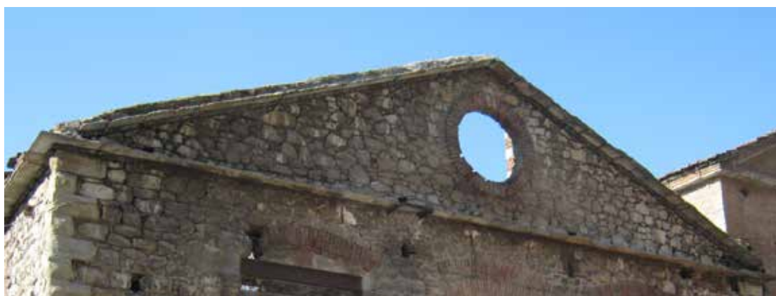
Εικόνα 33: Άποψη στέγης στην ανατολική όψη
