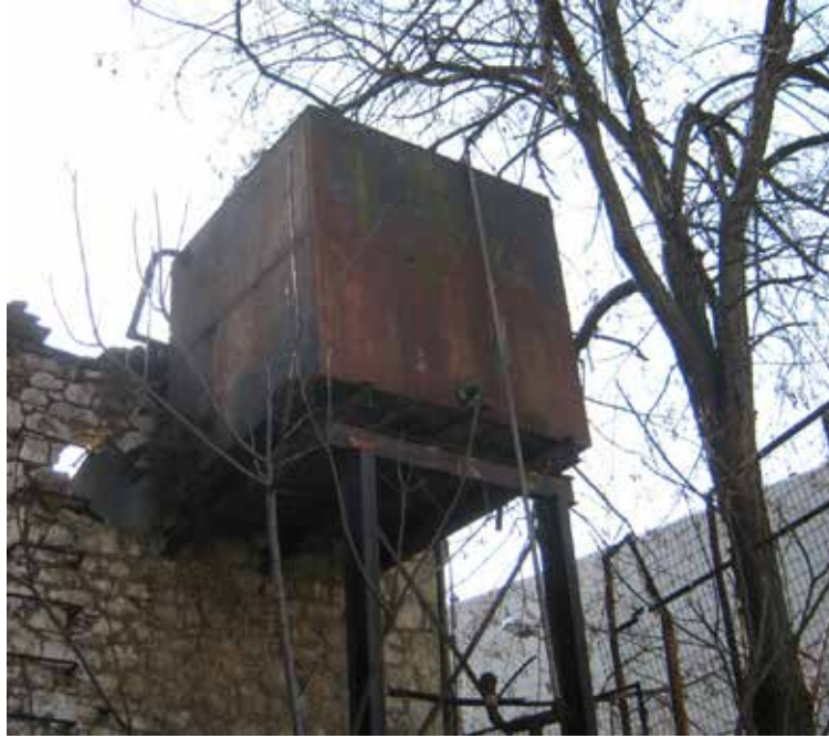
Εικόνα 21: Η Μεταλλική δεξαμενή στην εξωτερική πλευρά της δυτικής όψης.
