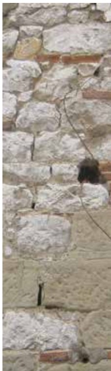
Εικόνα 10: Χρήση τούβλου ως υλικό κάλυψης κενών στην δυτική όψη.
