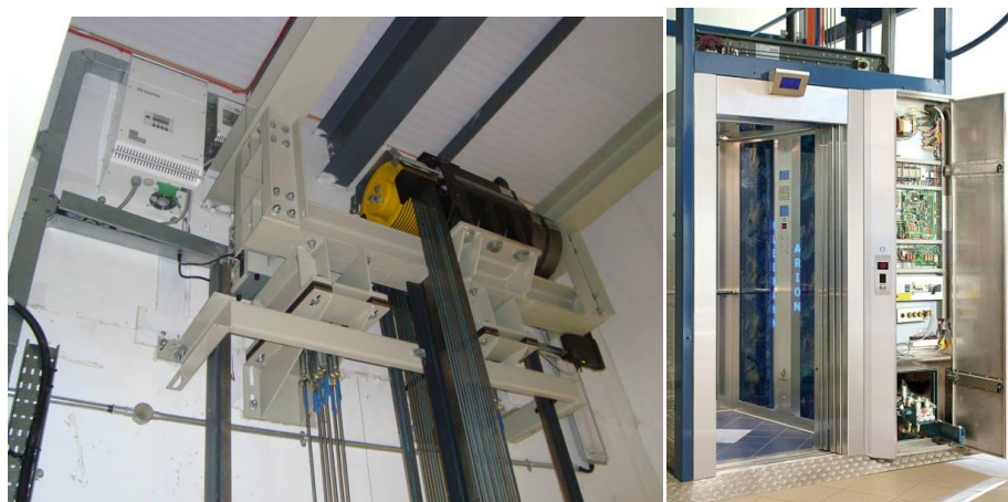
Εικόνα 4.3 Εγκατάσταση εξοπλισμού μηχανοστασίου του ανελκυστήρα.
