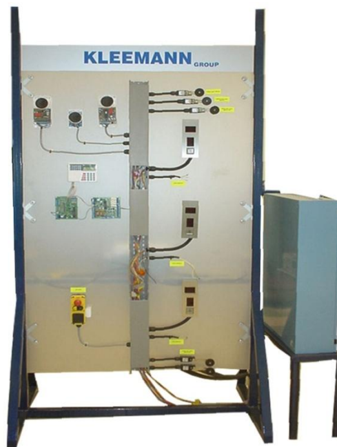
Εικόνα 12.1 Ηλεκτρική εξάρτηση ανελκυστήρα, (Πηγή: Kleemann Ελλάς ΑΒΕΕ).
