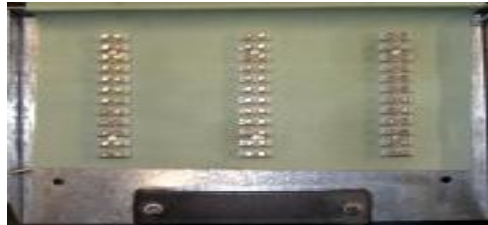
Εικόνα: 12.7 Διακλαδωτήρας. (Πηγή: Γκολώνης Χρ.)
