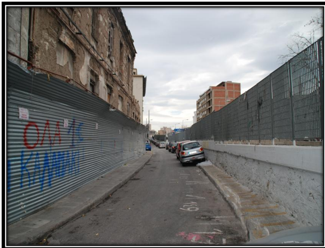
Εικ. 2.28. : Άποψη της Οδού Αλιπέδου από το σημείο που βρίσκονται οι τελευταίοι πάγκοι του παζαριού. Στα δεξιά διακρίνονται τα προστατευτικά κιγκλιδώματα των γραμμών του τρένου και στο βάθος η ανάπτυξη της οδού Αλιπέδου.
