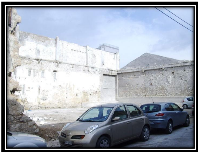
Εικ. 3.63. : Αδόμητο οικόπεδο.
