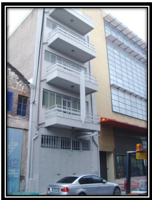
Εικ. 3.77. : Επίσης μικρού πλάτους κτίριο. Πιθανόν αποθήκες.
