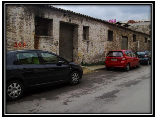
Εικ.3.47. : Παλαιά μονόροφα κτίρια.
