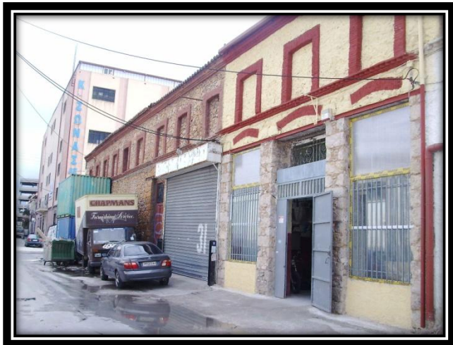
Εικ. 3.61. : Μηχανουργείο. Containers στη συμβολή με Χαϊδαρίου.
