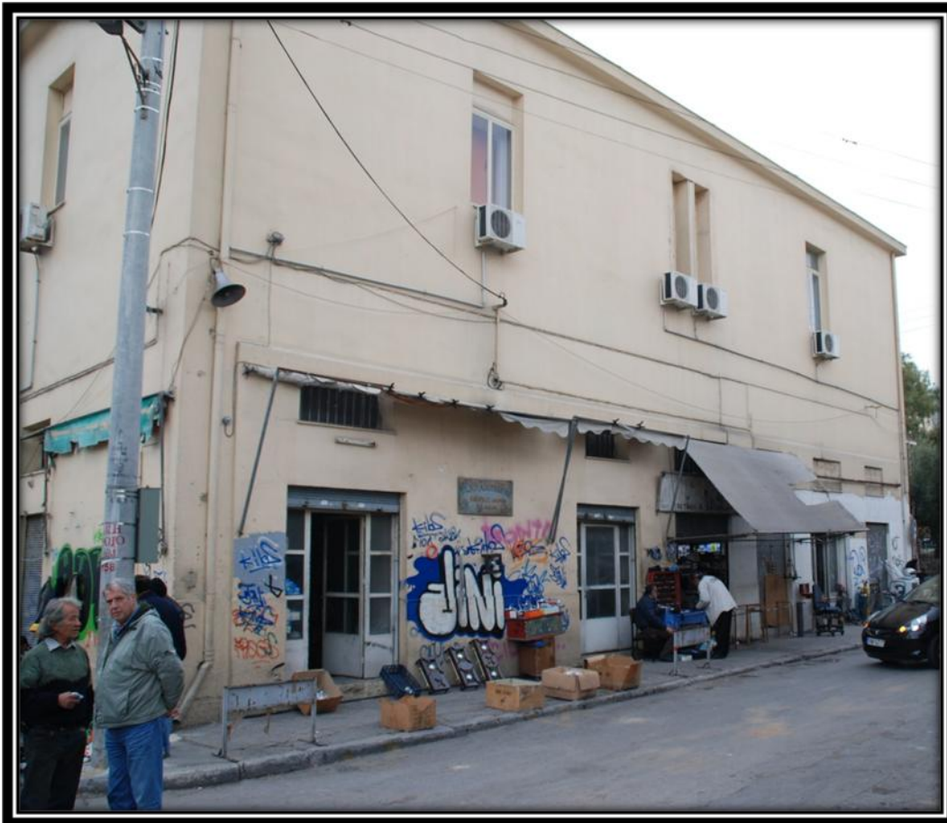
Εικ. 2.21. : Συμβολή της οδού Αλιπέδου με την οδό Πύλης. Διακρίνονται τα παλαιопωλεία του κτιρίου της εικόνας 2.8. και επίσης η χρήση του πεζοδρομίου από τους ιδιοκτήτες τους.
