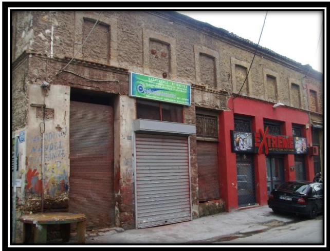
Εικ. 3.34. : Μηχανουργείο, εμπόριο.
