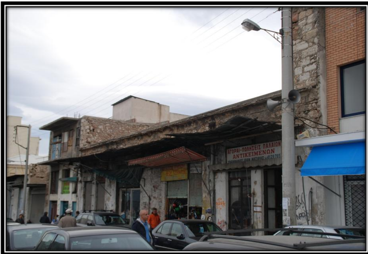
Εικ. 2.16. : Πλινθόκτιστο μονώροφο κτίριο σε κακή κατάσταση, πιθανής χρονολογίας 1920-1950. Στο ισόγειό του στεγάζονται 2 παλαιοπωλεία και μία αποθήκη.
