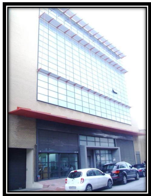
Εικ. 3.78. : Νέας κατασκευής κτίριο.
