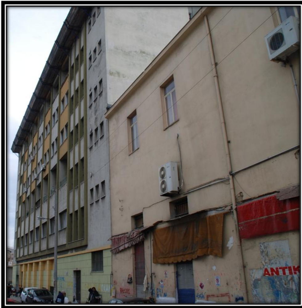
Εικ. 2.23. : Στα δεξιά το κτίριο της εικόνας 2.8. ενώ στα αριστερά το κτίριο που στεγάζεται το εμποροϋπαλληλικό κέντρο Πειραιά. Είναι ένα βόροφο δημόσιο κτίριο ηλικίας 40-50 ετών. Σε αυτό το σημείο, η στενότητα του δρόμου όσο και των πεζοδρομίων, είναι εμφανή.
