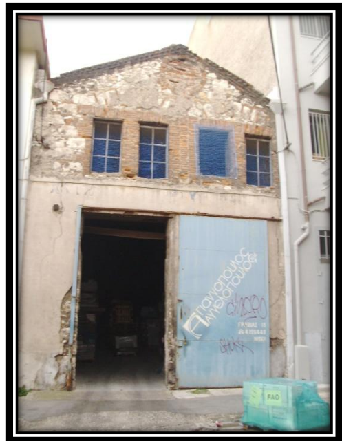
Εικ. 3.76. : Μικρού πλάτους κτίριο, αποθήκη.
