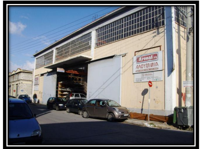
Εικ. 3.16. : Κτίριο με δραστηριότητες Αποθήκευσης και επεξεργασίας αλουμινίου.
