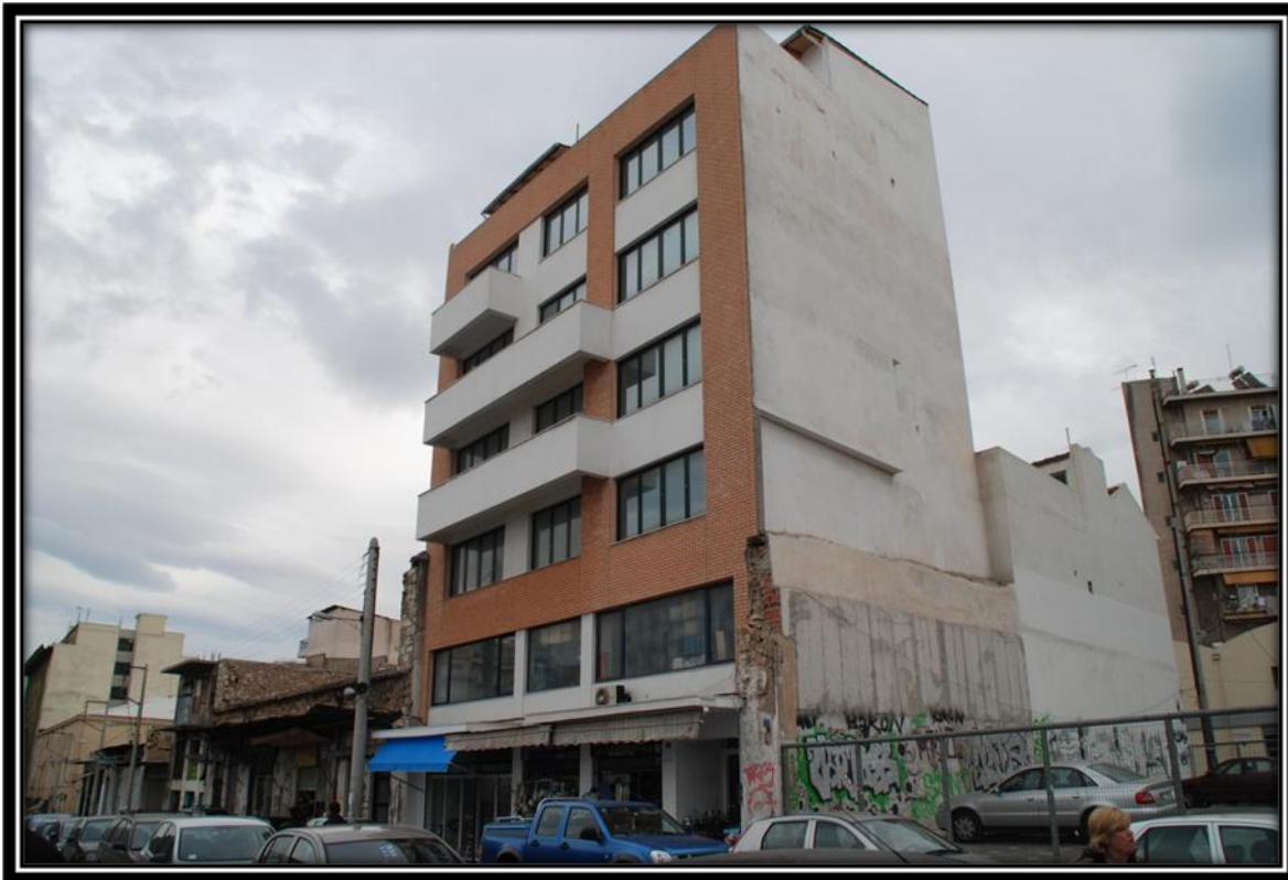
Εικ. 2.15. : Το πρώτο κτίριο στην οδό Αλιπέδου. Στον αριθμό 38. 7 όροφο κτίριο σε καλή κατάσταση. Χτισμένο πιθανόν την προηγούμενη 20ετία. Στο ισόγειό του στεγάζεται ένα κατάστημα με λευκά είδη και ένα κατάστημα με εργαλεία.
