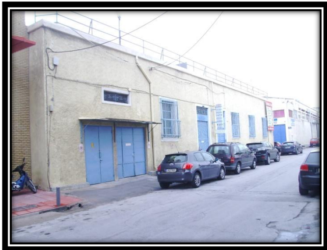
Εικ. 3.79. : Πίσω όψη κτιρίου με είσοδο στην Ασκληπιού.
