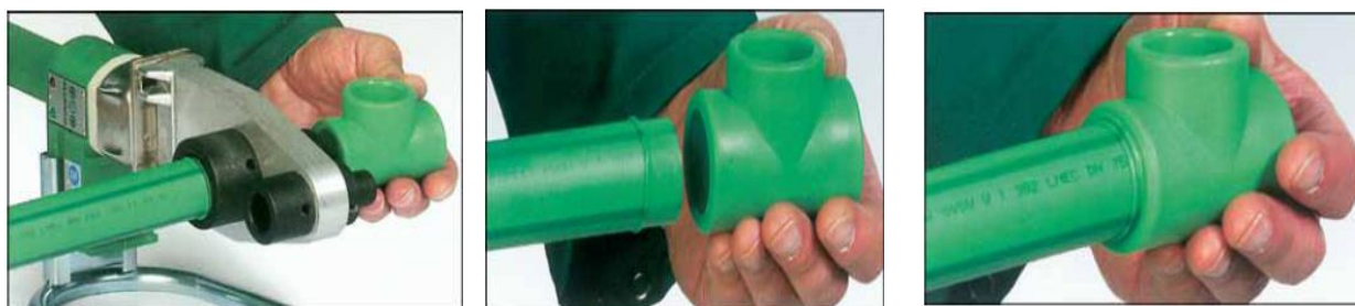
Παράδειγμα συγκόλλησης αυτοσυγκολλούμενων πλαστικών σωλήνων Εικόνα 1.14
