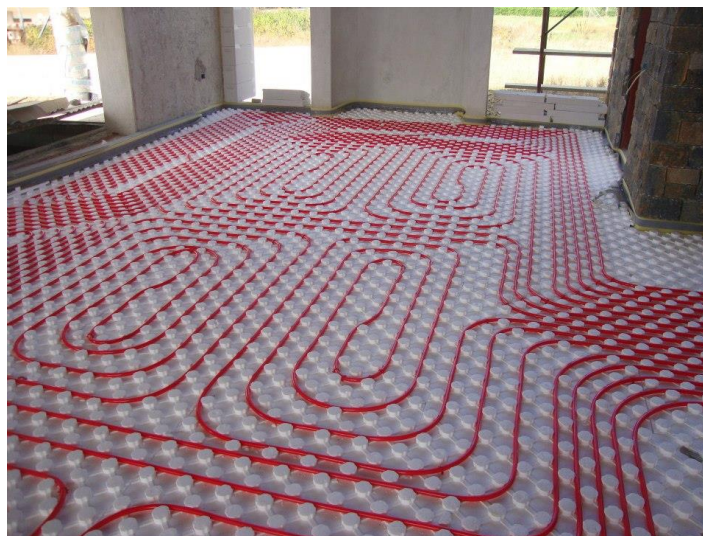
Εικόνα 4.8 Τυπική διάταξη ενδοδαπέδιας θέρμανσης
