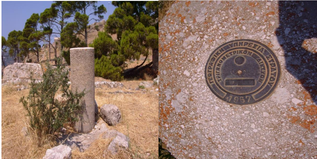
Στύλος εξασφάλισης τριγωνομ. σημείου Στοιχεία τριγωνομ. σημείου
