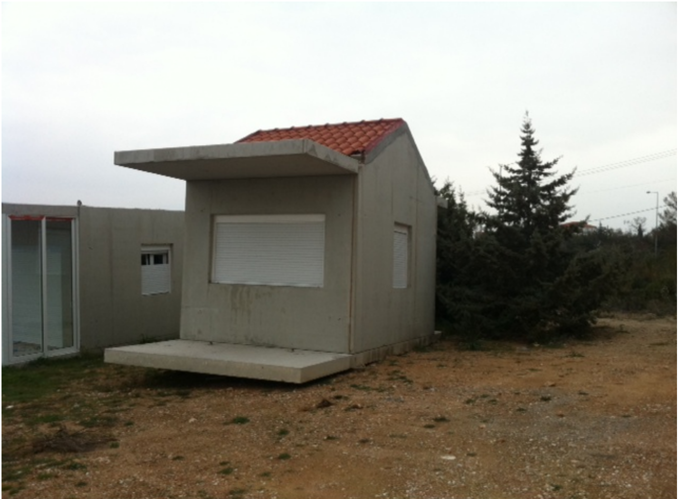
Φωτογραφία 4.3: Φωτογραφία προκατασκευασμένου κτιρίου με παράθυρο
