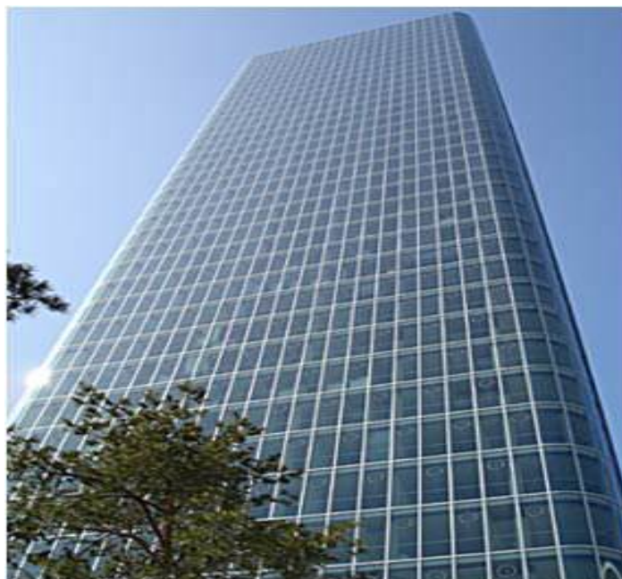
Σχήμα 3.39: Κτίριο με ανακλαστικούς υαλοπίνακες
