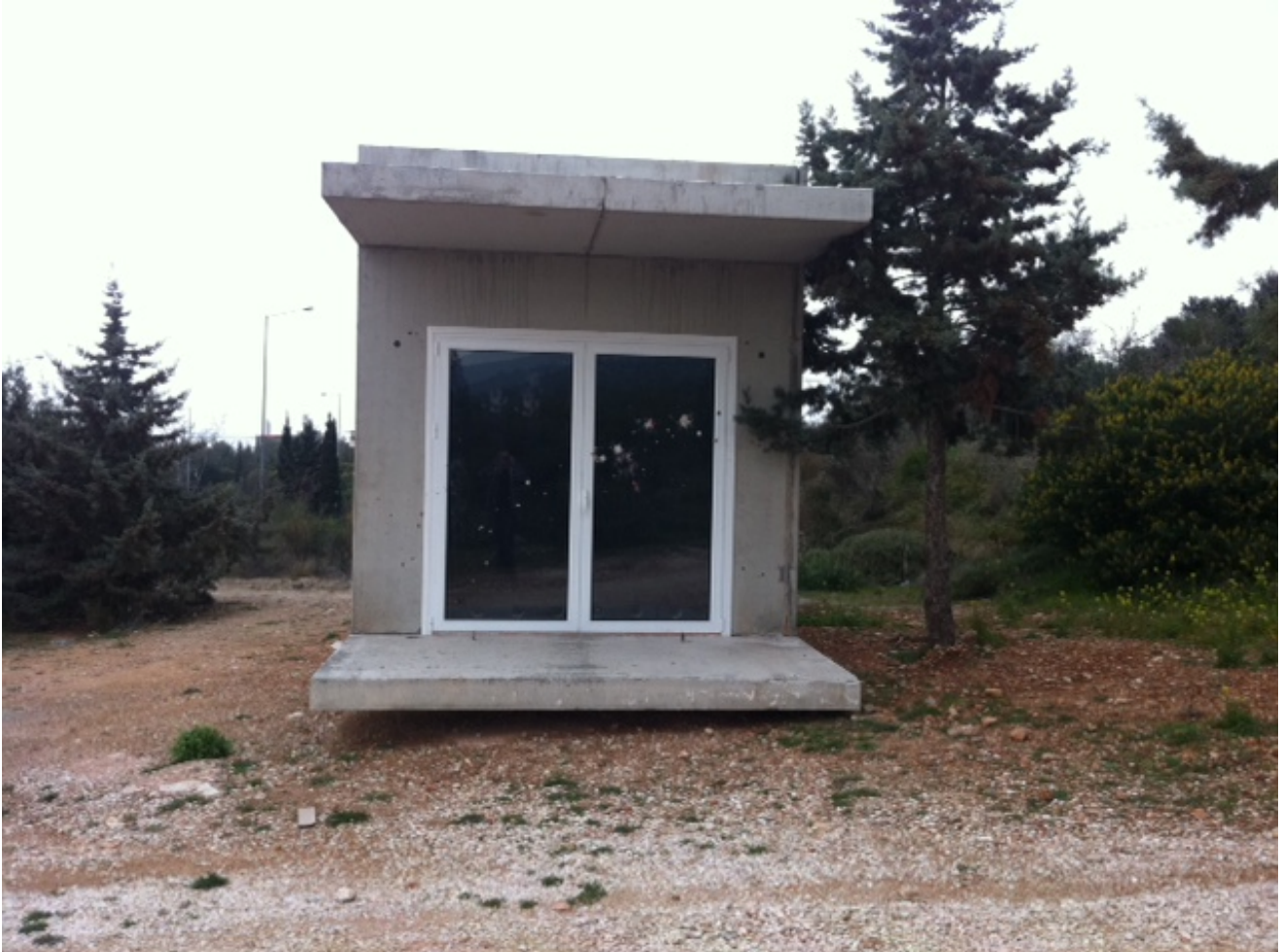
Φωτογραφία 4.2: Φωτογραφία προκατασκευασμένου κτιρίου με τοίχο Trombe
