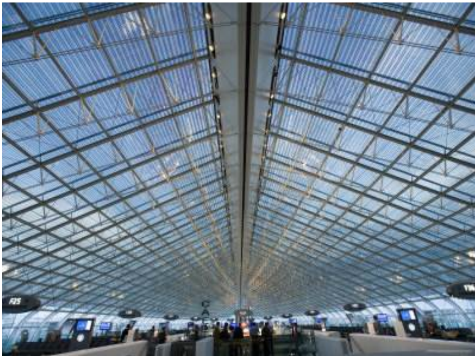
Σχήμα 3.36: Γυάλινη Στέγη αεροδρομίου (Πηγή: http://eu.art.com )
