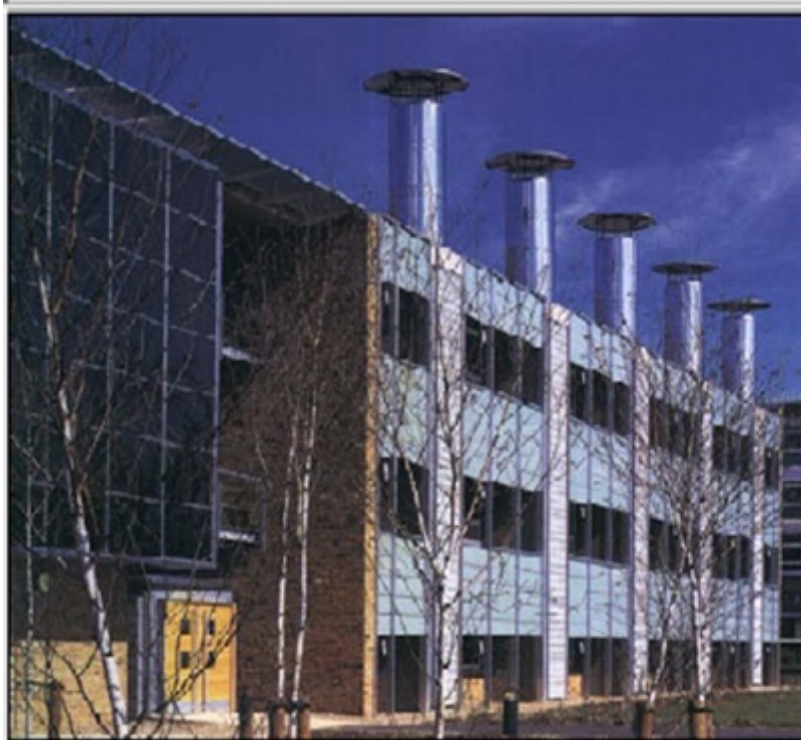
Σχήμα 3.27: Ηλιακές καμινάδες στο Building Research Establishment, Watford, United Kingdom
