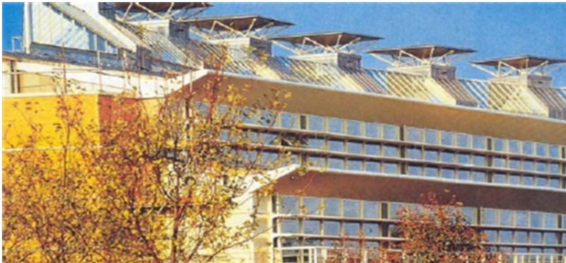
Σχήμα 3.25: IONICA, Κτίριο Γραφείων στο Cambridge – καμινάδες αερισμού (Πηγή: Αρχιτ: R. H.Partnership, 1994)
