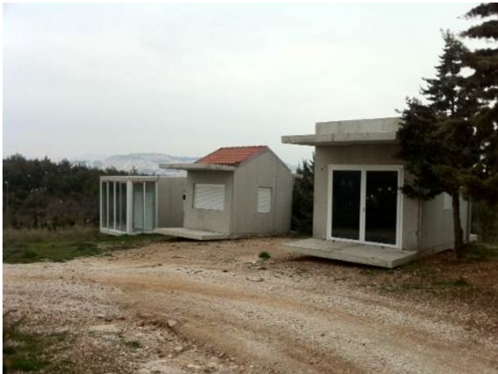
Φωτογραφία 4.1: Φωτογραφία μελετώμενων προκατασκευασμένων κτιρίων
