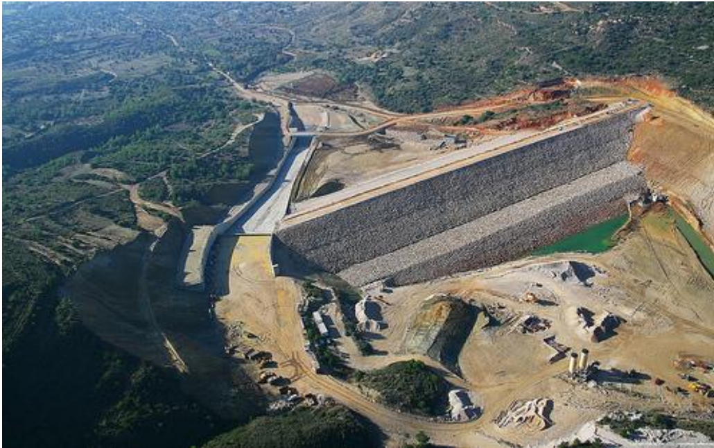
Εικόνα 2.2 Το Φράγμα της Καλαμωτής στο στάδιο κατασκευής
