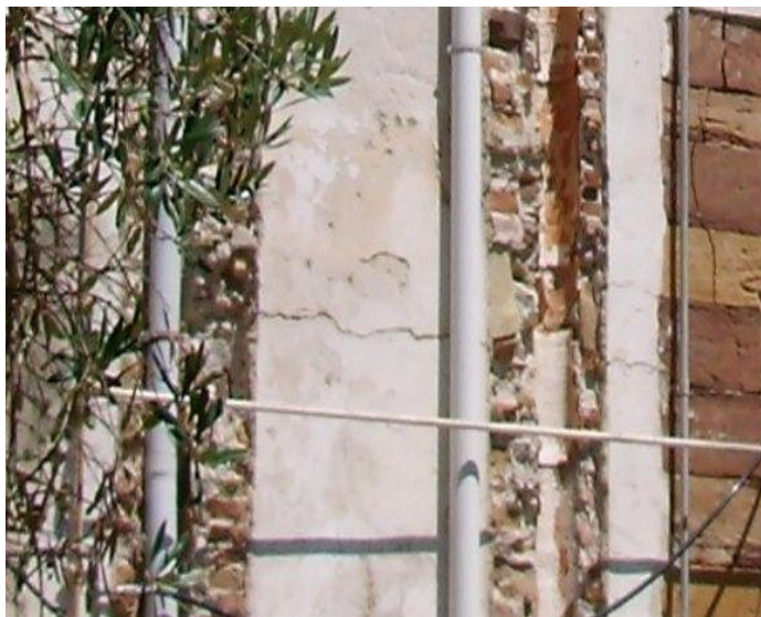
Εικόνα 30 Τοπική καθαίρεση επιχρίσματος στο νότιο τμήμα της κατοικίας
