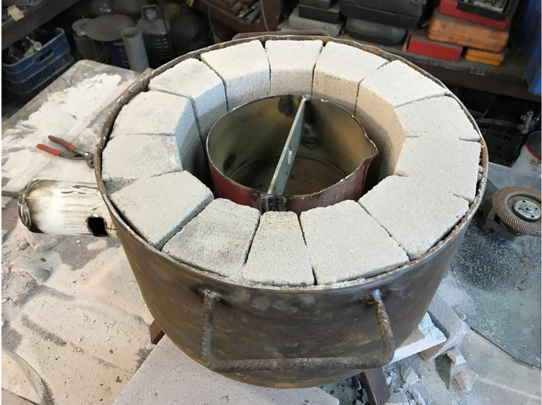
Εικ.6. –Οπλισμός του καμινιού με θερμομονωτικά υλικά
