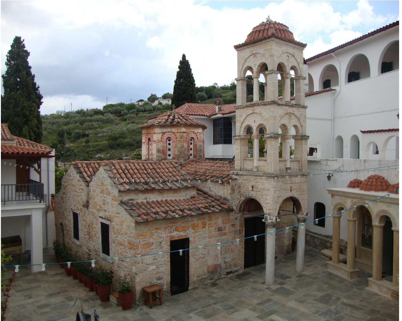
Εικόνα 27 Αποψη του καθολικού της Μονής από την εσωτερική αυλή.
