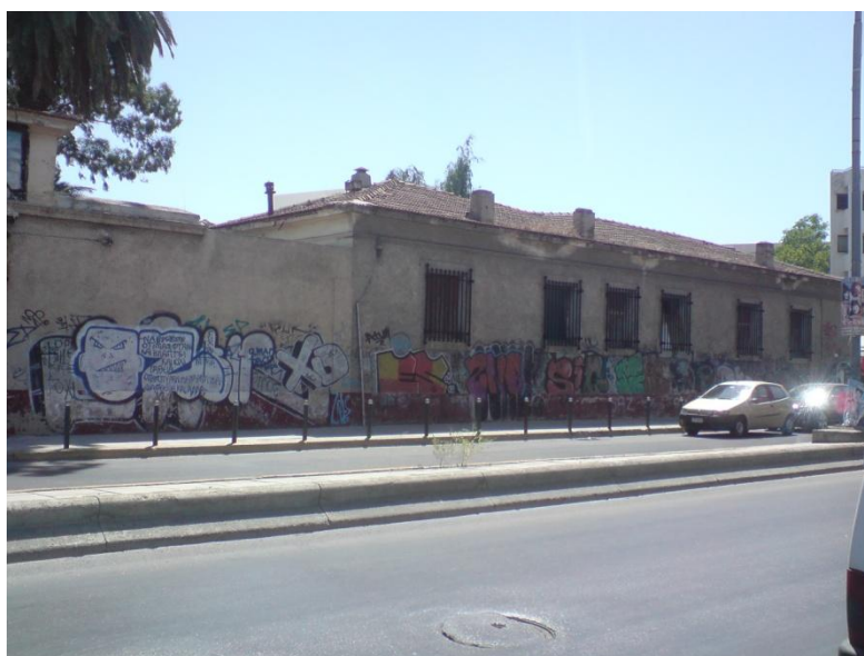
Εικόνα 5.37: Δυτική όψη των κτιρίων διοίκησης. (Οδός Ρετσίνα)
