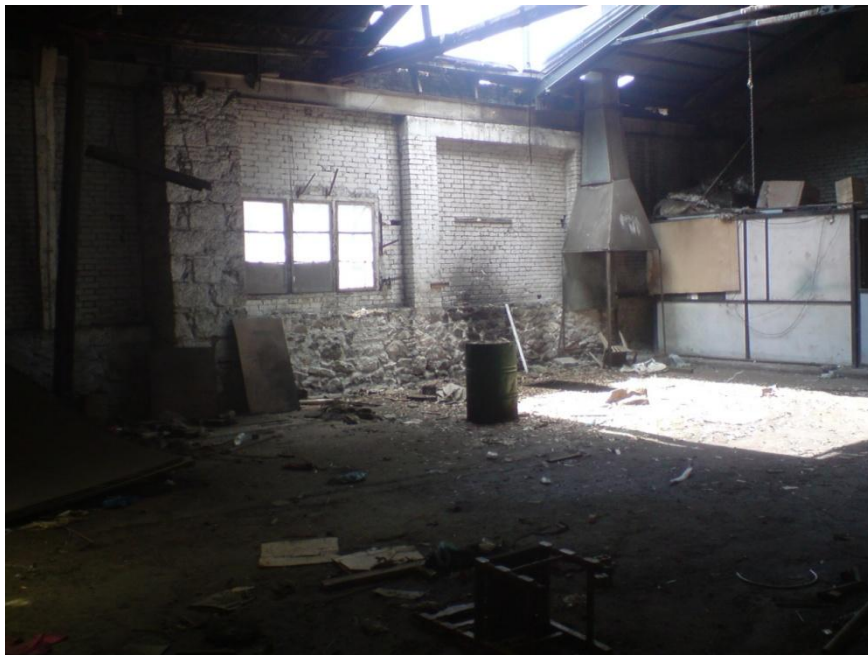
Εικόνα 5.53: Το εσωτερικό του κτιρίου Z
