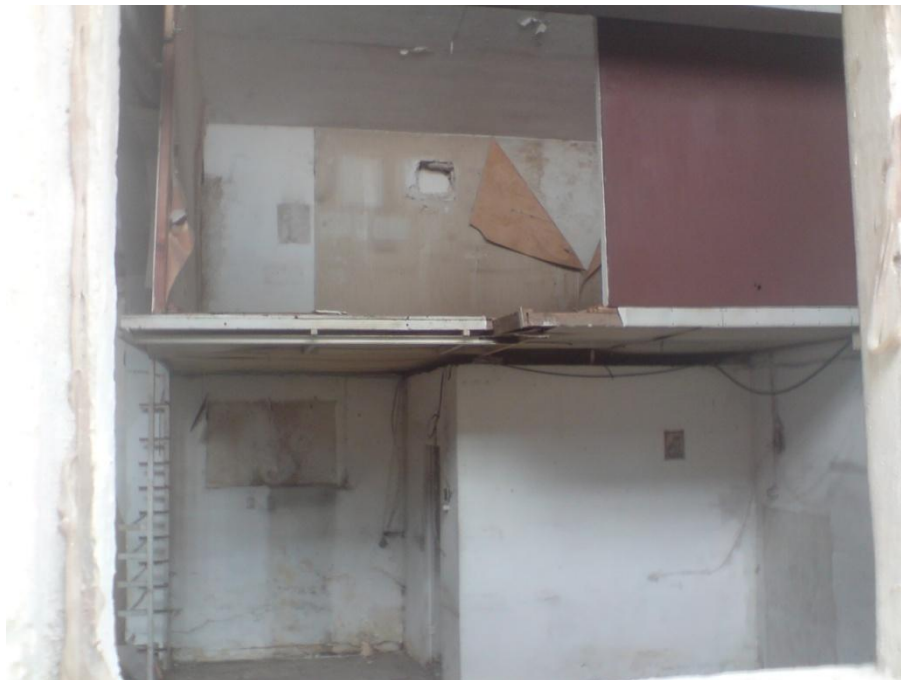
Εικόνα 5.8: Εσωτερική άποψη του τμήματος Γ4
