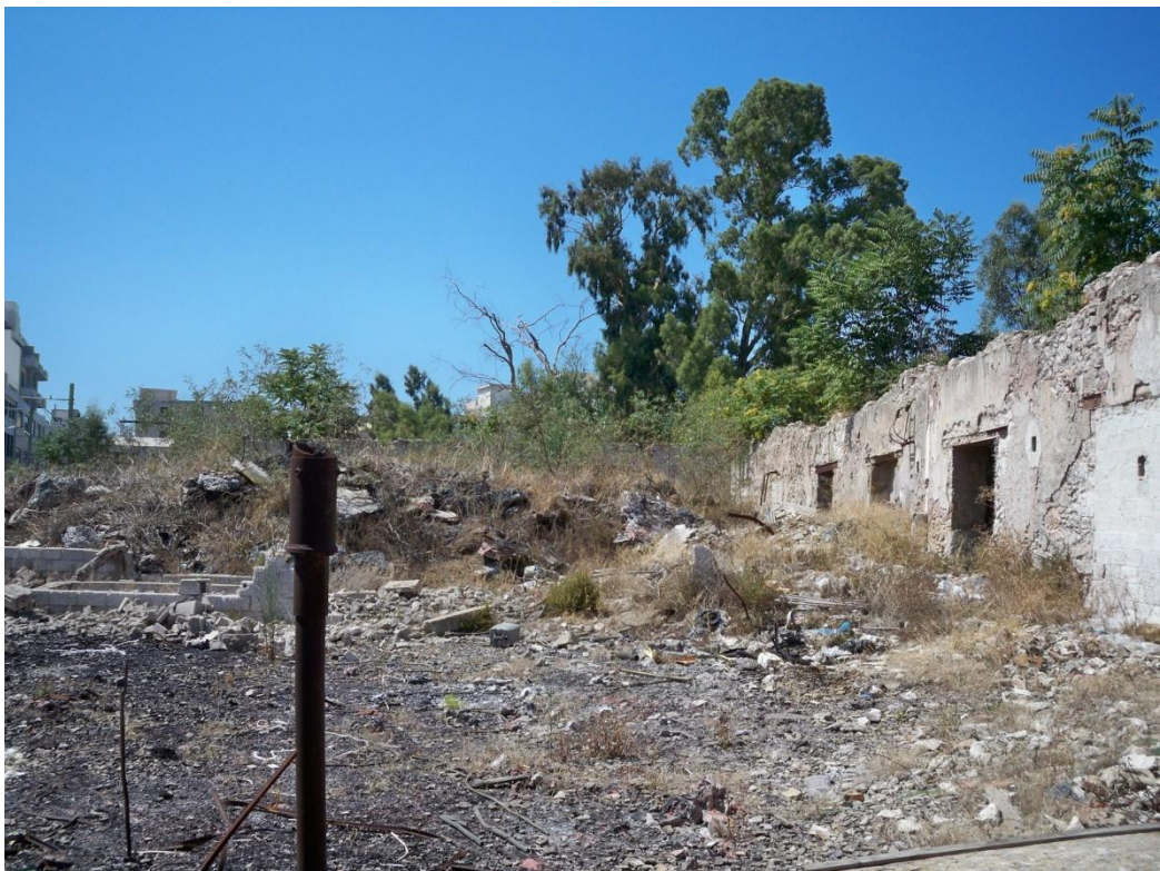
Εικόνα 5.25: Το ίδιο κτίριο σήμερα
