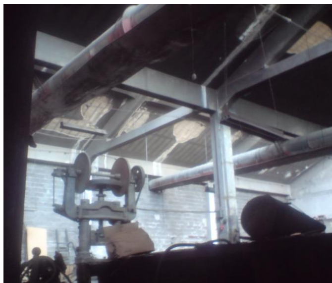
Εικόνα 5.12: Εσωτερική άποψη του κτιρίου
