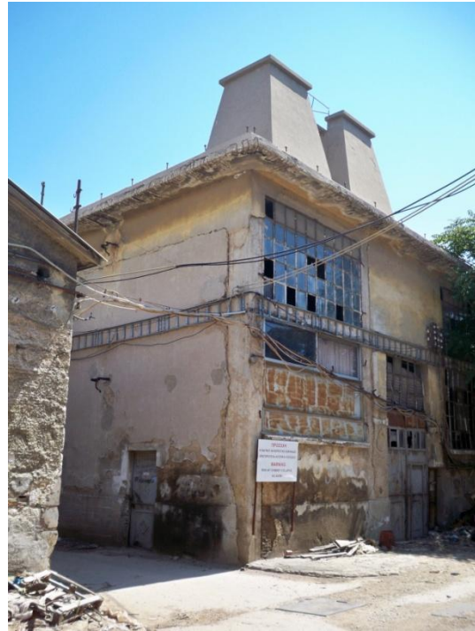
Εικόνα 5.22: Κεντρική όψη του κτιρίου B4
