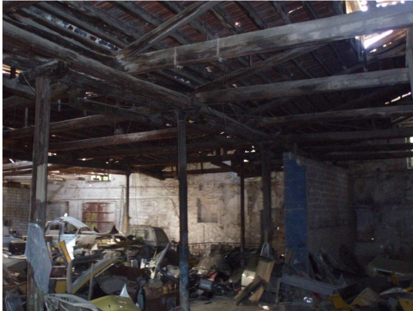
Εικόνα 5.48: Το εσωτερικό του κτιρίου E2
