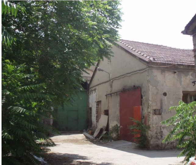
Εικόνα 5.17: Βόρεια όψη του κτιρίου Β1
