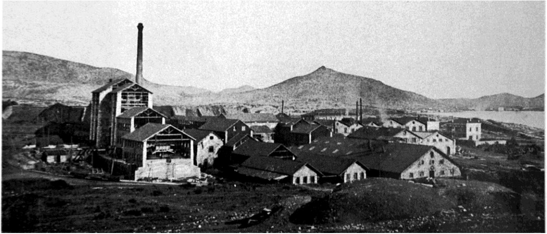
Εικόνα 3.9: Μεταλλευτικές εγκαταστάσεις της Γαλλικής Εταιρείας Λαυρίου, 1890
