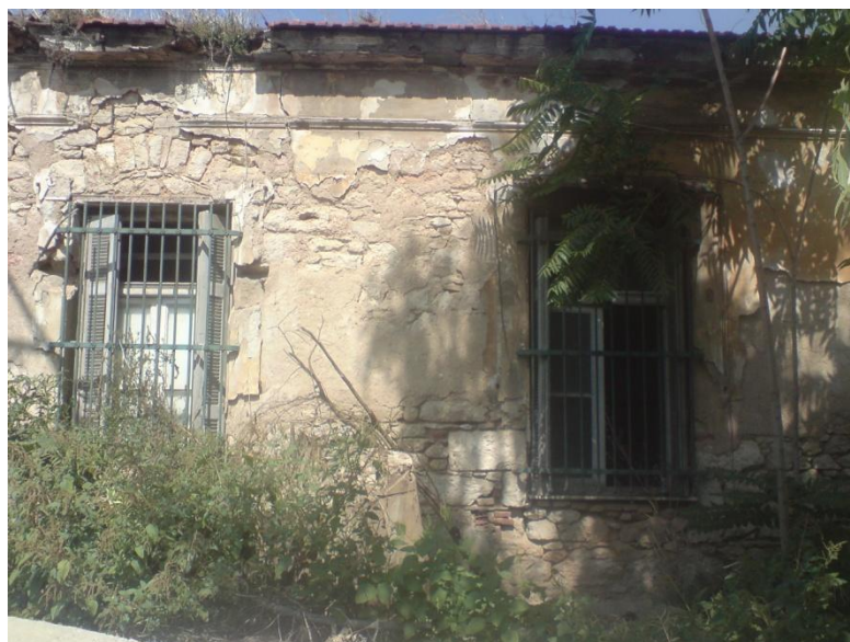
Εικόνα 5.15: Τμήμα της ανατολικής όψης του κτιρίου
