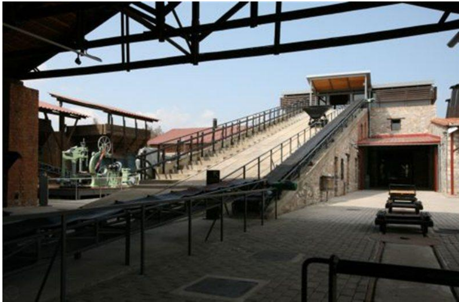
Εικόνα 3.7: Ράμπα μεταφοράς αργιλοχώματος προς το μύλο
