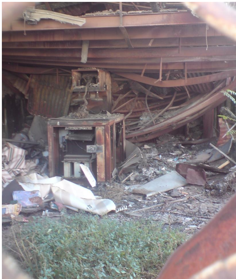
Εικόνα 5.419: Εικόνες καταστροφής που αντικρίσαμε.
