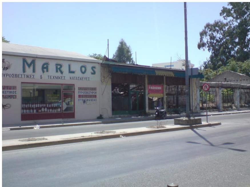
Εικόνα 5.17: Εικόνες από την δυτική όψη του κτιρίου Δ4
