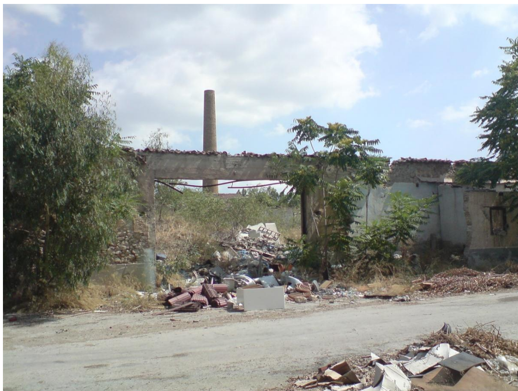
Εικόνα 5.6: Νότια όψη του κτιρίου Γ1
