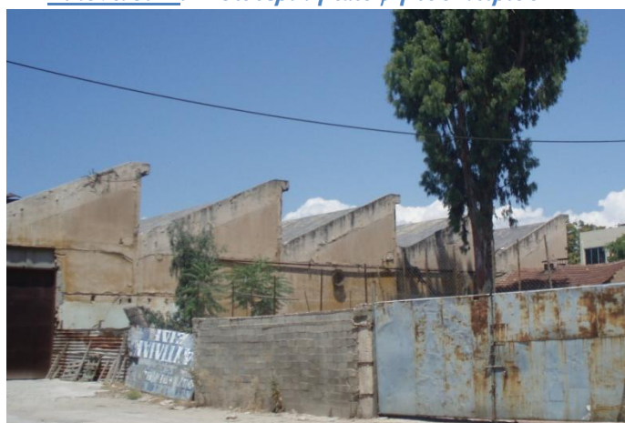
Εικόνα 5.13: Ανατολική όψη του κτιρίου B2 – Οδοντωτή στέγη
