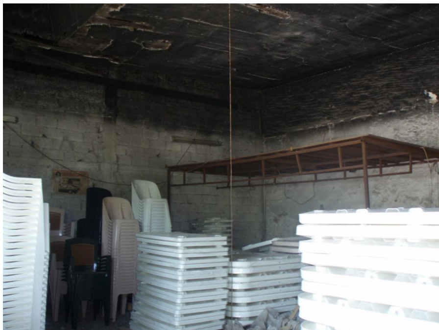
Εικόνα 5.45: Το εσωτερικό του κτιρίου.
