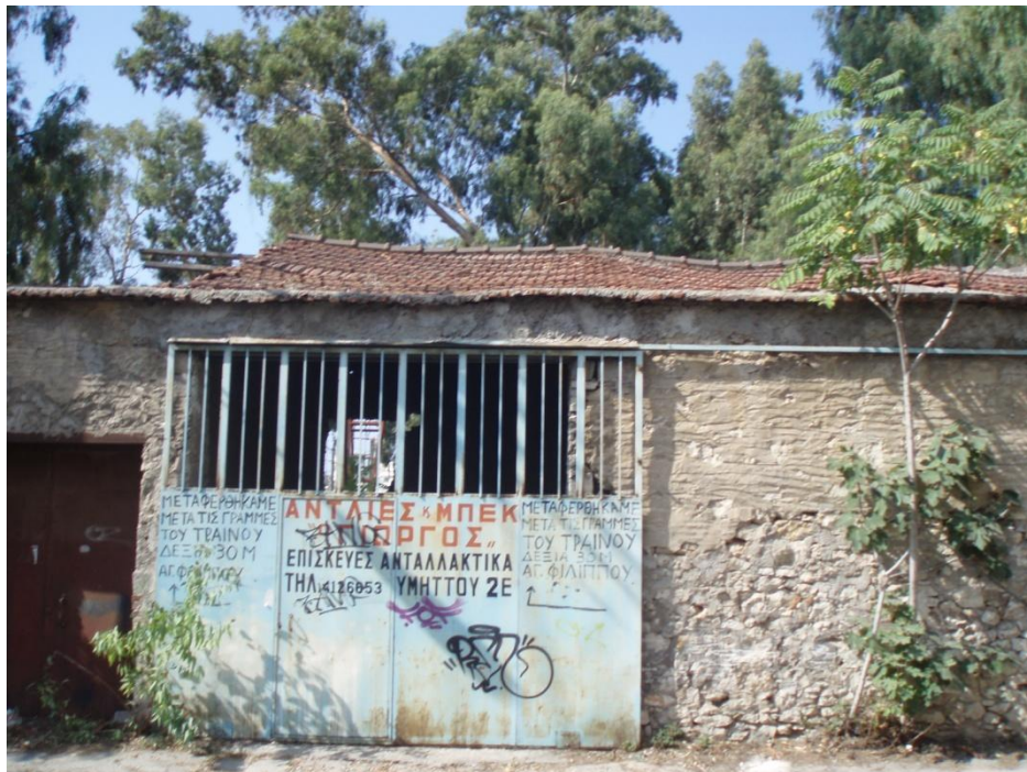
Εικόνα 5.51: Η βόρεια όψη του κτιρίου E6
