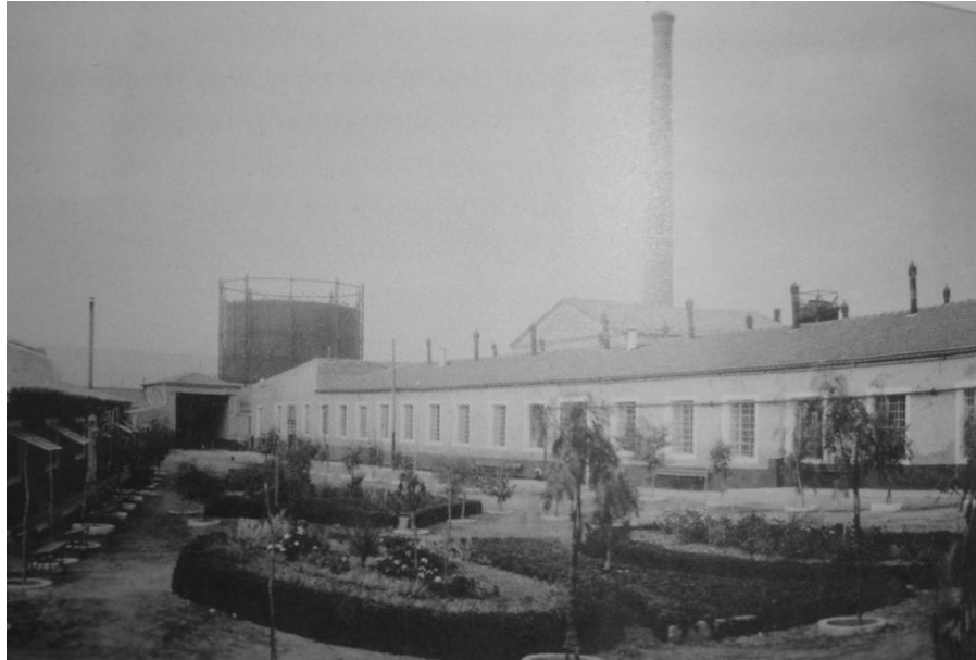
Εικόνα 4.5: Φωτογραφία του Γ' εργοστασίου (πρώην Βαρουζάκη)
