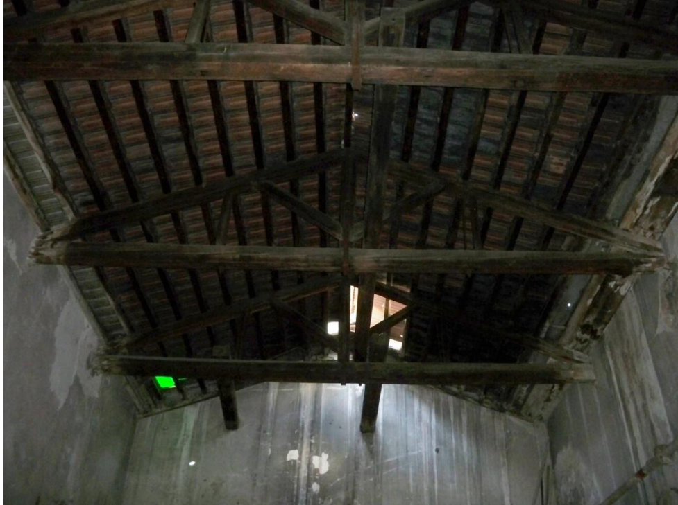
Εικόνα 5.14: Ξύλινα ζευκτά της στέγης.
