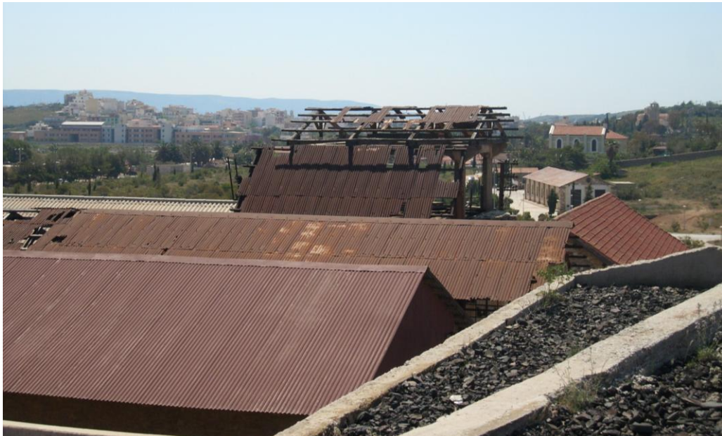
Εικόνα 3.12: Αποκατεστημένη στέγη σε σύγκριση με αυτές που δεν έχουν αποκατασταθεί, 2011
