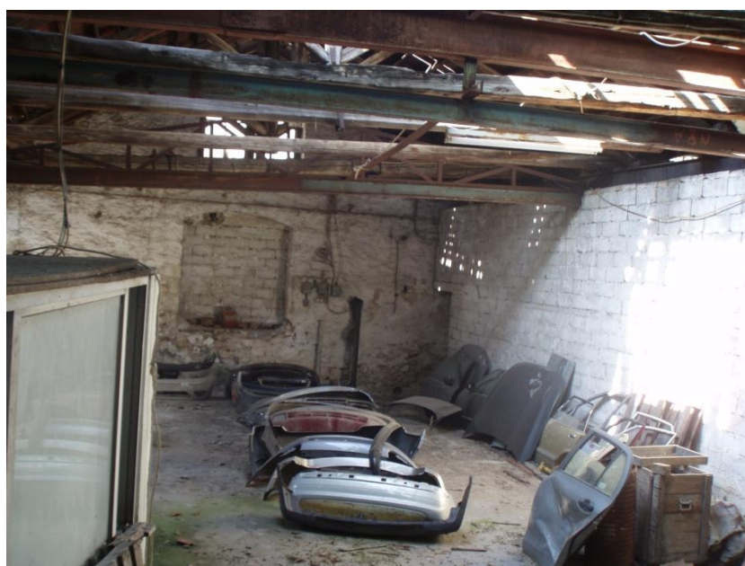
Εικόνα 21: Το εσωτερικό του κτιρίου E5
