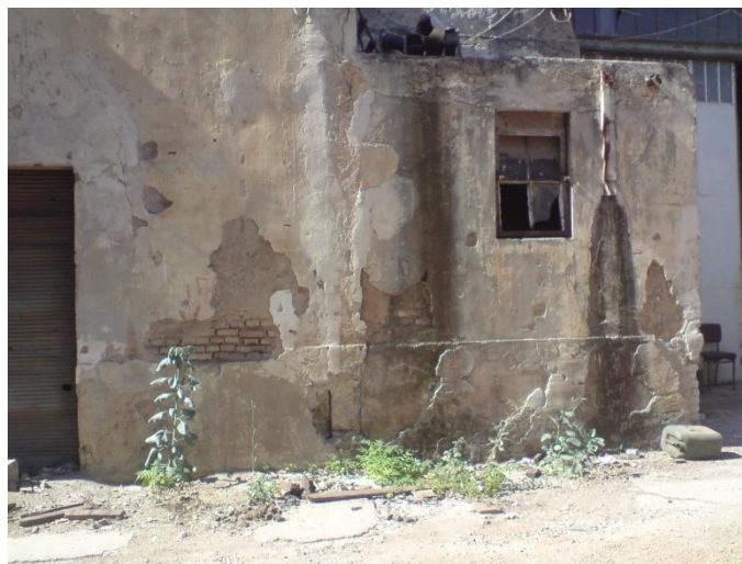
Εικόνα 5.32: Βόρεια όψη του βοηθητικού κτίσματος Γ1β
