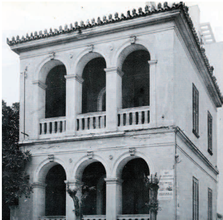
εικόνα 71: Νεοκλασικό κτήριο στην Αθήνα, στις οδούς Λασκαρίδου και Φιλαρέτου στην Καλλιθέα (Σ. Σκοπελίτης, Νεοκλασικά σπίτια της Αθήνας και του Πειραιά, Αθήνα 1975)
