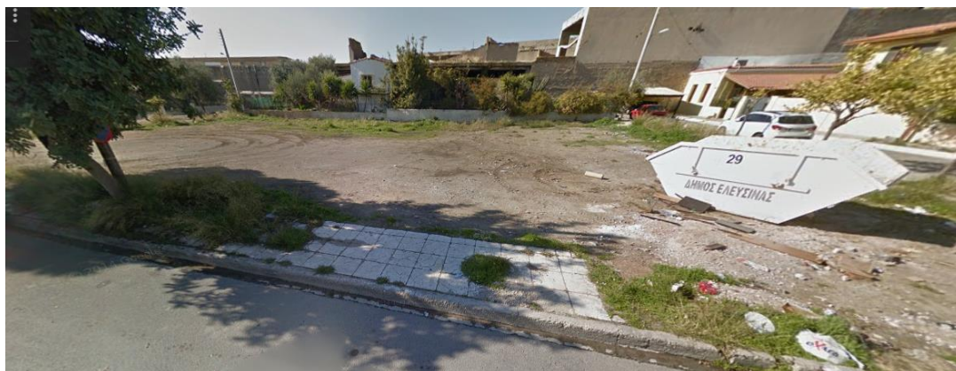
Εικόνα 18 Κατεστραμένο πεζοδρόμιο σε περιφερειακό δρόμο της Ελευσίνας
