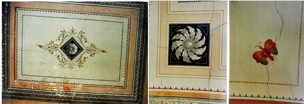
Εικόνα 67 Λεπτομέρειες από το εσωτερικό του κτιρίου 84
