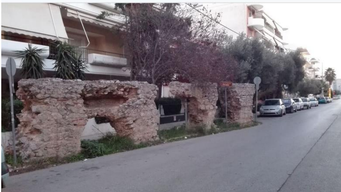
Εικόνα 10 Τμήμα του υδραγωγείου 25
