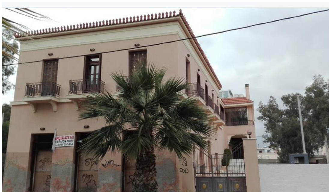
Εικόνα 75 Επιβλητικό κτίριο των αρχών του αιώνα 1910-1920 με έντονα νεοκλασικά στοιχεία. 91
