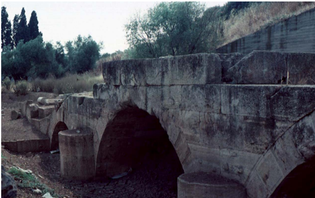
Εικόνα 13 Τμήμα της γέφυρας
