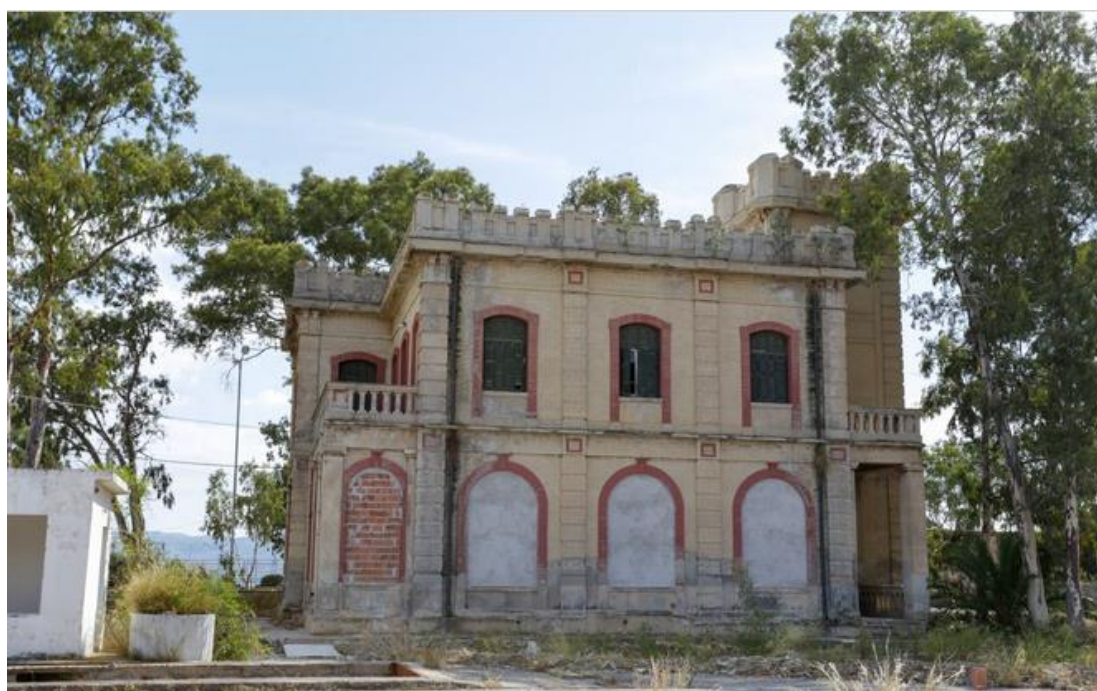
Εικόνα 70 Οι όψεις του κτιρίου έχουν αξονική συμμετρία ως προς τη διάταξη των ανοιγμάτων. 87
