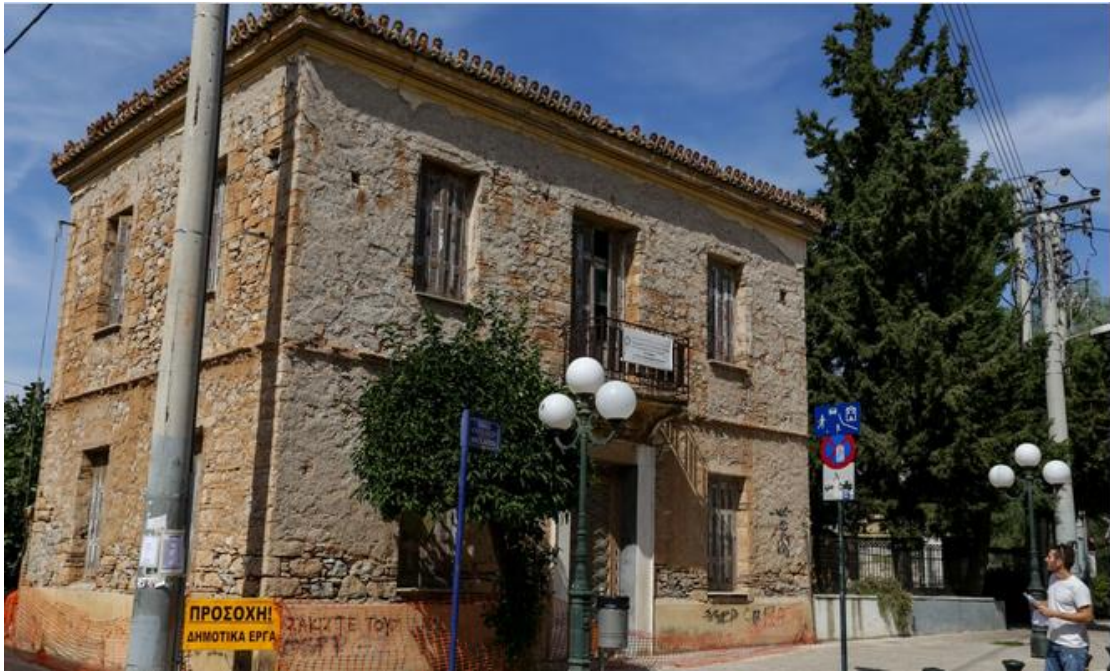
Εικόνα 49 Οι τοιχοποιίες είναι κατασκευασμένες με τον ίδιο τρόπο, είτε είναι εξωτερικές είτε εσωτερικές. Αποτελούνται από αργούς πλακοειδείς λίθους μεσαίου μεγέθους 75
