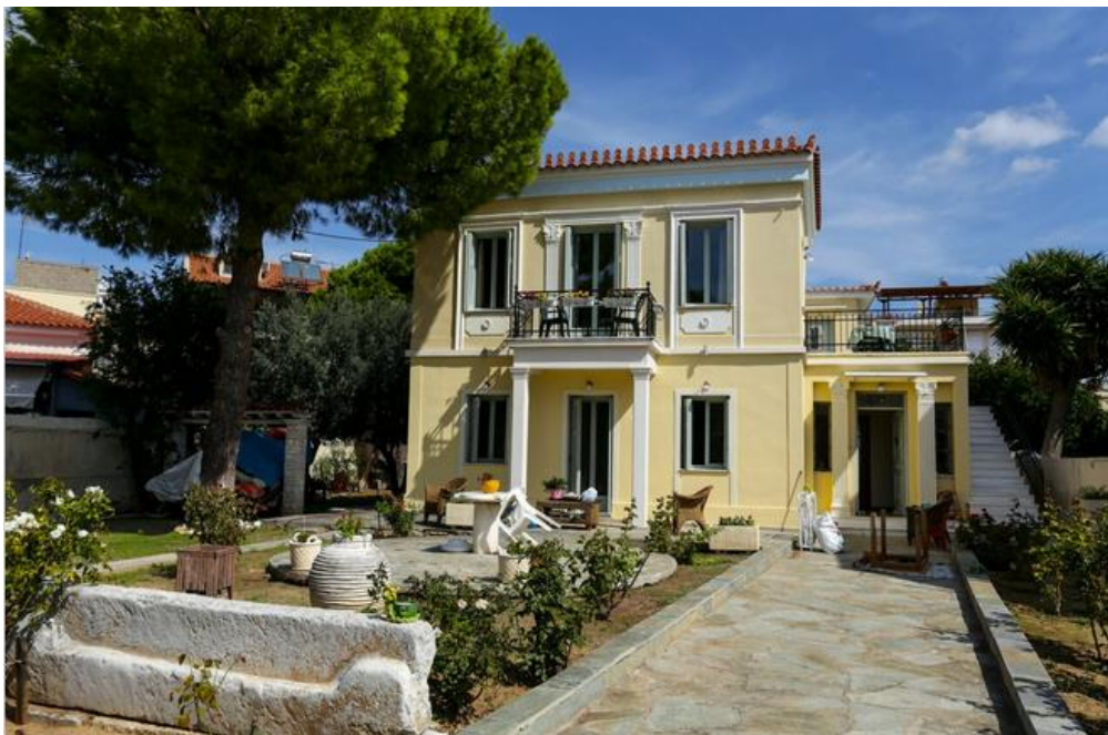
Εικόνα 63 Το κτίριο επι της οδού Κοντούλη και Κίμωνος 19 82
