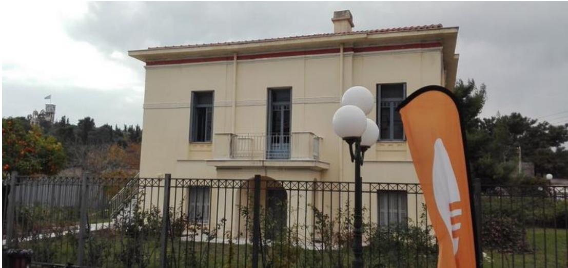
Εικόνα 45 Η πίσω όψη του κτιρίου 74
