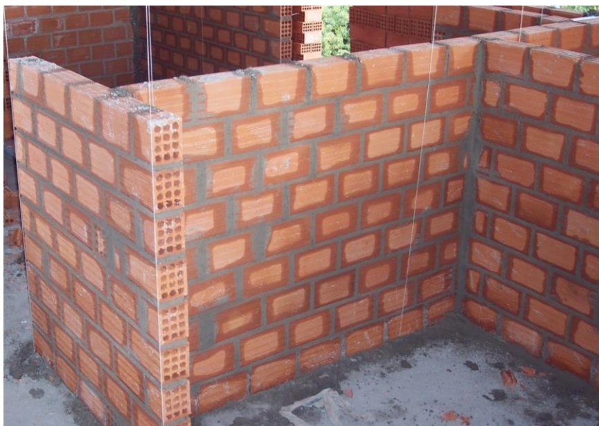
Εικόνα 3: Δρομική τοιχοποιία πάχους 9 εκατοστών
