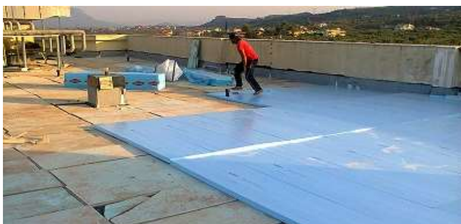
Εικόνα 31 Θερμομόνωση επίπεδης οροφής
