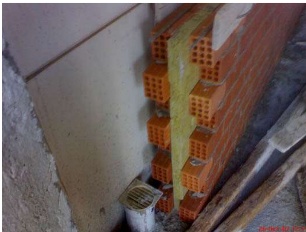
Εικόνα 29 Θερμομόνωση τοιχοποιίας
