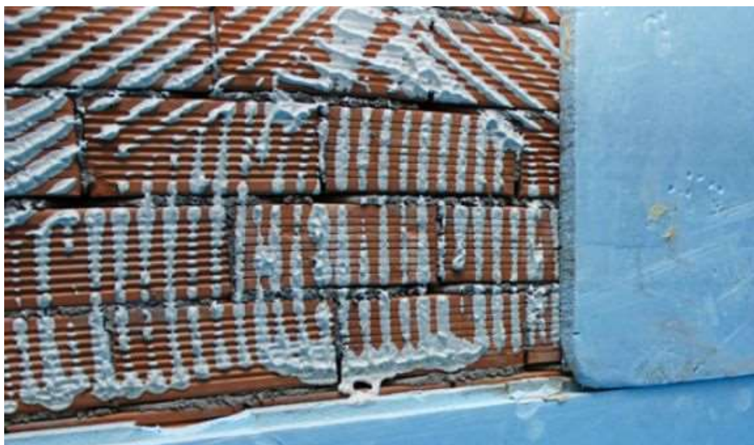
Εικόνα 28 Θερμομόνωση εξωτερικής επιφάνειας
