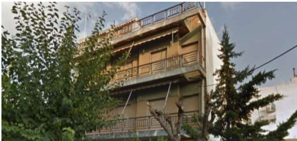
Εικόνα 10 Η πρόσοψη του κτιρίου μελέτης
