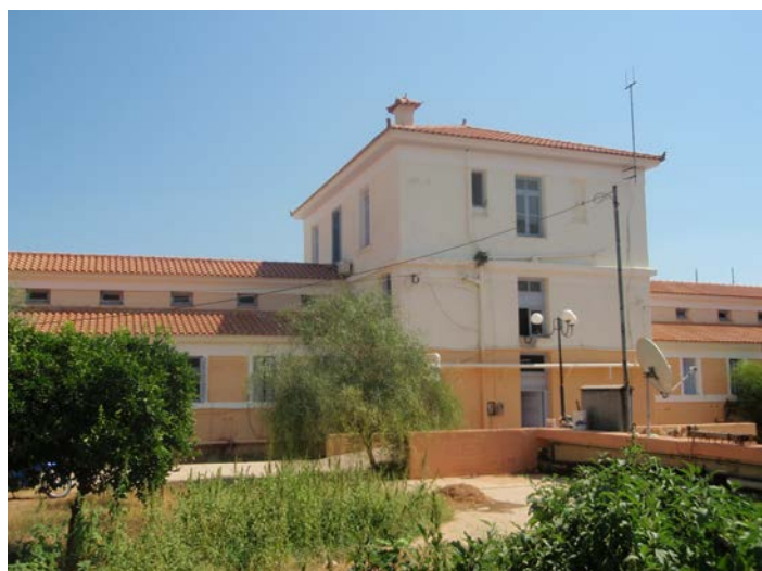
Φωτογραφία 3 Δυτική Όψη κτιρίου λουτρών
