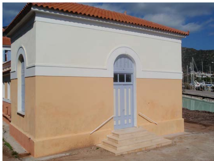
Φωτογραφία 2 Νότια Όψη κτιρίου λουτρών
