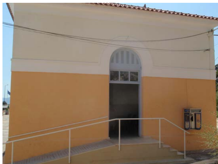
Φωτογραφία 4 Βόρεια Όψη κτιρίου λουτρών
