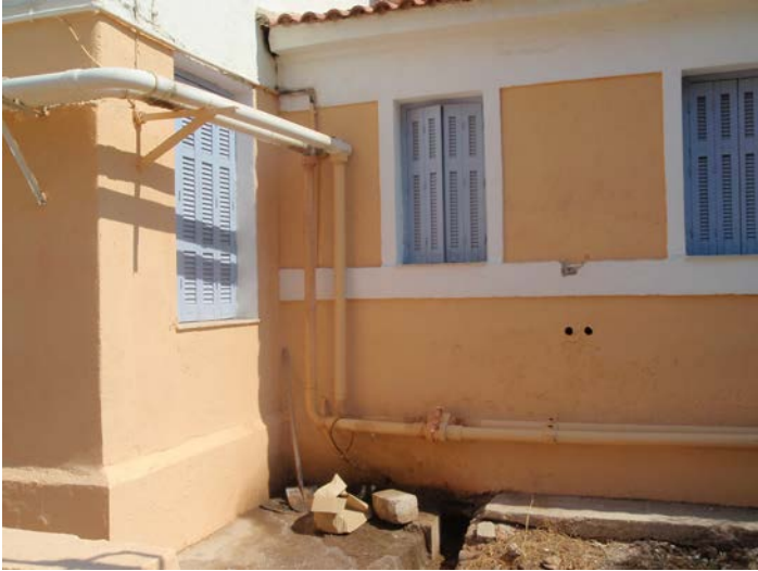
Φωτογραφία 13 Δυτική Όψη
