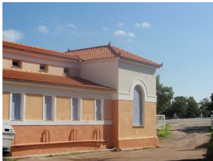
Φωτογραφία 6 Δυτική Όψη
