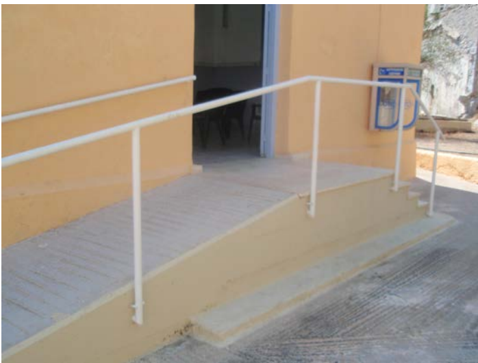
Φωτογραφία 15 Βόρεια Όψη
