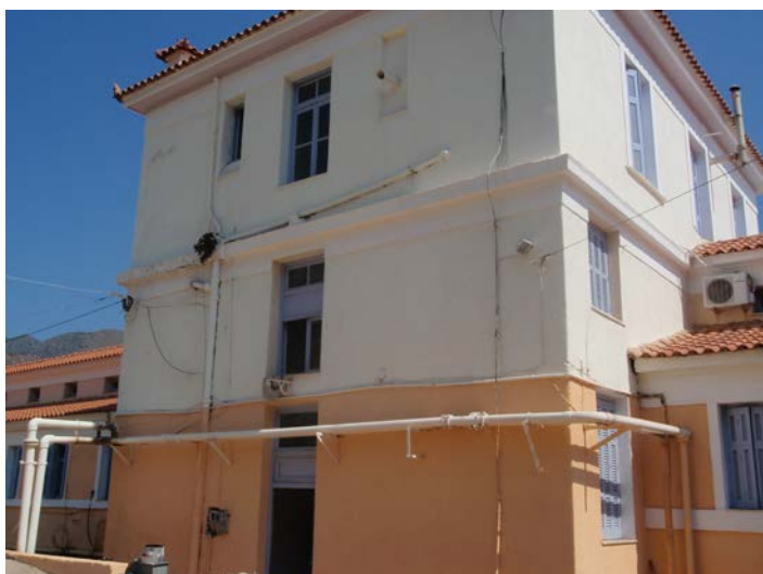
Φωτογραφία 11 Δυτική Όψη
