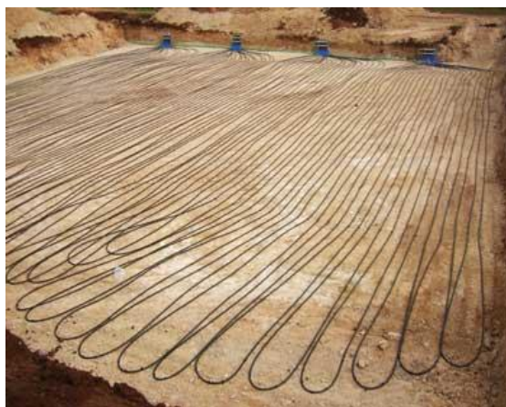
Εικόνα 66: Οριζόντιο Σύστημα Γεωθερμίας Κλειστού Κύκλου ( www.thermoymdravlikos.gr )
