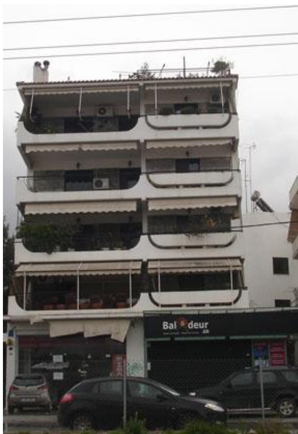
Εικόνα 15: Πεντάροφο κτίριο κατοικιών και ισογείων καταστημάτων επί της Ανατολικής πλευράς του οικοπέδου
