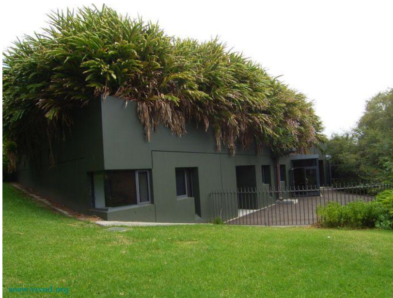
Εικόνα 51: Εντατικού τύπου φυτεμένη ταράτσα (cleanairforcities.blogspot.com)
