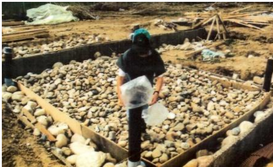
Εικόνα 35: Κατασκευή Rock Bed (www.evonymos.gr)
