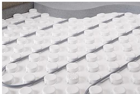
Εικόνα 71: Ενδοδαπέδια Σωλήνωση ( www.zeroenergyhomes.gr )
