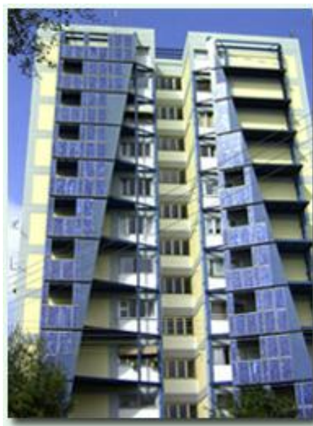
Εικόνα 62: Κτίριο με ενσωματωμένη πρόσοψη φωτοβολταϊκών ( http://biodomegr.blogspot.com )
