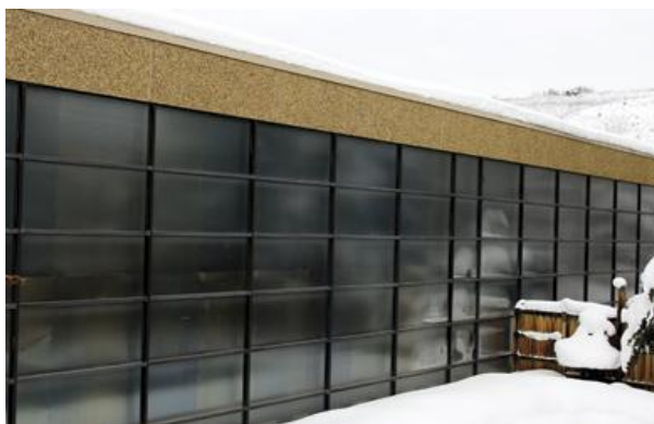
Εικόνα 24: Τοίχος Trombe στο Άσπεν (www.obermeyer.com)
