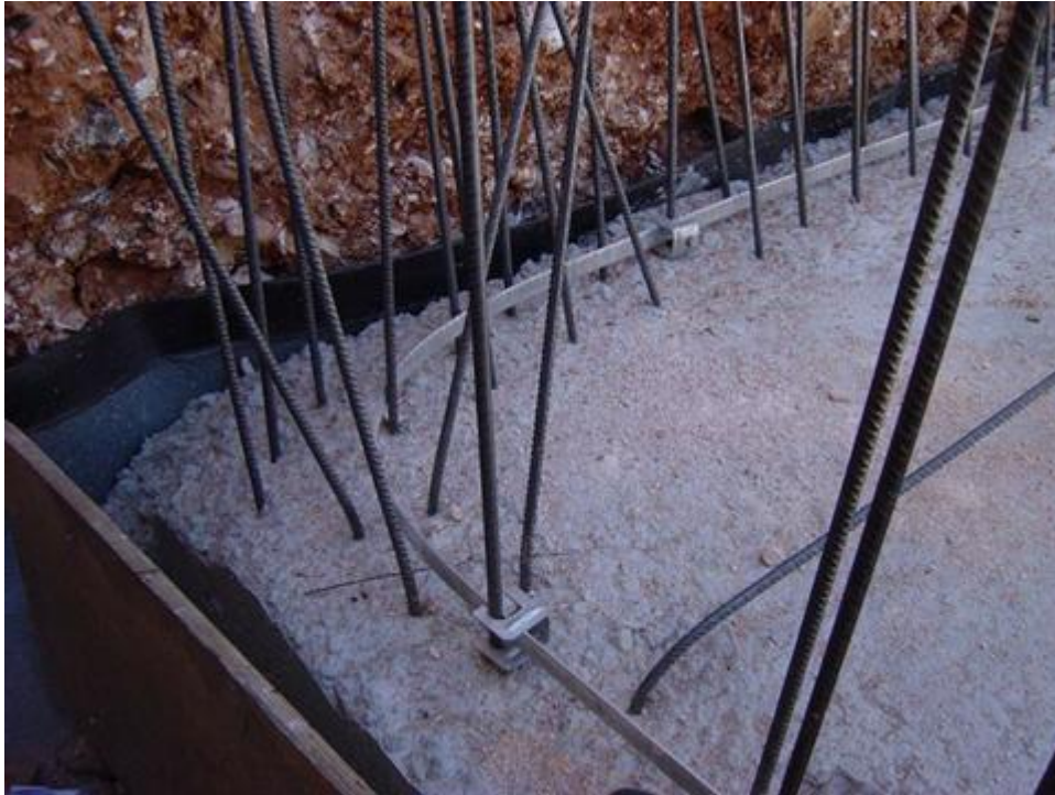
Σχήμα 1.3 Θεμελιακή γείωση
