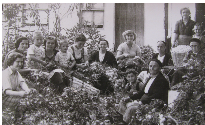
Εικόνα 11. Ξεκλάδωμα στη γειτονιά
