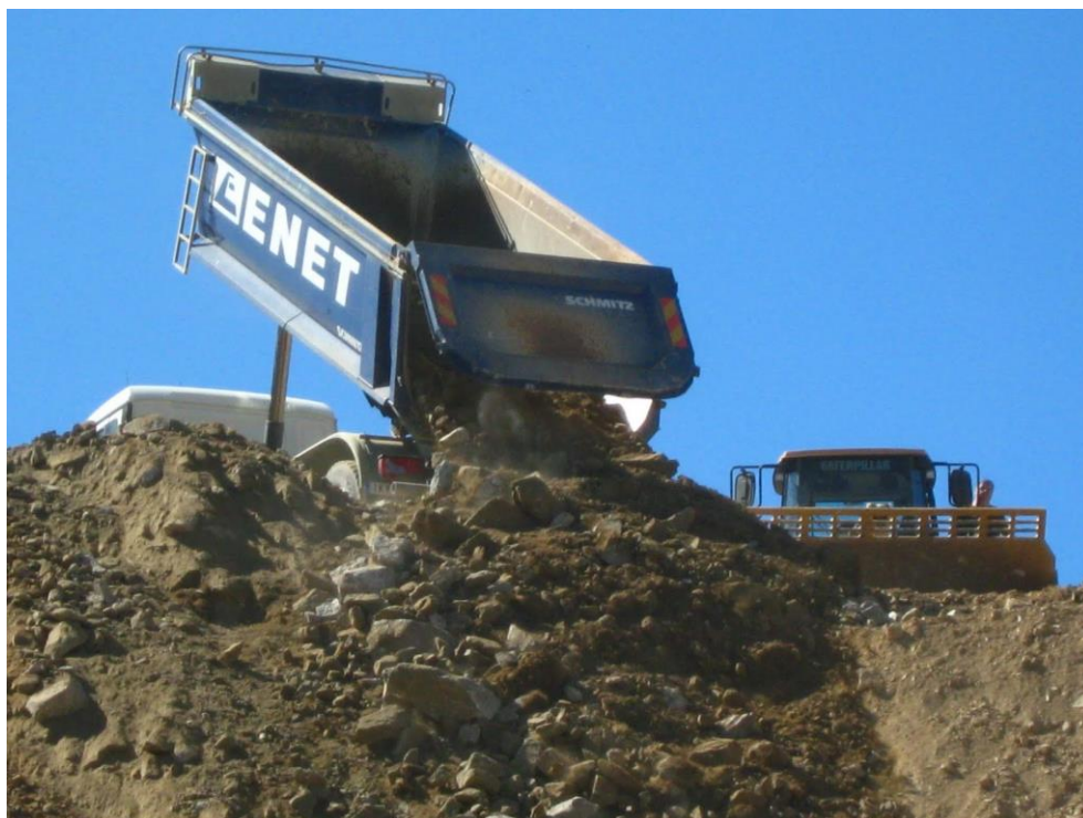
Εικόνα 15 Απόθεση μπαζών μέχρι την επιχωμάτωση της θεμελίωσης 25
