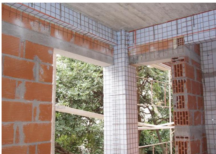
Εικόνα 24 Η εξωτερική τοιχοποιία κατασκευάζεται με διπλή σειρά τούβλων
