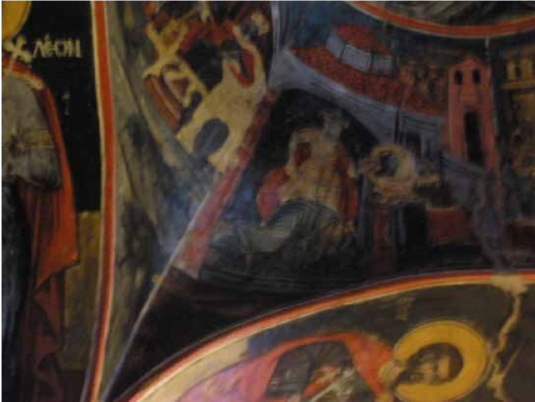
Εικόνα 16 : Ο τρούλος του αριστερού κλίτους του ναού. Στο κέντρο της εικόνας διακρίνεται η κοιλιά του πιθαριού
