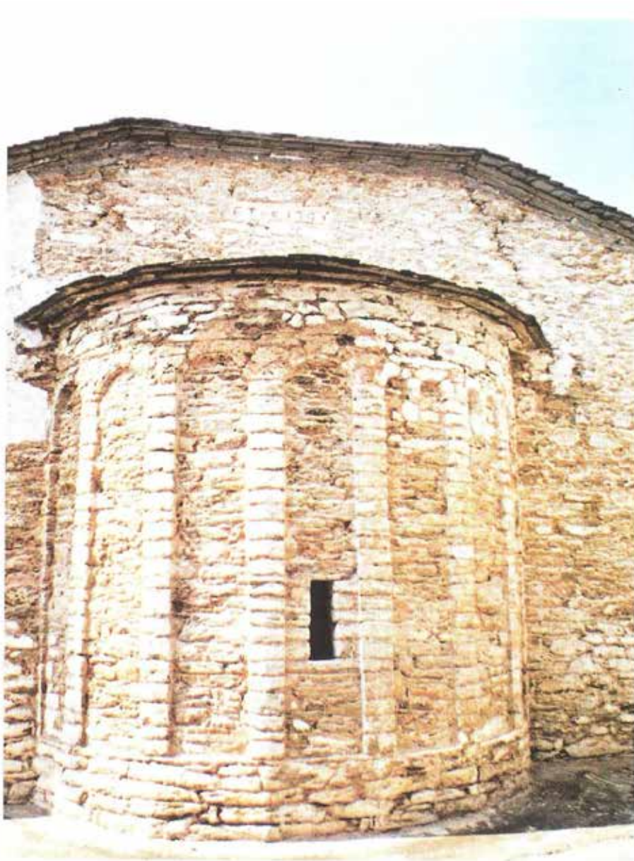
Εικόνα 22 : Η Ανατολική πλευρά του ναού. Φωτογραφία από την κόγχη του Ιερού μετά την αφαίρεση του επιχρίσματος για στεγανωτικές εργασίες. Βιβλίο: Νικολάου Παπαθεοδώρου "Ο ναός των Ταξιαρχών στις Μηλιές του Πηλίου", Μηλιές 2009 (Σελίδα : 33)
