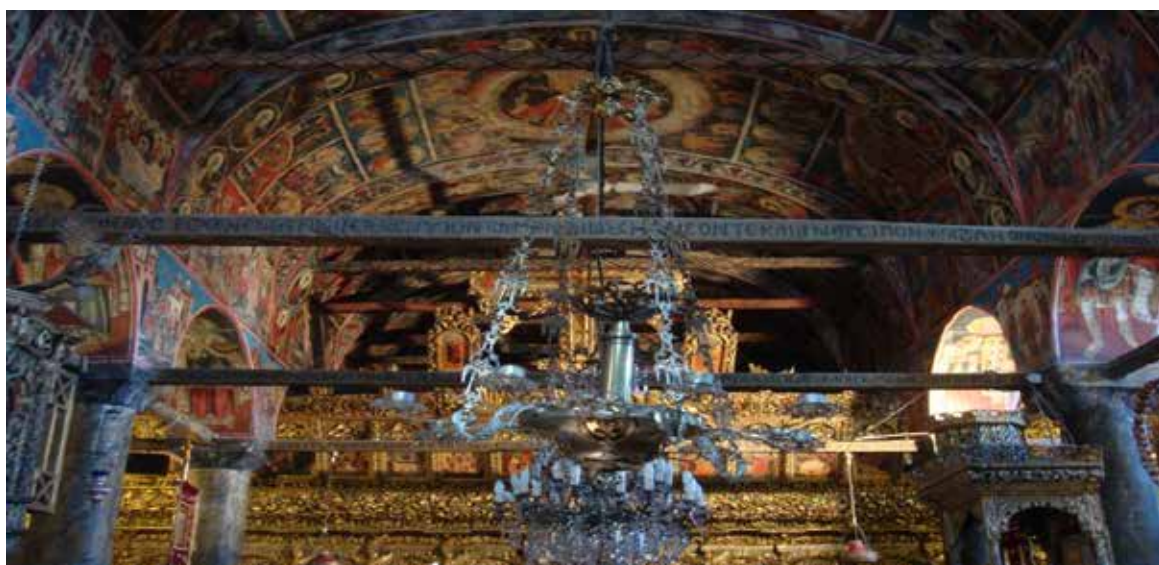
Εικόνα 24 : Οι ξύλινοι δοκοί στο μεσαίο κλίτος
