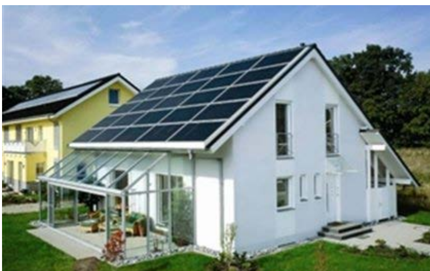
Εικ.3.1: Φωτοβολταϊκό σύστημα σε στέγη Πηγή: [59]
