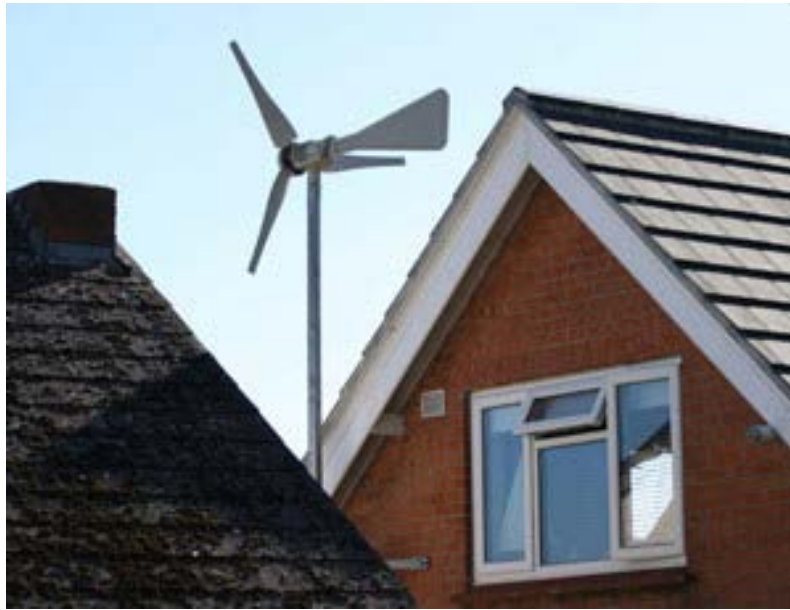
Εικ.3.8: Ανεμογεννήτρια οριζόντιου άξονα Πηγή: [66]
