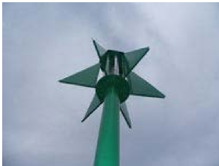
Εικ.3.9: Ανεμογεννήτρια κάθετου άξονα Πηγή: [67]
