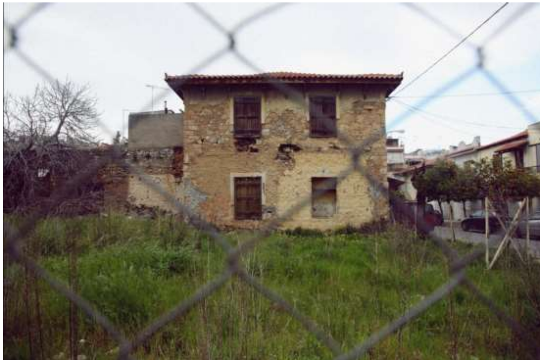
Εικόνα 2: Οικία χτισμένη με λίθους, μπετόν αρμέ και κεραμίδια 2
