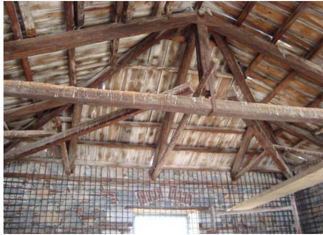
Εικ. 23, εσωτερική άποψη στέγης Πηγή: Προσωπικό αρχείο
