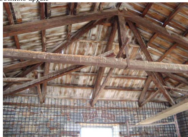
Εικ.50, εσωτερική άποψη στέγης Πηγή: Προσωπικό αρχείο
