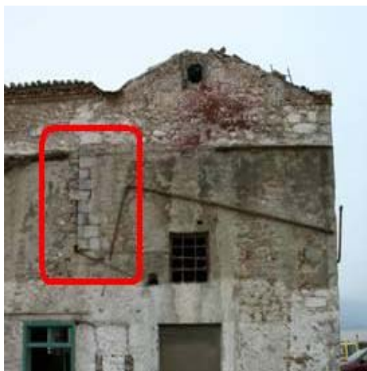
Εικ. 20. Οι δυο φάσεις κατασκευής Πηγή:Αρχείο Δήμου Χαλκίδας
