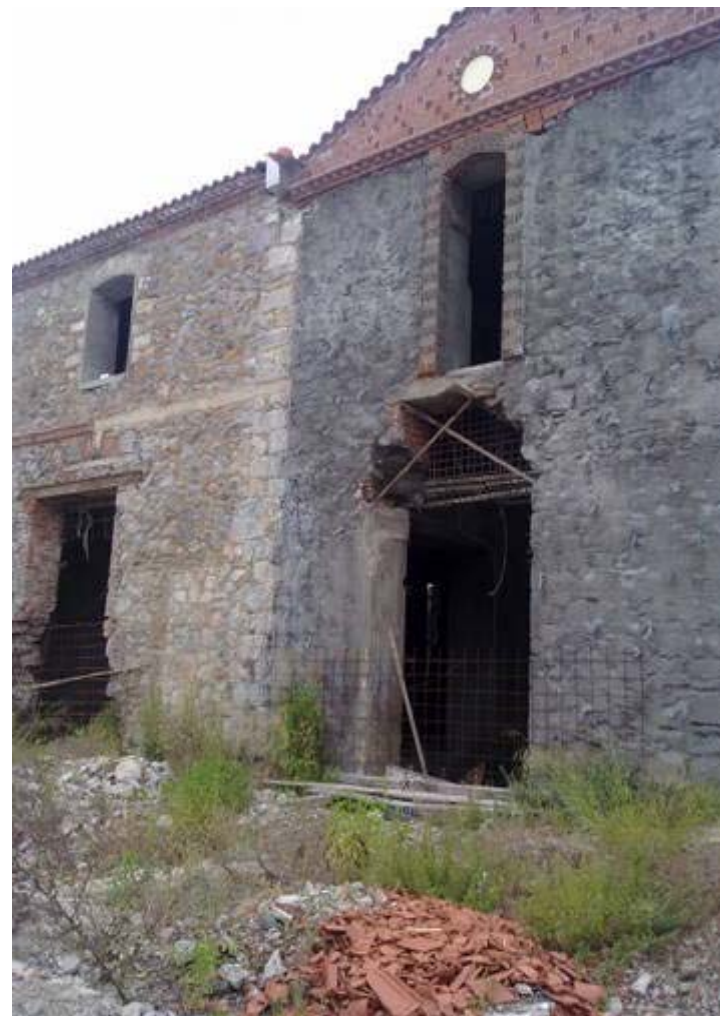
Εικ.38, ΥΦΙΣΤΑΜΕΝΗ ΑΝΑΤΟΛΙΚΗ ΟΨΗ Πηγή: Προσωπικό αρχείο
