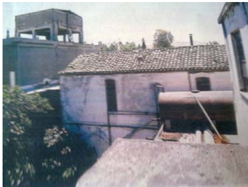
Εικ. 22, Δεξαμενές δίπλα από το κτίριο Πηγή: Αρχείο Δήμου Χαλκίδας
