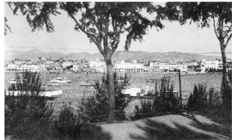
Εικ.44, Εγκαταστάσεις ΑΣΑΧ 1910
