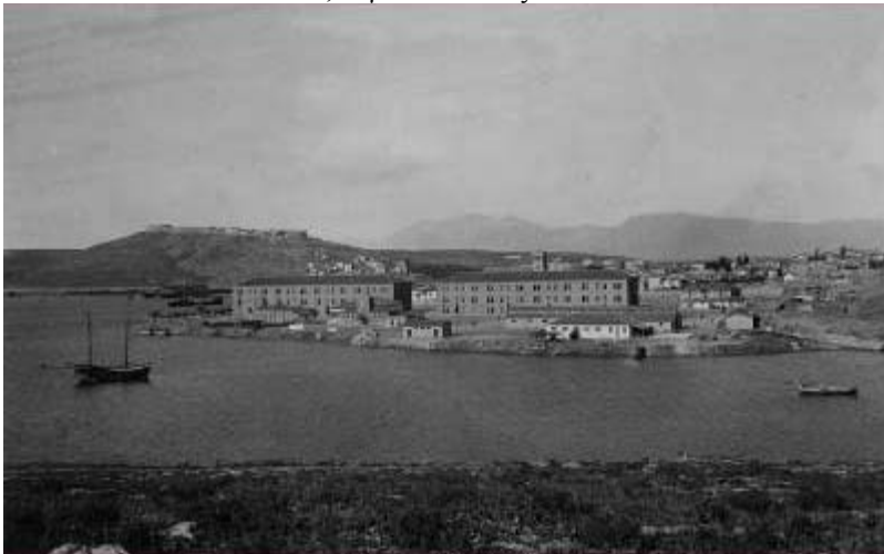
Εικ.45, Εγκαταστάσεις ΑΣΑΧ 1930
