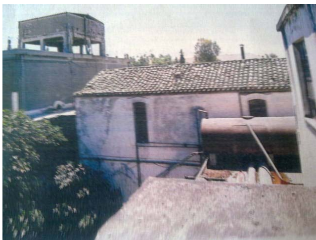
Εικ.55, Βοηθητικά κτίσματα Πηγή: Αρχείο Δήμου Χαλκίδας
