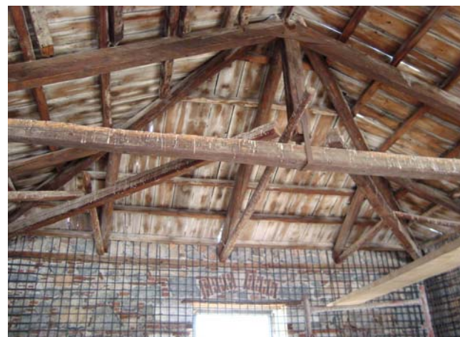
Εικ.48, εσωτερική άποψη στέγης Πηγή: Προσωπικό αρχείο
