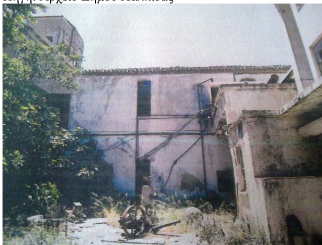
Εικ.57, Βοηθητικά κτίσματα Πηγή: Αρχείο Δήμου Χαλκίδας
