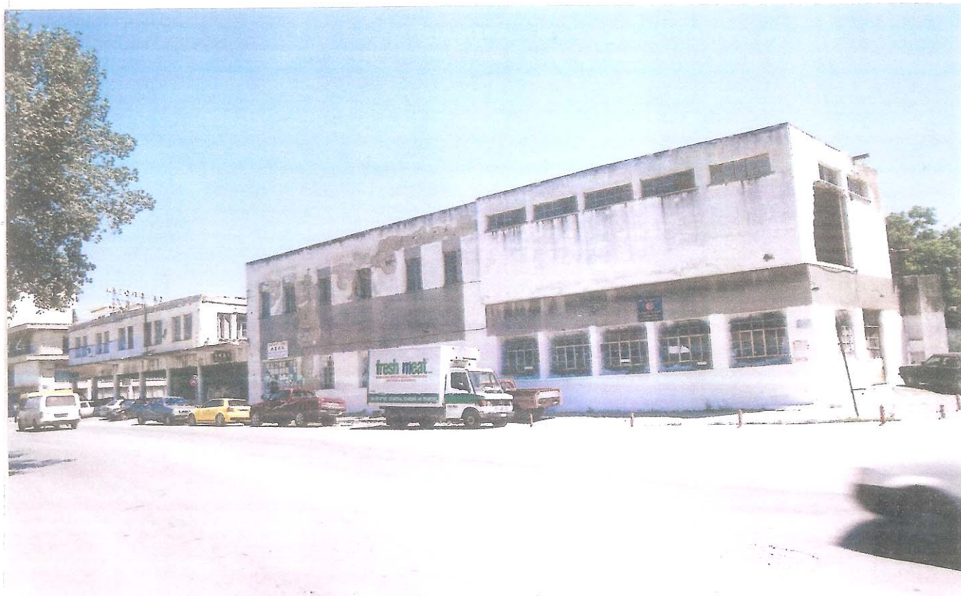
Εκ 31, Το κτίριο ΑΣΑΧ, πριν την κατεδάφιση των βοηθητικών κτισμάτων του 2004 Πηγή:Αρχείο Δήμου Χαλκίδας
