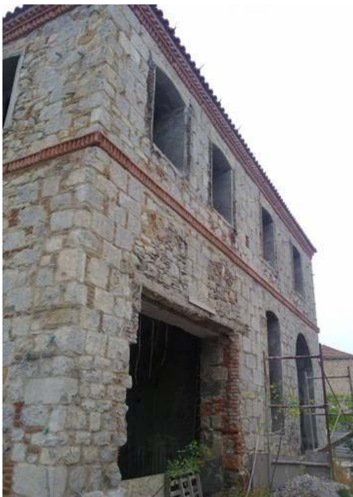
Εικ.37, ΥΦΙΣΤΑΜΕΝΗ ΔΥΤΙΚΗ ΟΨΗ Πηγή: Προσωπικό αρχείο
