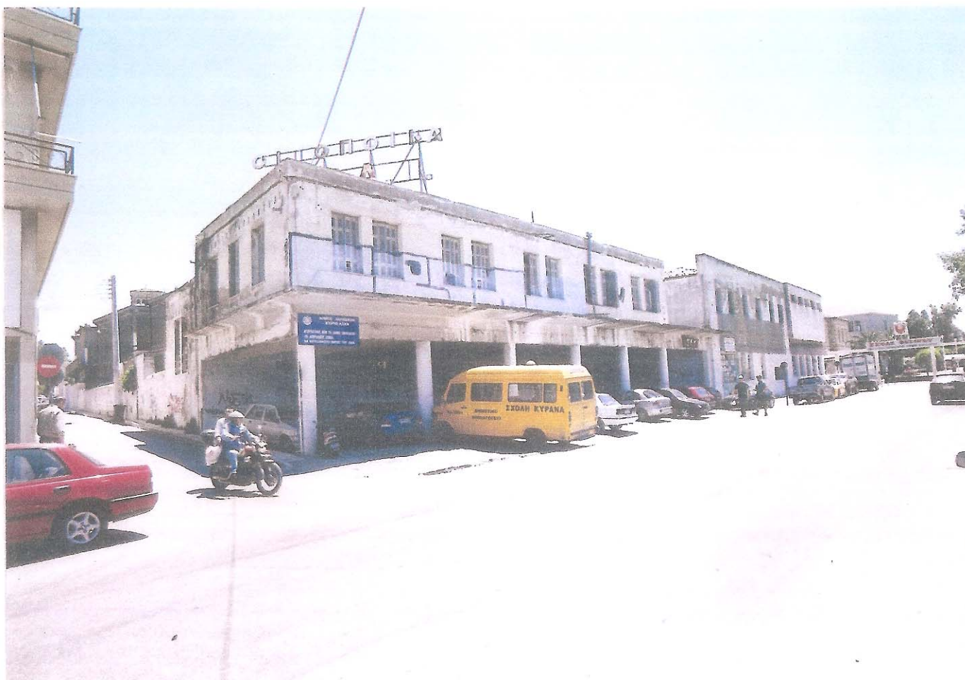
Εκ 32, Το κτίριο ΑΣΑΧ, πριν την κατεδάφιση των βοηθητικών κτισμάτων του 2004 Πηγή:Αρχείο Δήμου Χαλκίδας
