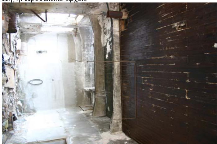
Εικ.53, Εσωτερικό τμήμα του κτιρίου Πηγή: Προσωπικό αρχείο
