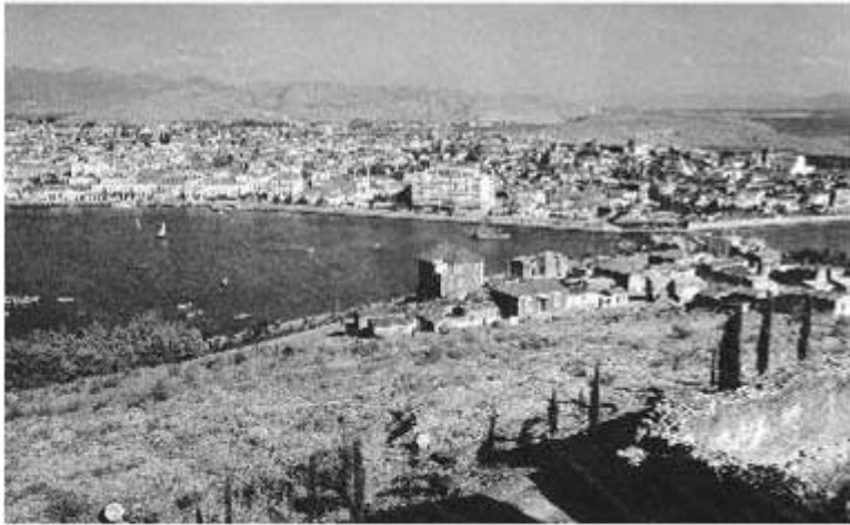
Εικ.43, Εγκαταστάσεις ΑΣΑΧ 1910
