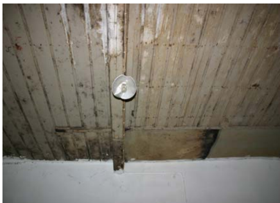
Εικ. 25, Οροφή κτιρίου Πηγή: Προσωπικό αρχείο
