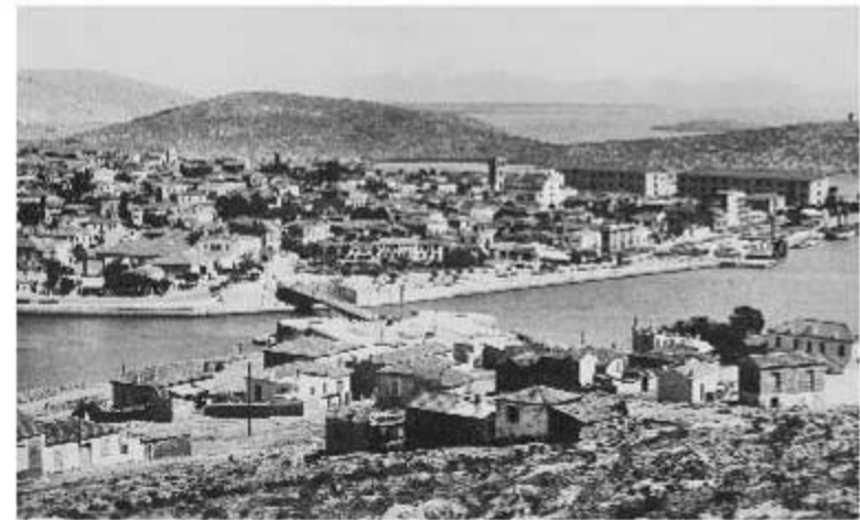
Εικ.46, Εγκαταστάσεις ΑΣΑΧ 1934
