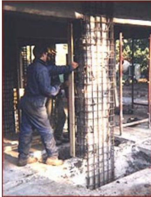
Εικόνα 6: Τοποθέτηση οπλισμού για την ενίσχυση με μανδύα οπλισμένου σκυροδέματος
