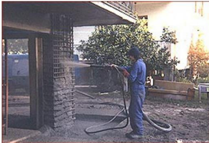
Εικόνα 7: Χρήση εκτοξευόμενου σκυροδέματος για την επικάλυψη του πρόσθετου οπλισμού
