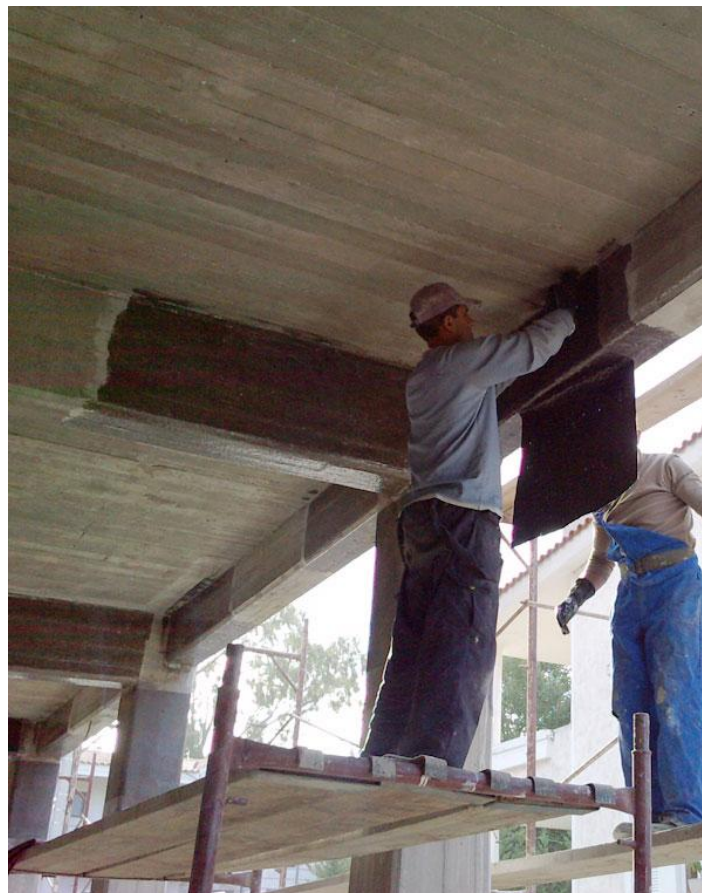
Εικόνα 14: Ενίσχυση Δοκού με Ινοπλισμένα πολυμερή Υλικά (FRP)
