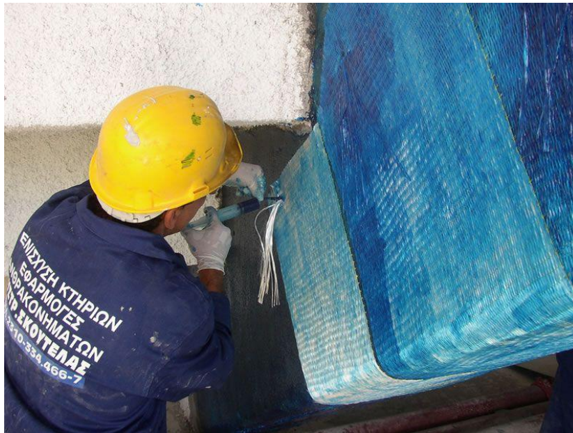
Εικόνα 13: Ενίσχυση με Ινοπλισμένα Πολυμερή Υλικά (FRP)
