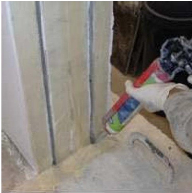
Εικόνα 8: Πρόσθετοι Οπλισμοί σε Εγκοπές
