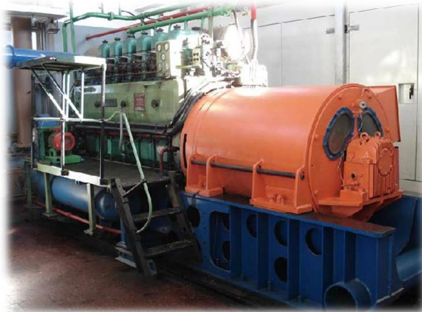
Εικόνα 2.b: Μια εκ των δύο Η/Ζ Seglielski (550kW) του ΤΣΠ-Αμοργού
