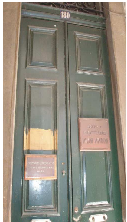
Εικ.2.27 Εξώθυρα ημιώροφου.
