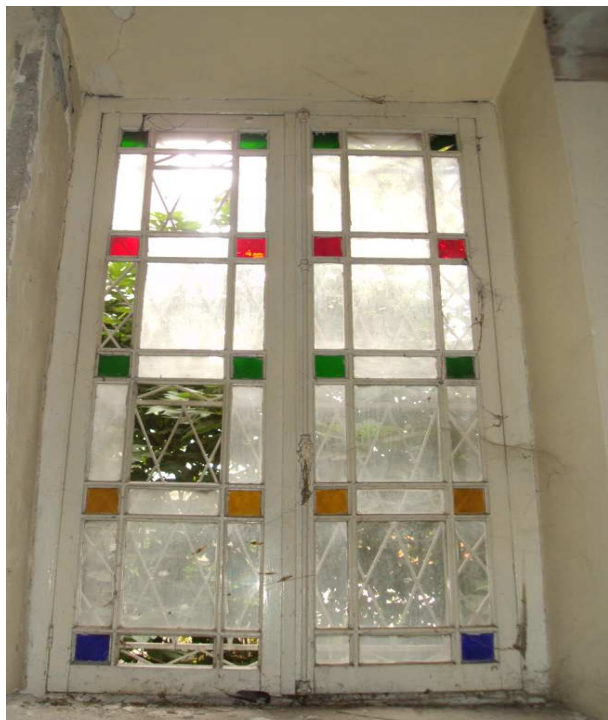
Εικ.2.37 Δίφυλλο παράθυρο χωρίς εξώφυλλα, στο κλιμακοστάσιο του ορόφου. Θέα στον ακάλυπτο χώρο.
