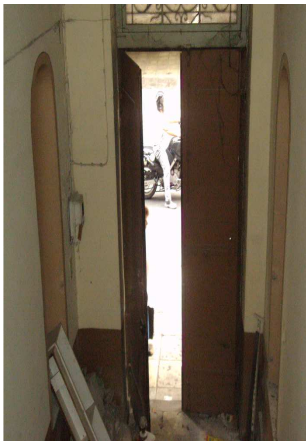
Εικ.2.21 Κύρια είσοδος με υπέρθυρο και εσωτερικά Κοίλα επιτοίγια διακοσμητικά, που οδηγεί στον όροφο.
