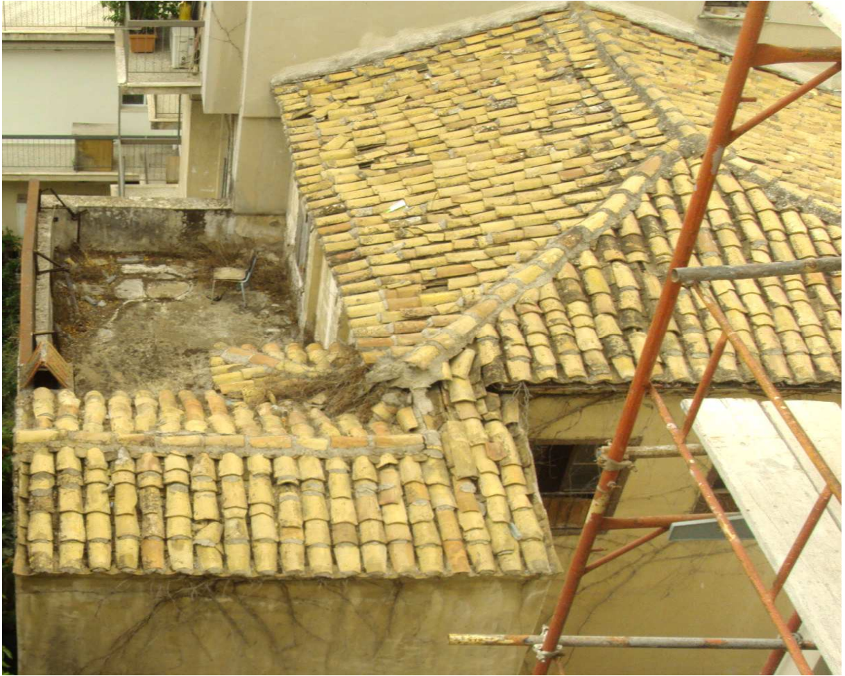
Εικ.2.56 Στέγη του κεντρικού κλιμακοστασίου και στέγη του δώματος.
