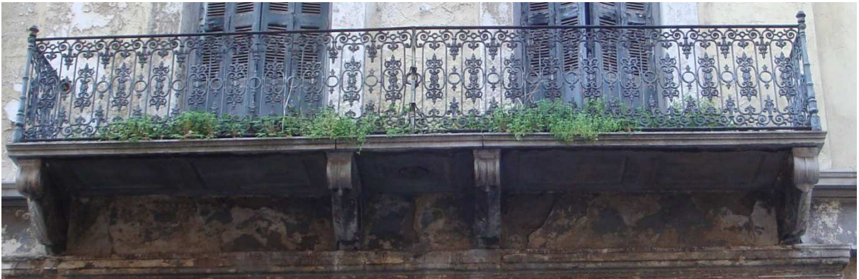
Εικ.2.43 Εξώστης ορόφου στην πρόσοψη του κτηρίου.
