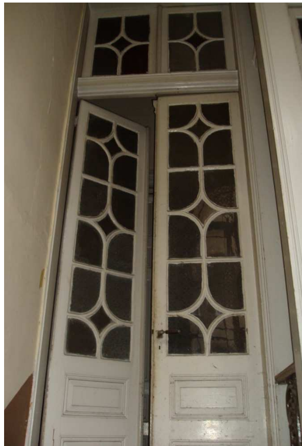
Εικ.2.22 Ξύλινη πόρτα με υπέρθυρο που οδηγεί στο προθάλαμο του ορόφου.
