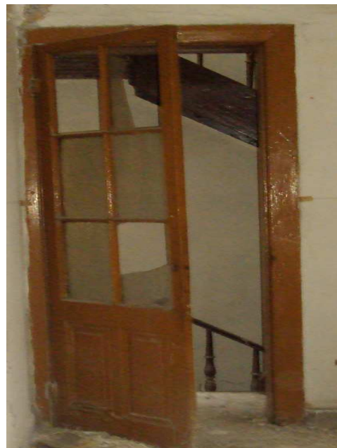
Εικ.2.42 Κεντρικό κλιμακοστάσιο.
