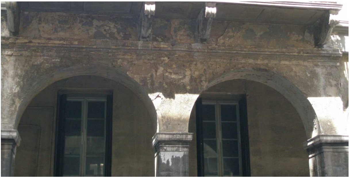
Εικ.2.7 Σημερινή εικόνα της τοξωτής στοάς με πεσσούς κατασκευασμένους με λαξευμένη πέτρα.
