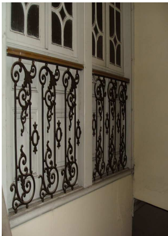
Εικ.2.12 Σφυρήλατη σιδεριά με ξύλινη κουπαστή στην εξωτερική πλευρά του προθάλαμου.
