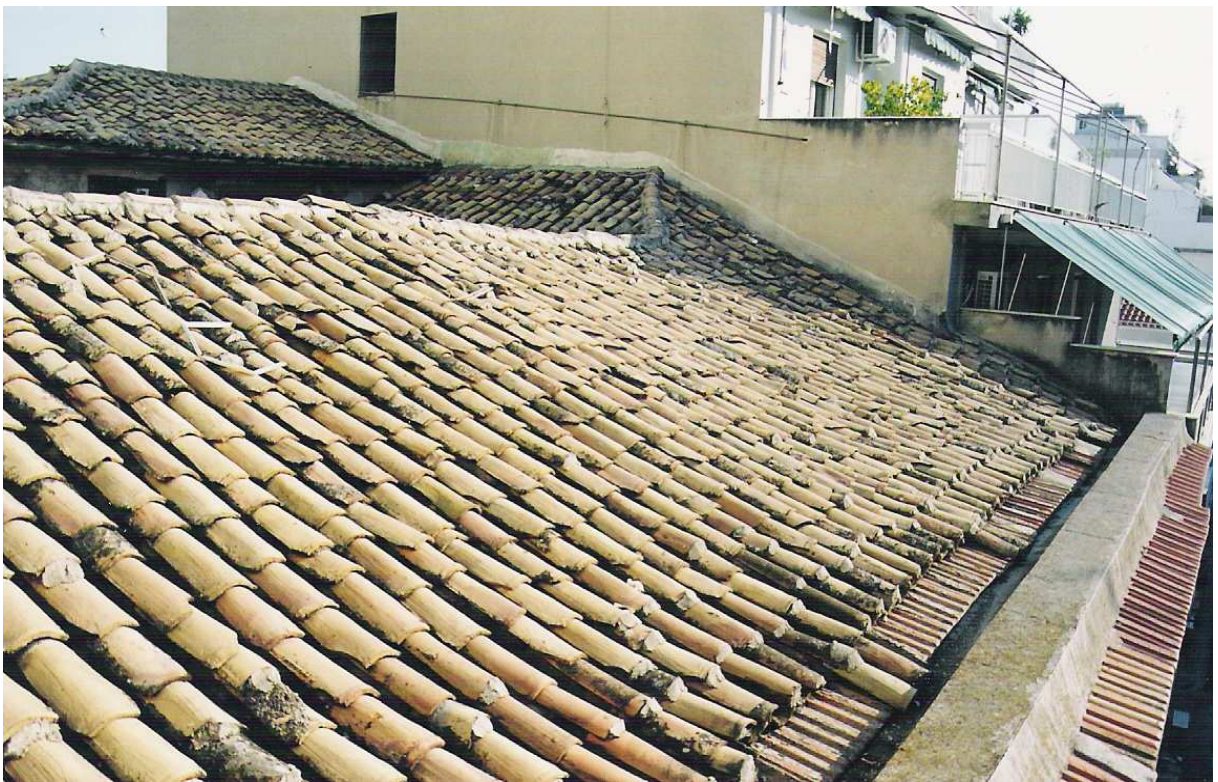
Εικ.2.55 Δίρριχτη στέγη κυρίως κτιρίου.
