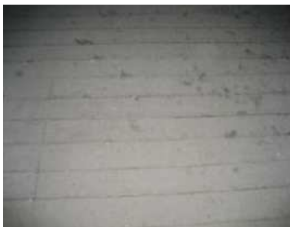
Εικ.2.24 Δάπεδο ορόφου από ξύλινες σανίδες.
