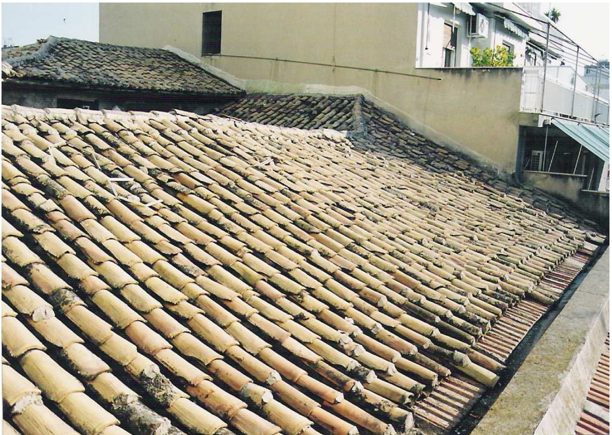
Εικ.2.80 Στέγη από κολυμβητά βυζαντινά κεραμίδια.
