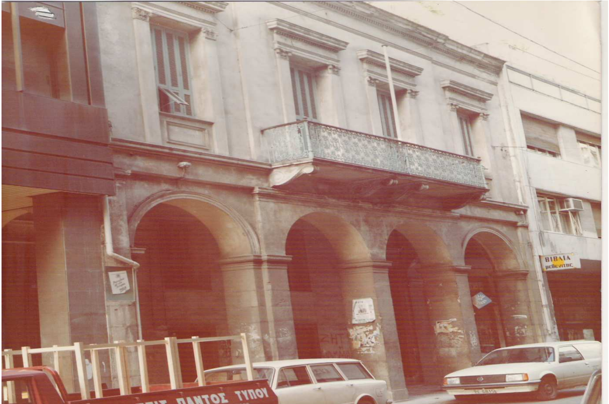
Εικ.2.14 Πρόσοψη Αργυροπούλειου Δημοτικού κτιρίου επί της οδού Κανακάρη στον αριθ. 180-182.(Πηγή: 2 η Εφορεία Νεοτέρων Μνημείων).
