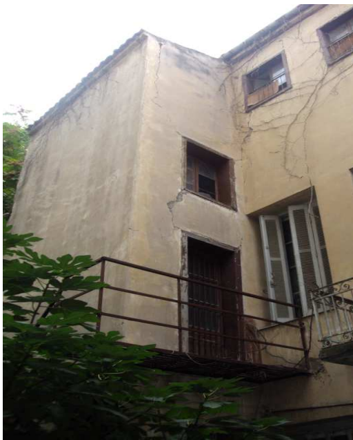
Εικ.2.41 Κεντρικό κλιμακοστάσιο.
