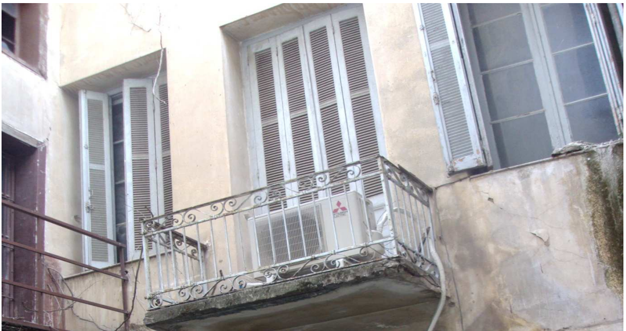
Εικ.2.33 Εξωστόθουρα και παράθυρα ορόφου με γαλλικού τύπου εξώφυλλα. Θέα στον ακάλυπτο. χώρο.
