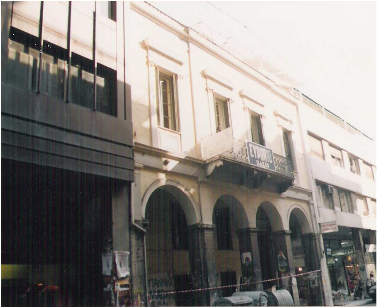
Εικ.2.3 Πρόσοψη Αργυροπούλειου Δημοτικού κτιρίου επί της οδού Κανακάρη στον αριθ. 180-182. (1993). (Πηγή: 2 η Εφορεία Νεοτέρων Μνημείων Πάτρας).
