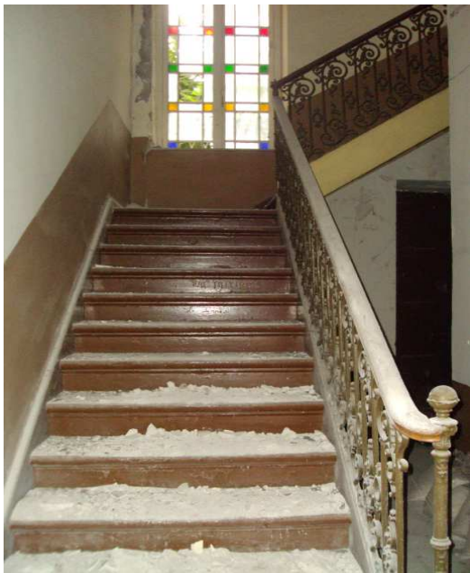
Εικ.2.39 Κλιμακοστάσιο ορόφου.
