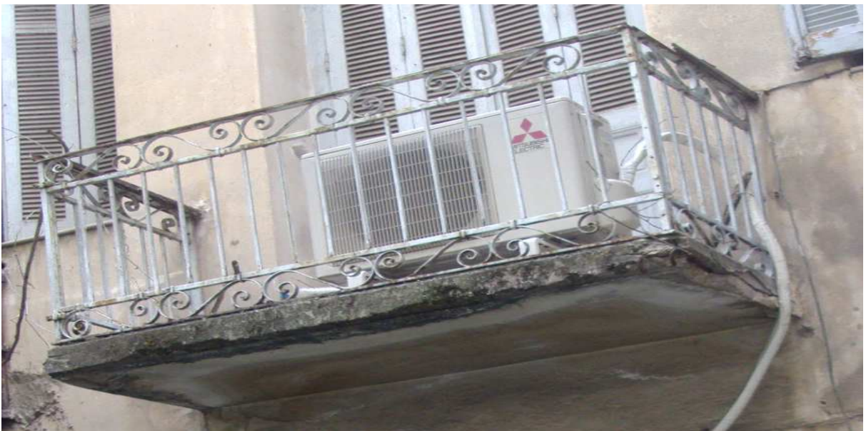
Εικ.2.44 Εξώστης ορόφου με θέα τον ακάλυπτο χώρο.
