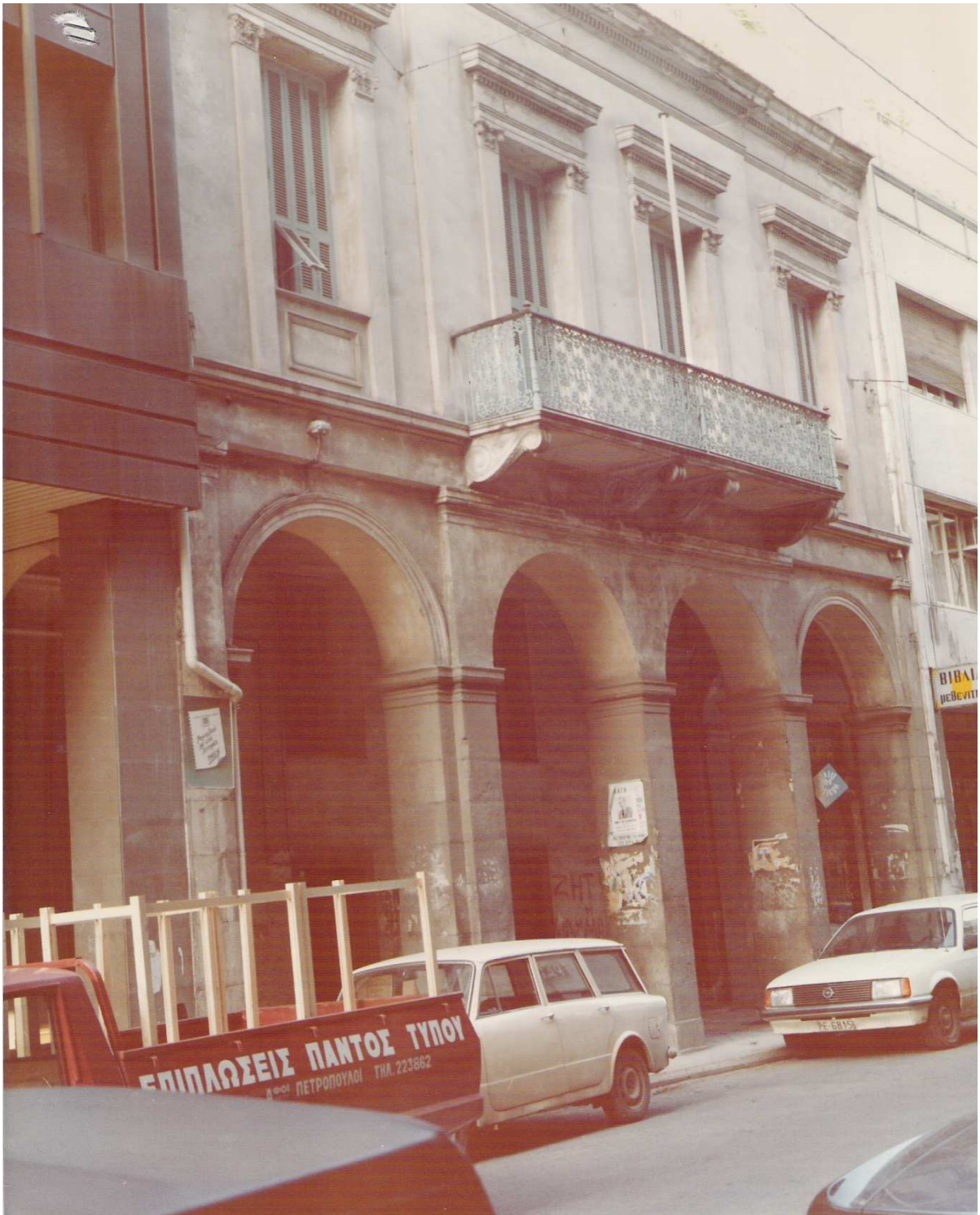
Εικ.2.4 Πρόσοψη Αργυροπούλειου Δημοτικού κτιρίου επί της οδού Κανακάρη στον αριθ. 180-182. (1999). (Πηγή: Υπηρεσία Νεοτέρων Μνημείων και Τεχνικών Έργων Δυτικής Ελλάδος).
