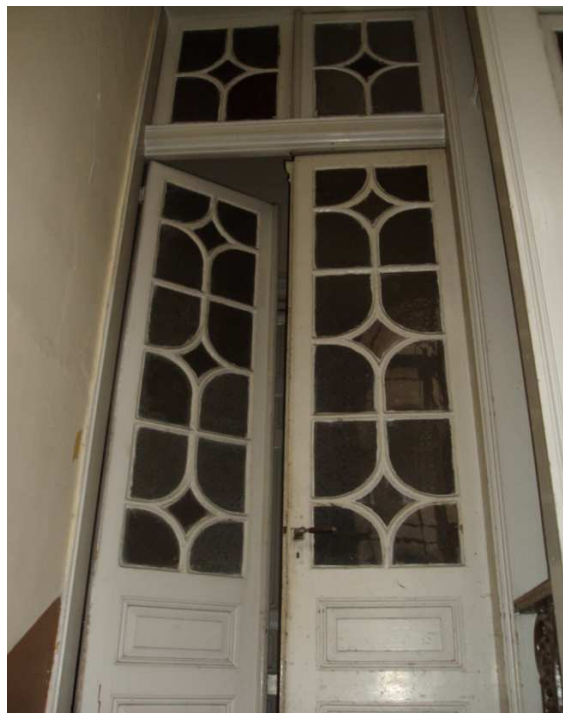
Εικ.2.38 Δίφυλλη ταμπλαδοτή πόρτα με φεγγίτη και υπέρθυρο στην είσοδο του προθάλαμου του ορόφου.
