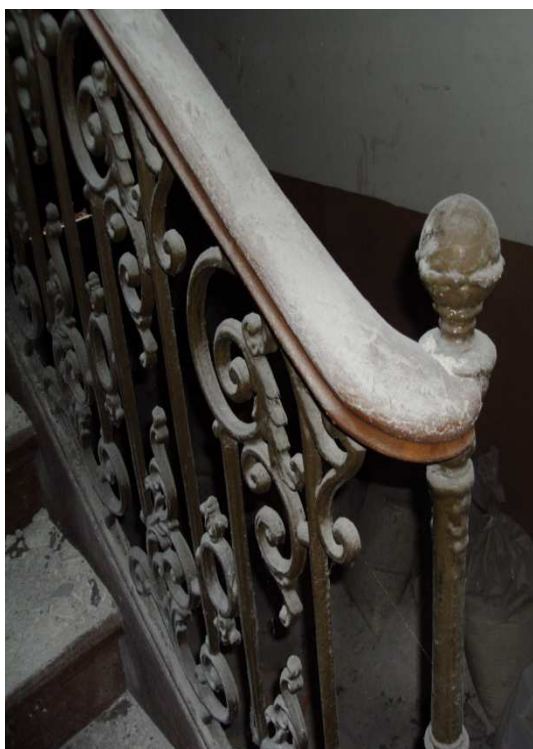
Εικ.2.69 Κιγκλιδώμα και χειρολισθήρας.
