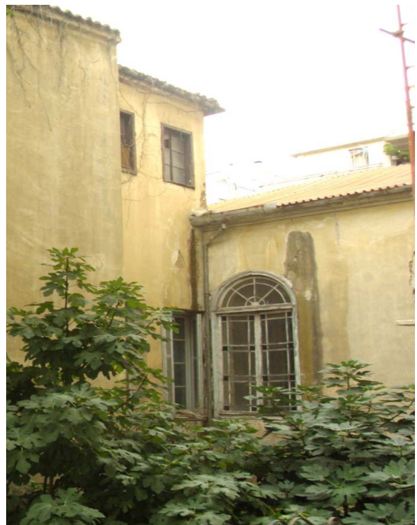
Εικ.2.19 Παράθυρο κλιμακοστασίου εξωτερικά.
