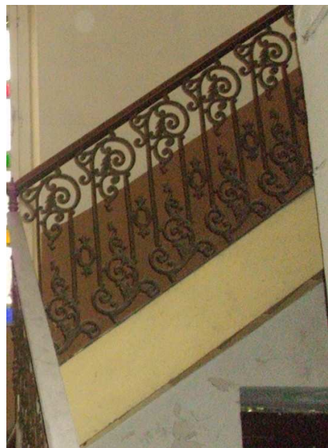
Εικ.2.40 Κλιμακοστάσιο ορόφου.
