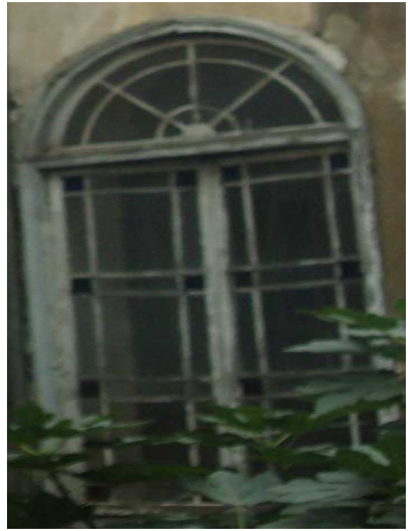
Εικ.2.36 Δίφυλλο παράθυρο με τοξωτό υπέρθυρο εξωτερικά στο κλιμακοστάσιο του ορόφου.
