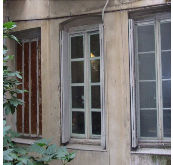
Εικ.2.32 Παράθυρα ημιώροφου με γαλλικού τύπου εξώφυλλα. Θέα στον ακάλυπτο χώρο.
