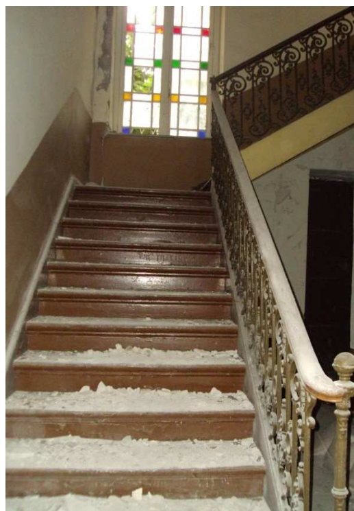
Εικ.2.70 Κλιμακοστάσιο ορόφου.
