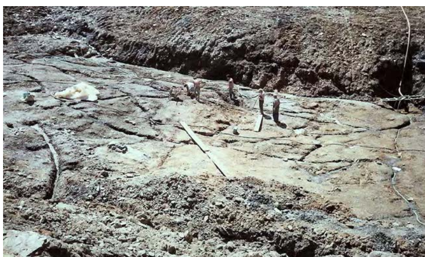
Φωτο (17). Εργασίες Υδρομαστεύσεων
