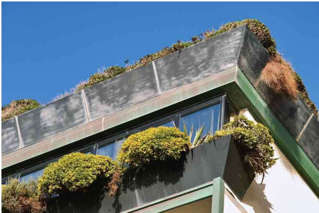
Εικόνα 40 Τα «πράσινα δώματα» προστατεύουν τα κτίρια από τη φωτιά 20
