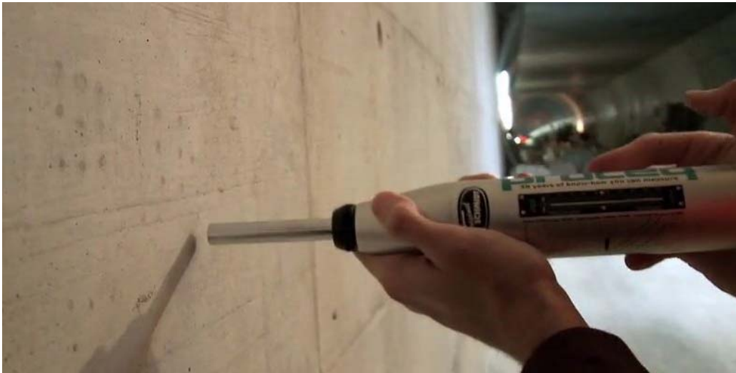
Εικόνα 8: Κρουσιμέτρηση σε κατακόρυφο στοιχείο.
