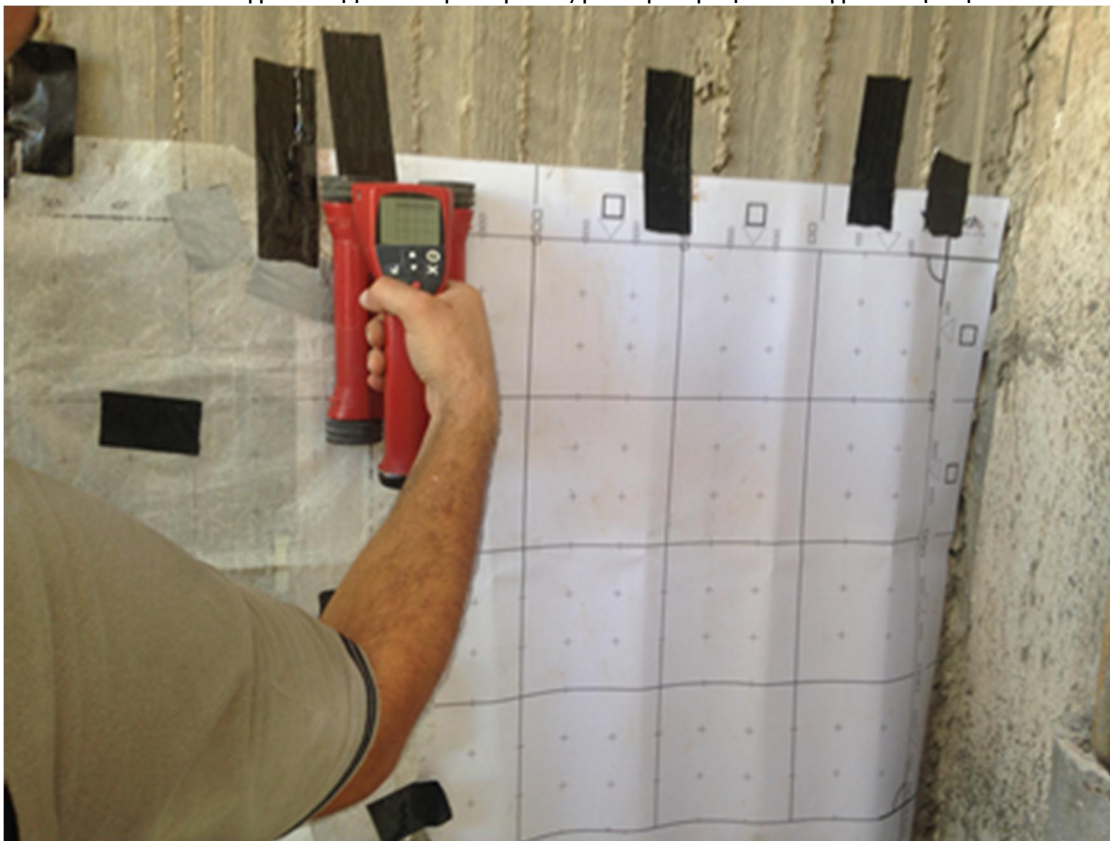
ΦΩΤ. 4 : Ανίχνευση ράβδων οπλισμού.
