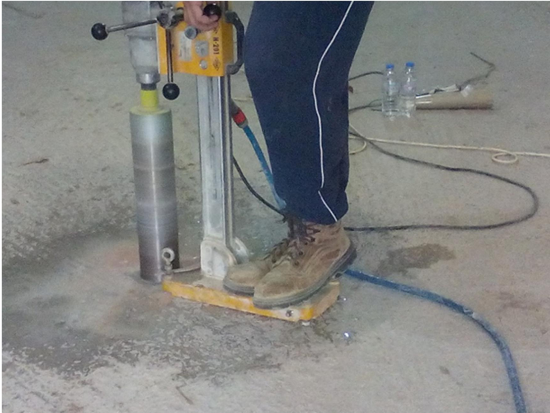
ΦΩΤ. 3: Δειγματοληψία σκυροδέματος με περιστροφικό δειγματολήπτη.
