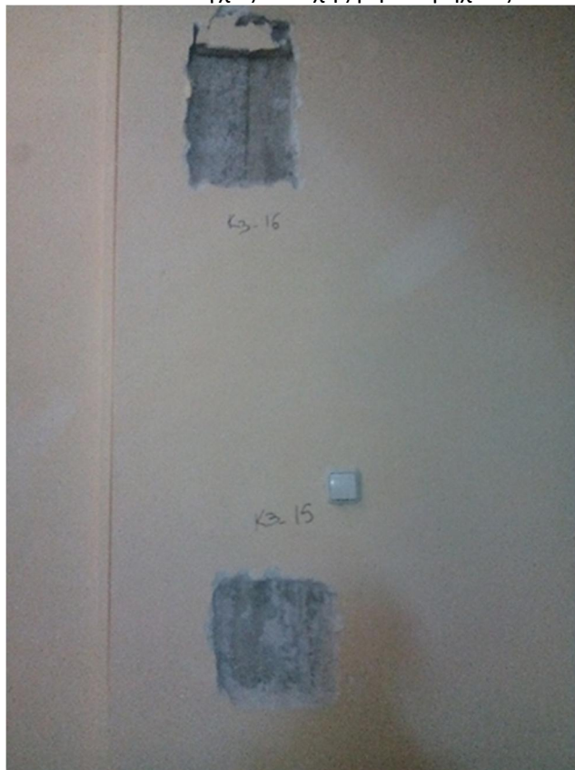
ΦΩΤ. 6 : Αφαίρεση επιχρίσματος για έλεγχο αντοχής με κρουσίμετρο.
