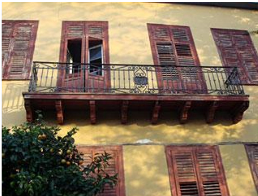
Εικόνα 3 (4) Λεπτομέρεια ξύλινου εξώστη
