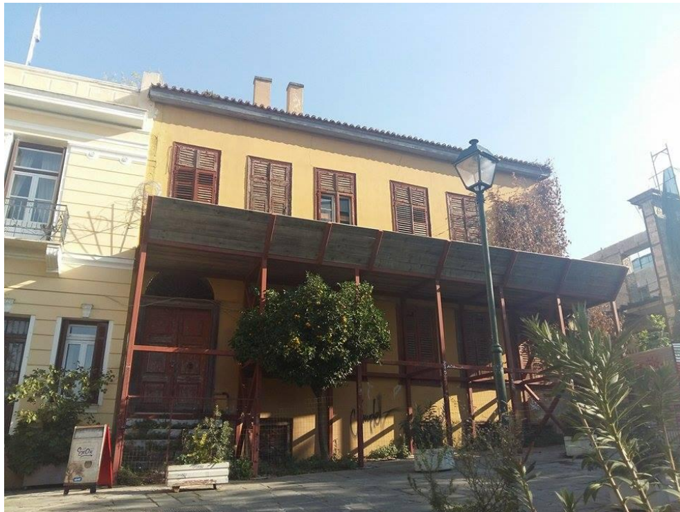
Εικόνα 6 (Προσωπικό Αρχείο) Πρόσοψη κτιρίου 2015
