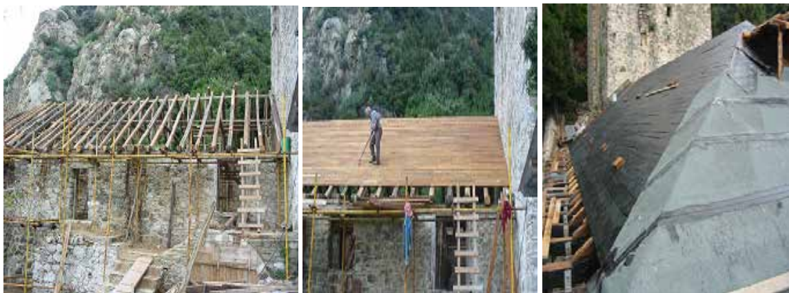
Εικόνα 5.65 Στάδια ανακατασκευής της στέγης του αρσανά
