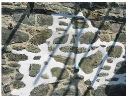
Εικόνα 4.9 Επισκευή ρωγμής σε τοιχοποιία του αρσανά Σιμωνόπετρας
