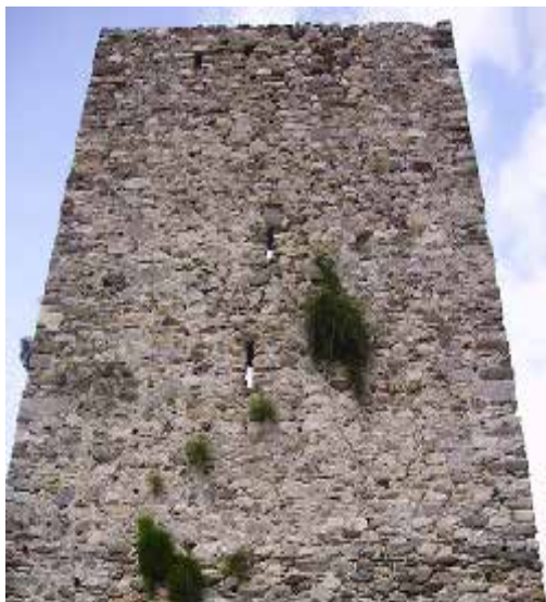
Εικόνα 5.20 Όψη Πύργου όπου διακρίνονται και οι πολεμίστρες
