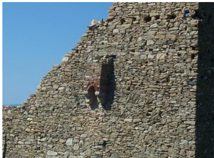
Εικόνα 5.9 Η καταχύστρα της ανωδομής. Διακρίνονται οι δοκοθήκες της τελευταίας στάθμης
