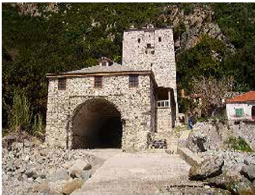
Εικόνα 5.58 Μετά την αποκατάσταση
