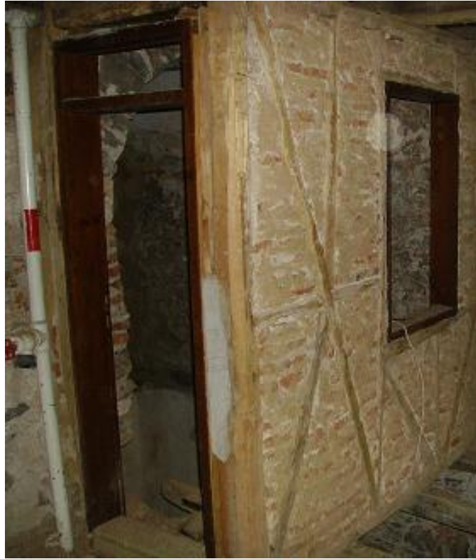
Εικόνα 3.4 Ο τσατιμάς κατά τη διάρκεια εργασιών στην Ι.Μ.Σίμωνος Πέτρας
