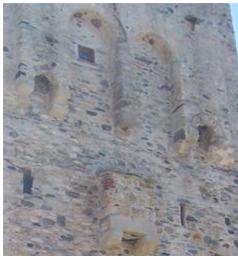
Εικόνα 5.28 Οι καταχύστρες της ανατολικής πλευράς
