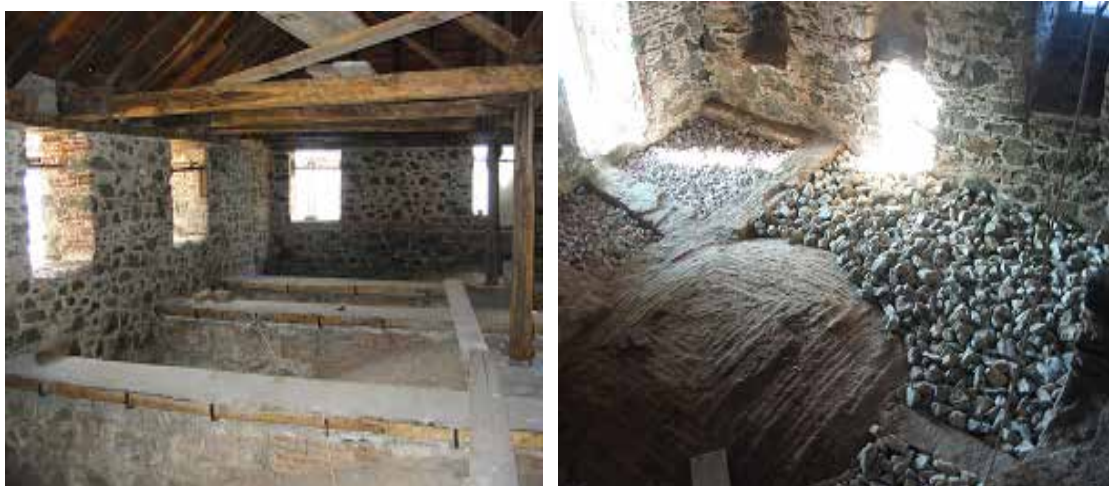
Εικόνα 5.64 Απομάκρυνση των μπαζών και διαμόρφωση τελικής στάθμης για τη δημιουργία δαπέδου από μεγάλους, αργούς λίθους
