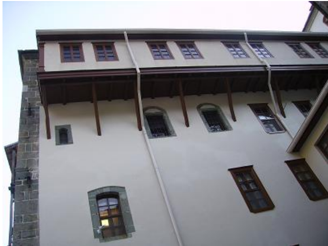
Εικόνα 3.5 Σαχνισί στην στην Ι.Μ.Σίμωνος Πέτρας
