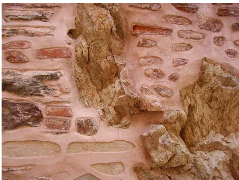
Εικόνα 5.50 Τα επιχρίσματα στη εξωτερική τοιχοποιία
