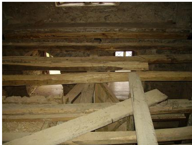
Εικόνα 3.8 Ο ξύλινος σκελετός στην Ι.Μ.Σίμωνος Πέτρας
