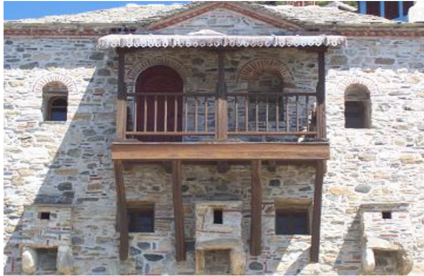
Εικόνα 5.34 Οι καταχύστρες του πρώτου ορόφου και ο πρόβολος του δεύτερου
