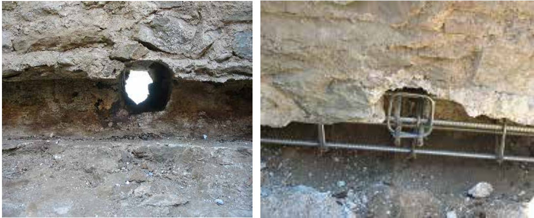
Εικόνα 4.10 Αντικατάσταση ξύλινων δοκών με οπλισμένο σκυρόδεμα
