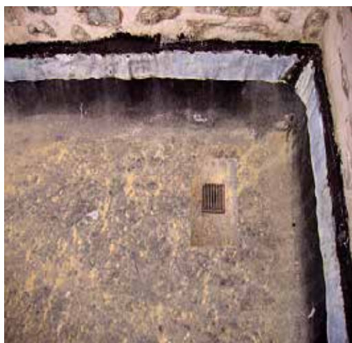
Εικόνα 5.48 Επιστρωση ασφαλτικού υλικού και συλλεκτήρες απορροής
