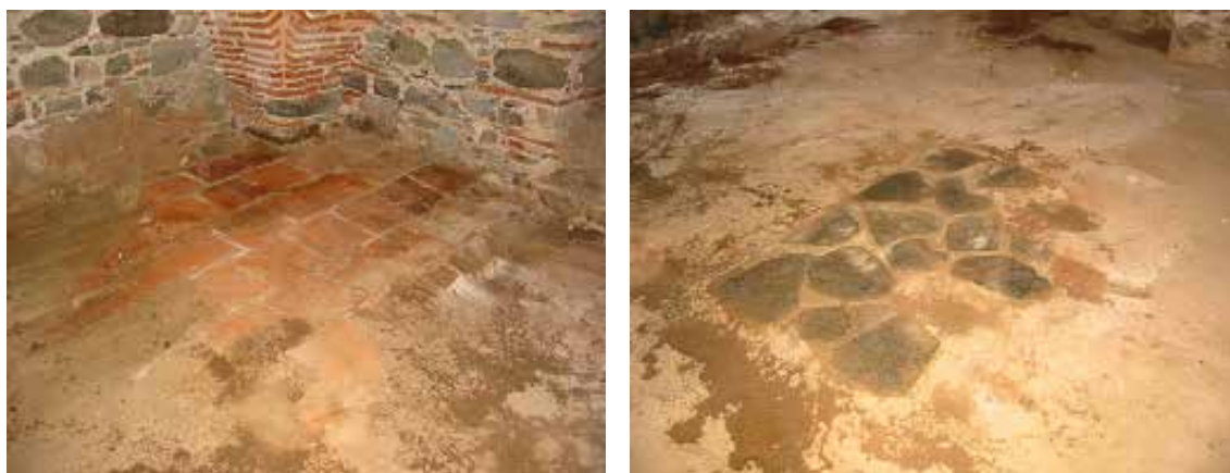
Εικόνα 5.61 Αντικατάσταση υφιστάμενου δαπέδου
