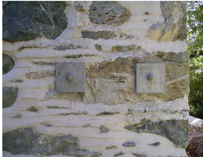
Εικόνα 4.7 Ελκυστήρες στην εξωτερική πλευρά τοίχου
