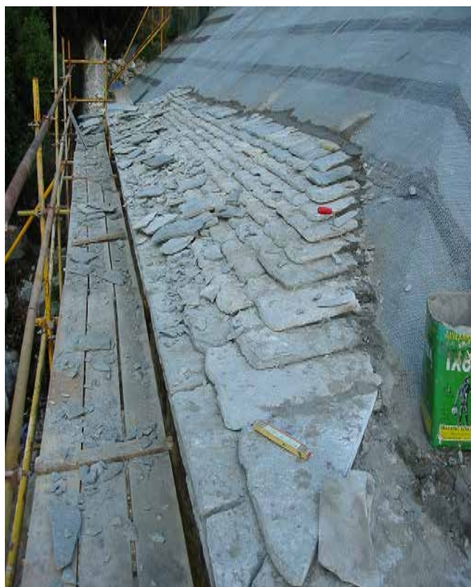
Εικόνα 5.63 Στάδια ανακατασκευής της στέγης του Πύργου
