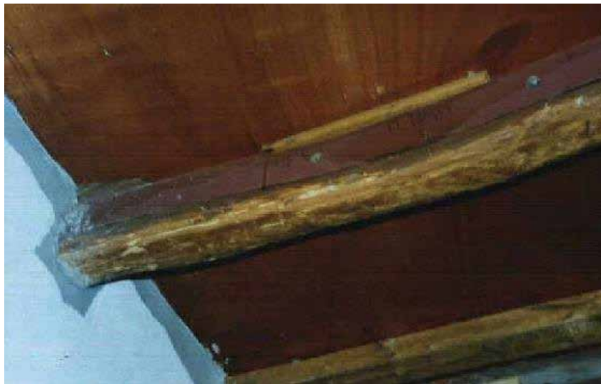
Εικόνα 4.1 Ενίσχυση δοκών με λάμες και επικάλυψη με εποξειδικό στόκο
