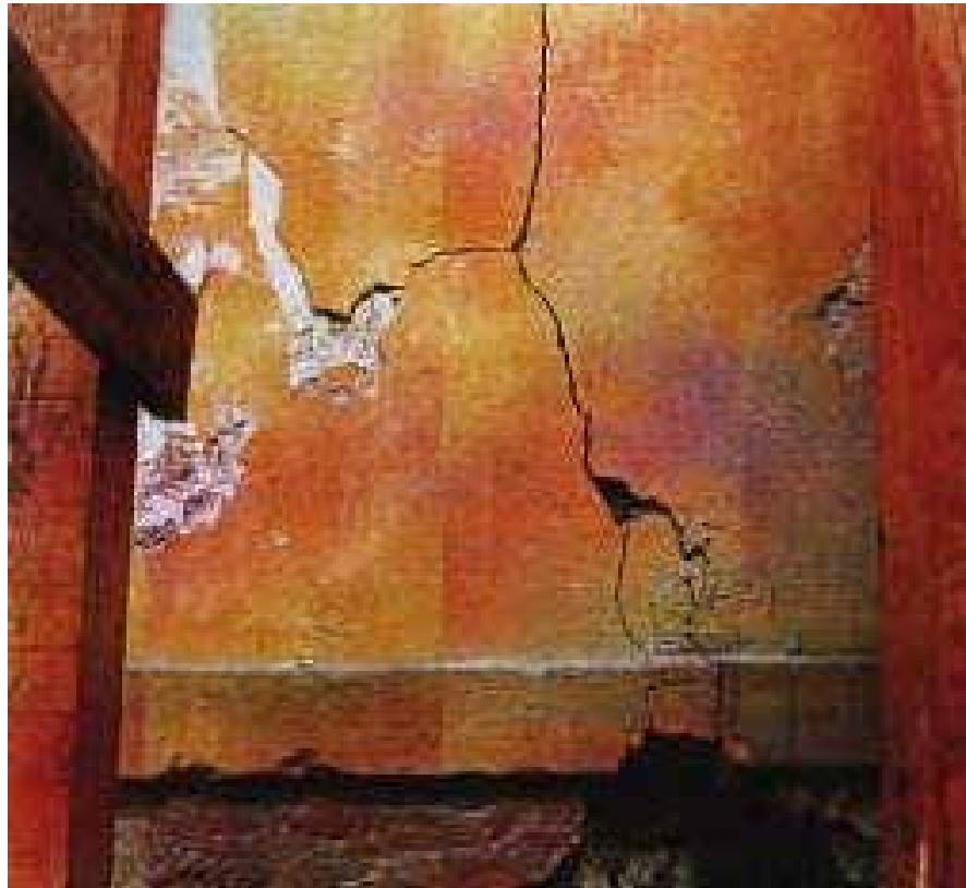
Εικόνα 4.8 Ρηγμάτωση τοιχοποιίας
