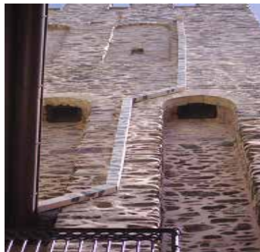
Εικόνα 5.49 Καταχύστρες και συλλεκτήρες απορροής
