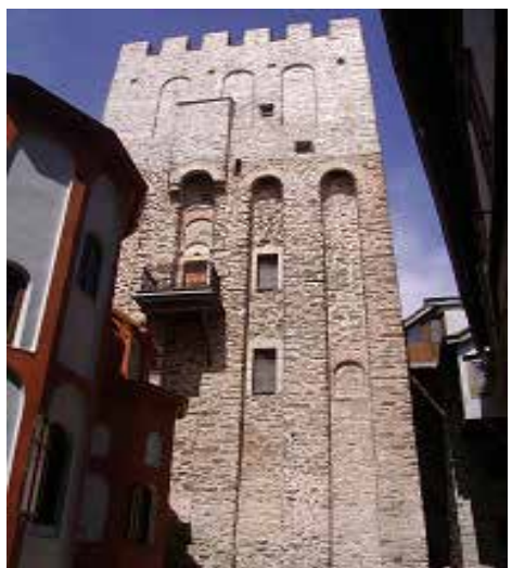
Εικόνα 5.44 Όψη Του Πύργου
