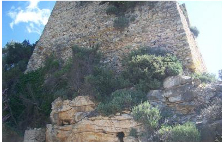
Εικόνα 5.8 Η θεμελίωση πάνω στο βραχώδες ανάψωμα
