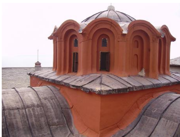
Εικόνα 3.6 Η κόκκινη επιχρισμένη τοιχοποιία του Καθολικού της Ι.Μ.Διονυσίου
