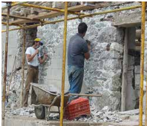
Εικόνα 5.60 Καθαίρεση όλων των ανεπιθύμητων επιχρισμάτων
