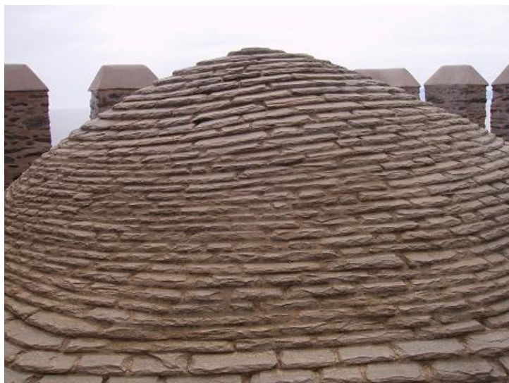
Εικόνα 5.51 Η στέγη του πύργου
