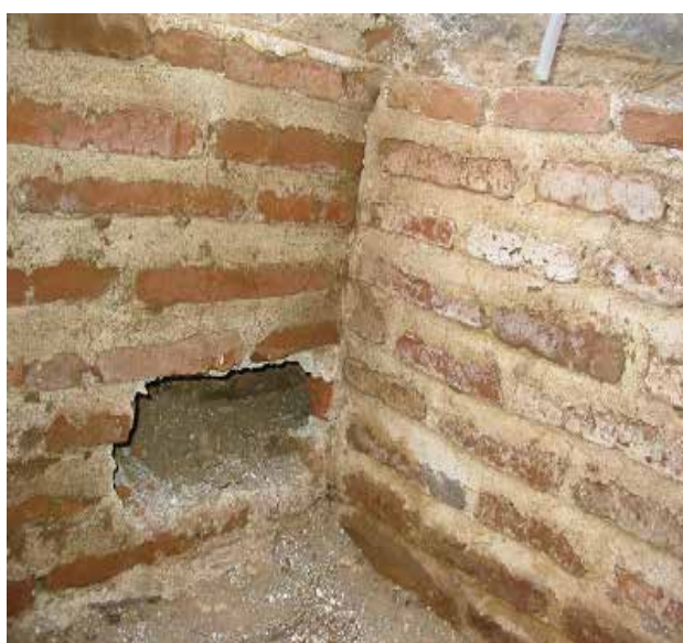
Εικόνα 5.59 Αντικατάσταση αποσαθρωμένων Πλίνθων
