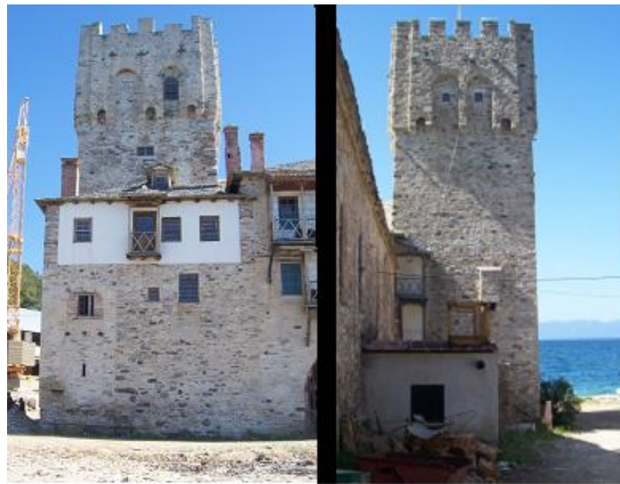
Εικόνα 5.29 Η νότια και η βόρεια όψη του πύργου του αρσανά.
