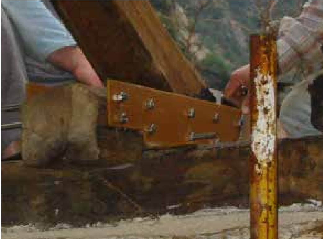
Εικόνα 4.2 Λεπτομέρεια συνδέσης ξευκτού με μεταλλική λάμα
