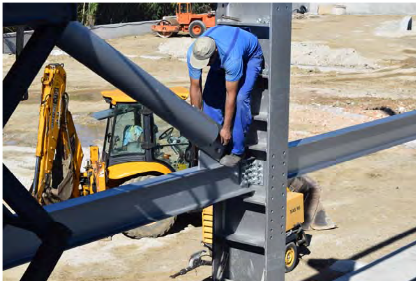
Εικόνα 10: Εργοταξιακή κοχλιωτή σύνδεση – Προσωπικό Φωτογραφικό Αρχείο
