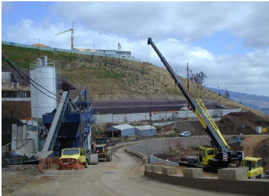
Εικόνα 9 Εργοτάξιο αμμοληπτικής εταιρείας σε αγροτική περιοχή της Θεσσαλονίκης
