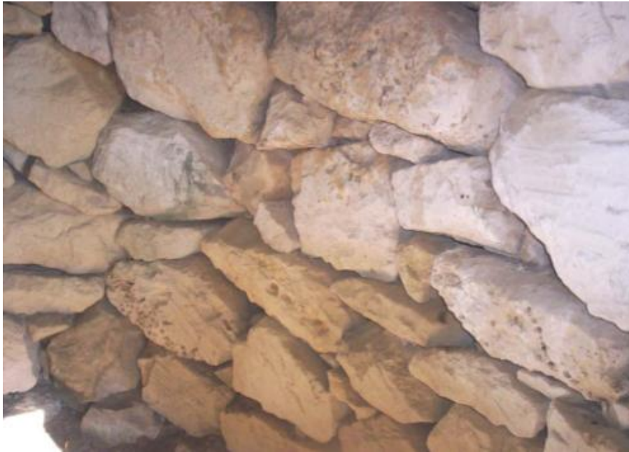
Εικόνα 15 Τμήμα του περιμετρικού τοίχου εσωτερικά. Διακρίνονται οι αργοί λίθοι και η απουσία κονιάματος ανάμεσά τους 29
