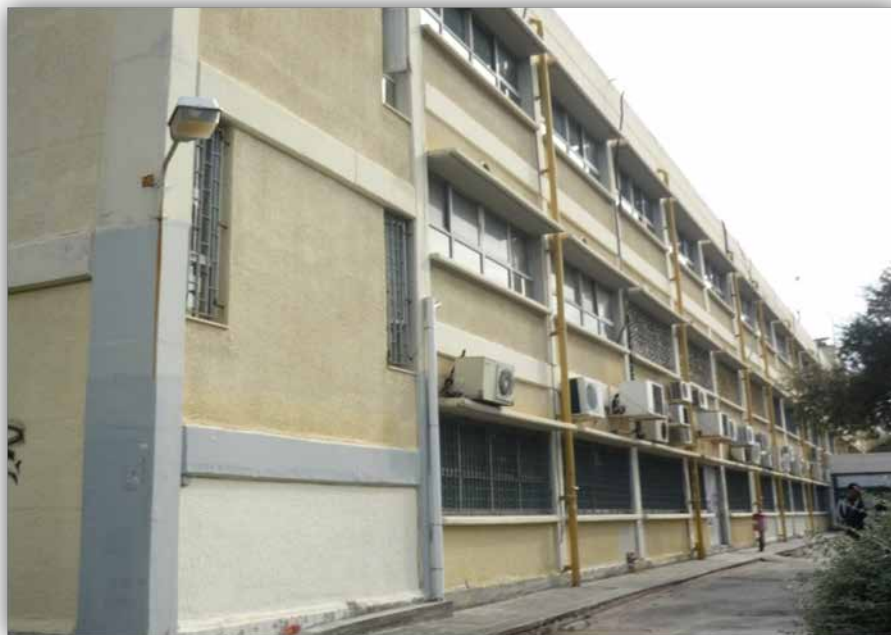
Εικόνα 2 : Νότια Όψη κτιρίου Δ2 (φωτογραφία: Ουζούνογλου Κωνσταντίνα)
