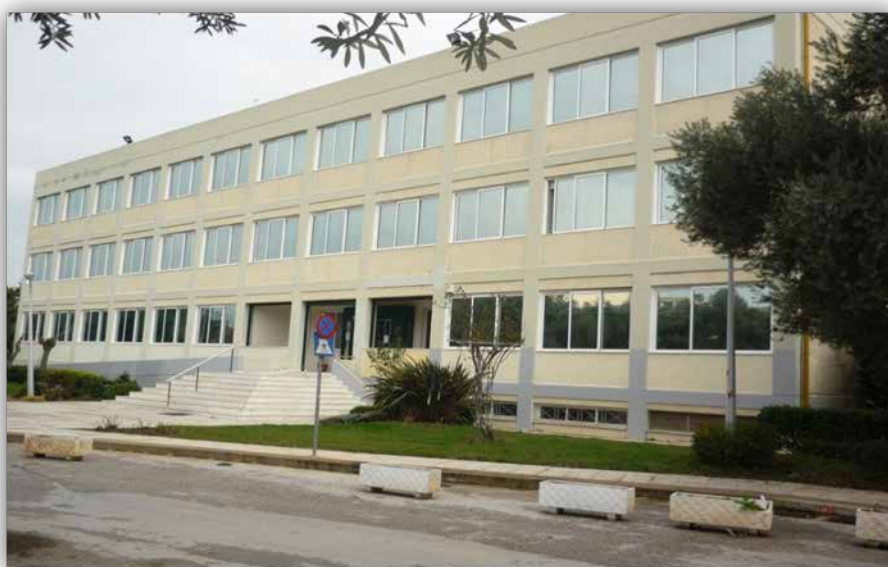
Εικόνα 5 : Νότια Όψη κτιρίου Β (φωτογραφία: Ουζούνογλου Κωνσταντίνα)
