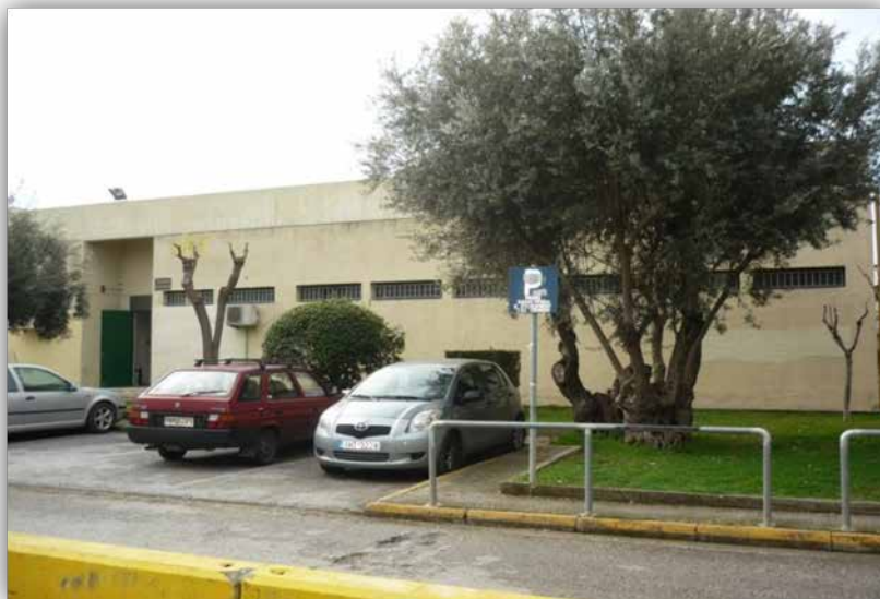
Εικόνα 4 : Βόρεια Όψη κτιρίου Ε (φωτογραφία: Ουζούνογλου Κωνσταντίνα)
