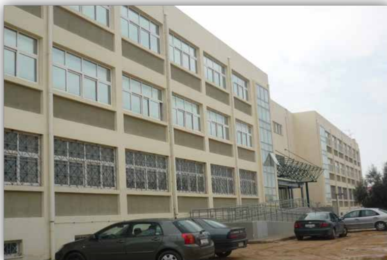
Εικόνα 9 : Δυτική Όψη κτιρίου Z (φωτογραφία: Ουζούνογλου Κωνσταντίνα)
