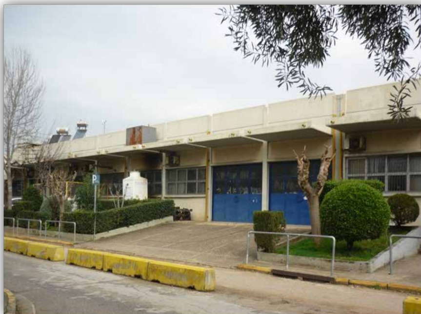
Εικόνα 3 : Νότια Όψη κτιρίου Δ3 (φωτογραφία: Ουζούνογλου Κωνσταντίνα)
