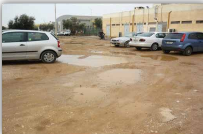
Εικόνα 1: Χώρος στάθμευσης μεταξύ των κτιρίων Ε και Ζ (φωτογραφία: Ουζούνογλου Κωνσταντίνα)
