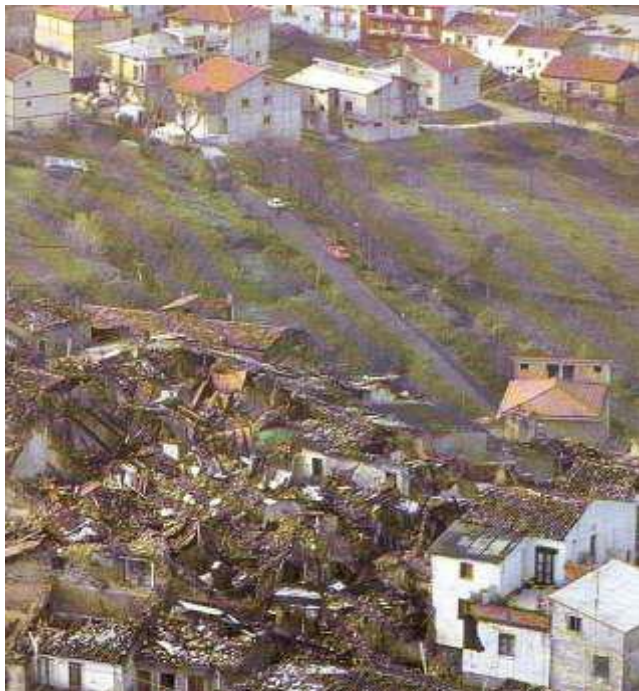
Εικ. 3. Κτίρια ισοπεδωμένα από το σεισμό του 1980 στην Τεόρα της Ιταλίας. Στην απέναντι ακριβώς πλευρά, τα κτίρια παραμένουν εντελώς ανέπαφα (Τουλιάτος 2012)
