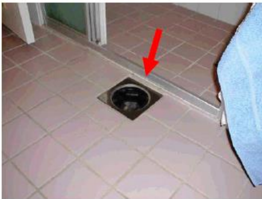
Σχήμα 10.1 Πάτωμα τουαλέτας με υποψία διαρροής νερού
