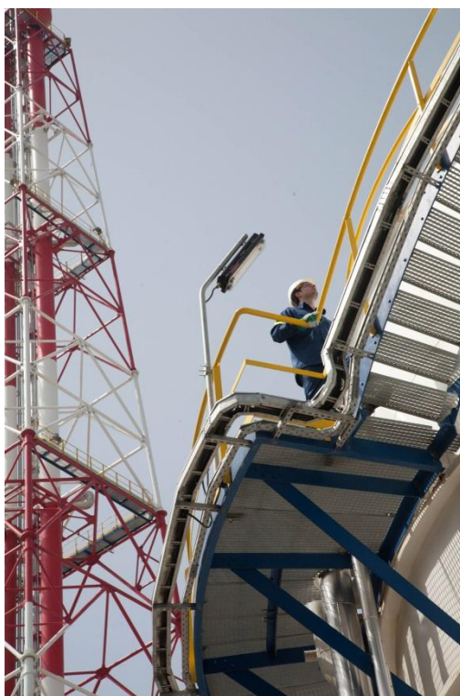
Εικ. 3.16 Εργασία σε ύψος σε χώρο διυλιστηρίου (πηγή: http://www.helpe.gr/media-center/media-gallery/ )
