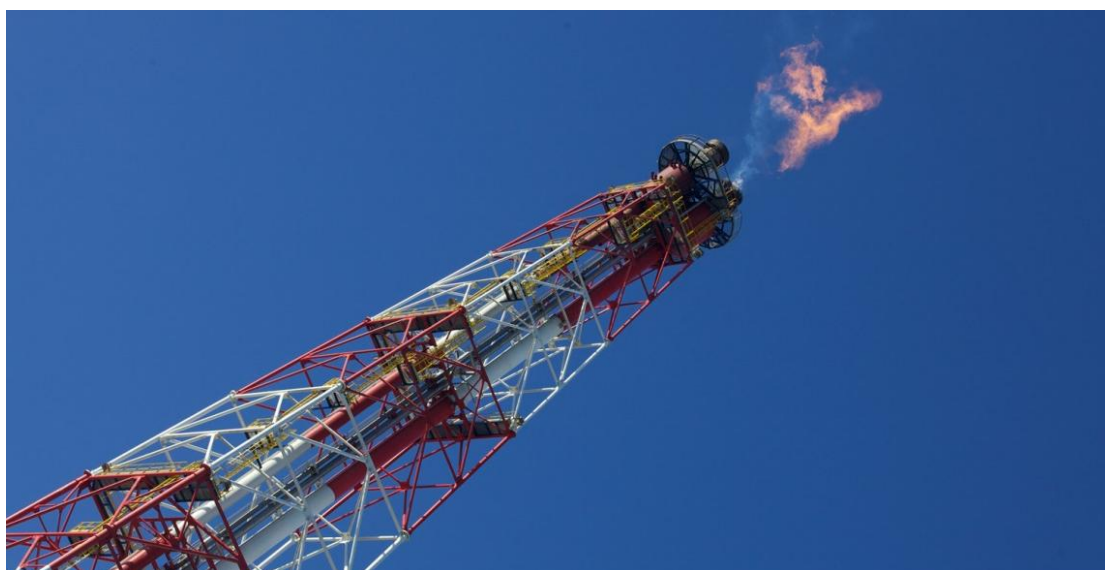
Εικ. 2.5 Πυρσός καύσης (πηγή: http://www.helpe.gr/media-center/media-gallery )
